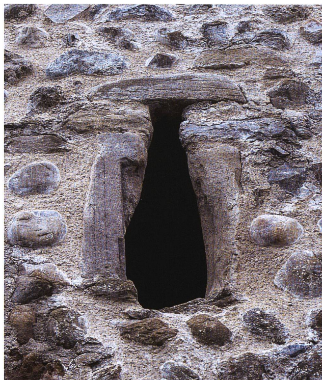
31: Häggenschwil SG, Ruine Alt Ramschwag. Turm. Schartenfenster 9.1 in der Mauer M9 des Erdgeschosses. Die beiden in der unteren Hälfte verbauten Sandsteinspolien und die Fensterbank sind von aussen her beschädigt. Möglicherweise wollte man sich so Zugang zum Turminnen verschaffen. Aufnahme 2024, von Südwesten.
