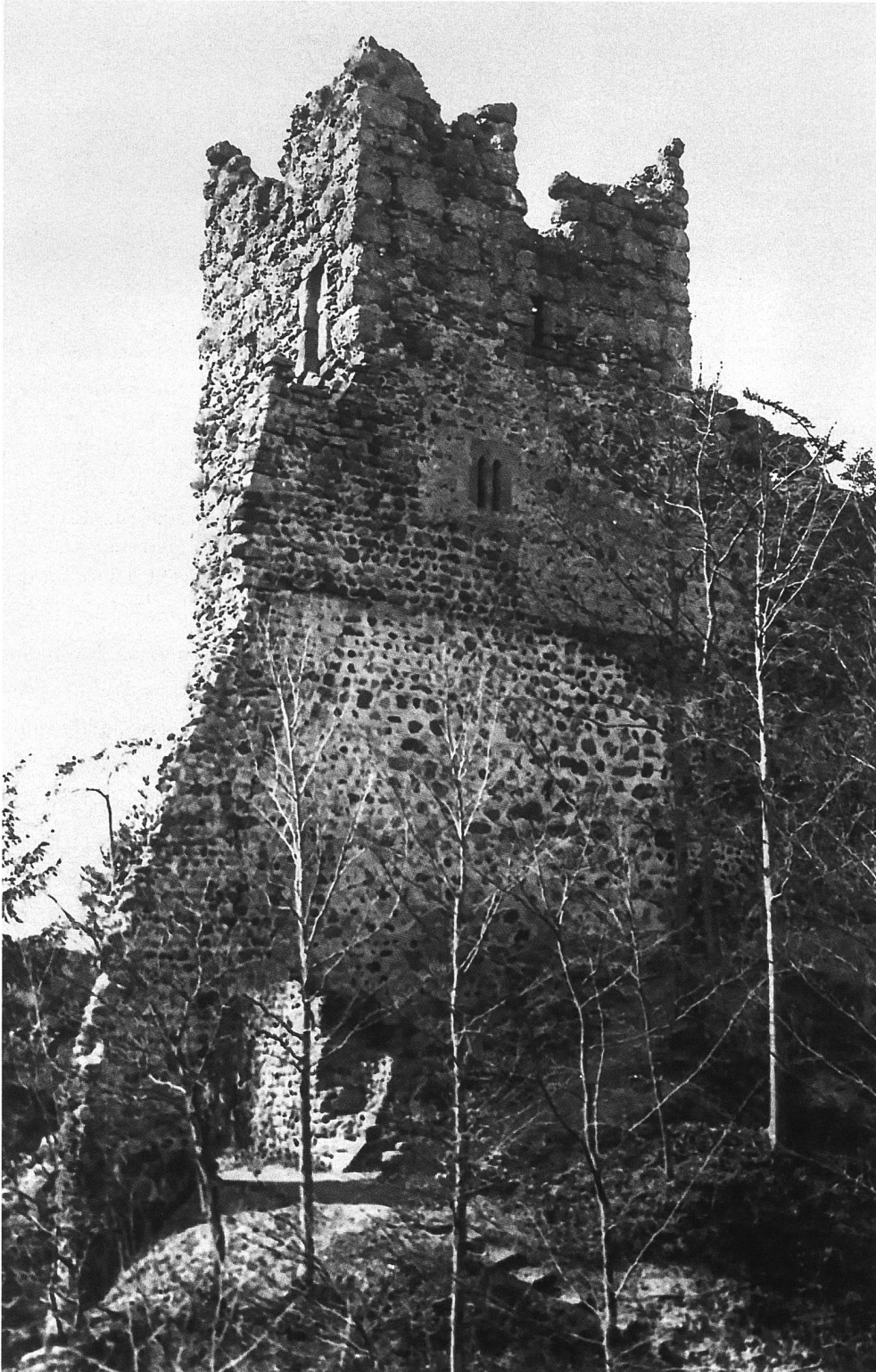
13: Häggenschwil SG, Ruine Alt Ramschwag. Turm und südwestlicher Teil der Schildmauer. Das Gewände des Tors ist ausgebrochen. An der Fassade der 1. Aufstockung SM3.1 der Schildmauer haftet ein grosser Putzfleck. Das schräg abgemauerte Ende des Mauerabschnittes SM1 ist am oberen noch ca. 3 m hoch erhalten. In der Südwestfassade des Turms sind der Austritt 9.5 und die untersten noch erhaltenen Gewändesteine der Öffnung 9.6 im 4. Obergeschoss zu erkennen. Aufnahme um 1900, von Südosten.
