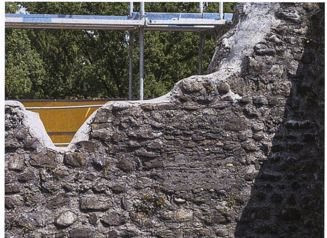
48: Häggenschwil SG, Ruine Alt Ramschwag. Turm. Öffnung 11.3, in der Innenfassade der Mauer M11, um 1930 zugemauert. Aufnahme 2022, von Südwesten.
