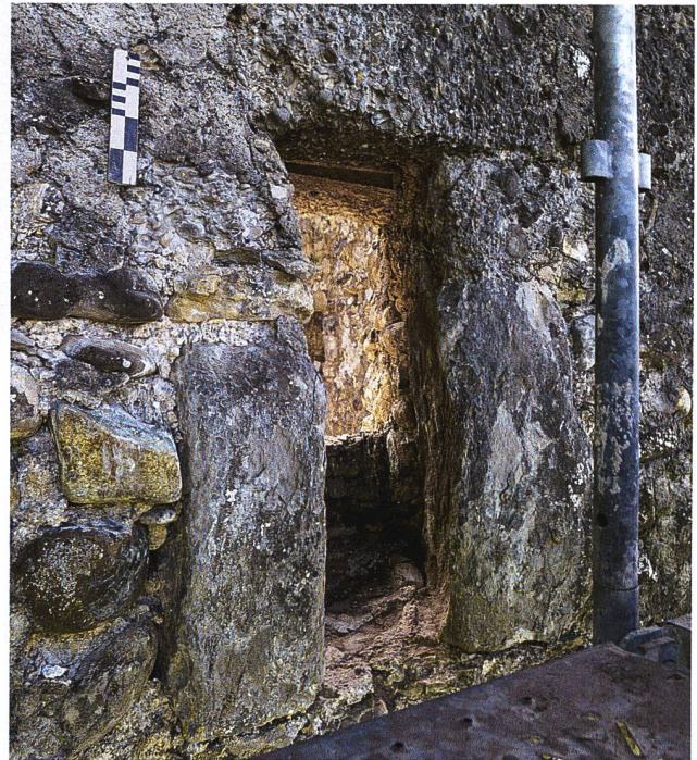
43: Häggenschwil SG, Ruine Alt Ramschwag, Turm. Hochrechteckiges Scharfenfenster 10.1, Aussenansicht. Das Gewände ist aus Sandstein- und Nagelfluhquadern zusammengesetzt. Aufnahme 2022, von Norden.
