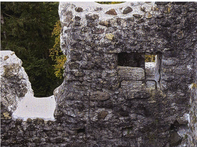
50: Häggenschwil SG, Ruine Alt Ramschwag. Turm. Öffnung 12.2, Innenansicht. Der ursprüngliche Verwendungszweck ist nicht bekannt. Um 1930 wurde das Ganze zu einem Nistkasten für Raubvögel umgebaut mit dem Mäuerchen 10.6 und dem Bügel aus einem Eisenrohr. Aufnahme 2024, von Nordwesten.
