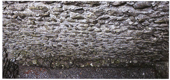
19: Häggenschwil SG, Ruine Alt Ramschwag. Blick von oben auf die in der Art eines Vorfundamentes vorspringende Abbruchkrone des inneren Mauermantels der Mauer M6 des 1. Vorgängerbaus VG1. Links krägt die Mauer noch deutlich um ca. 0,4 m vor, während sie auf der rechten Seite beinahe auf null ausläuft. Aufnahme 2024, von Südosten.
