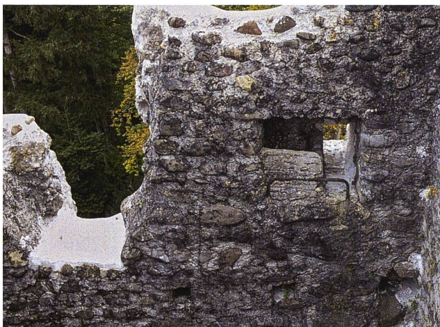
50: Häggenschwil SG, Ruine Alt Ramschwag. Turm. Öffnung 12.2, Innenansicht. Der ursprüngliche Verwendungszweck ist nicht bekannt. Um 1930 wurde das Ganze zu einem Nistkasten für Raubvögel umgebaut mit dem Mauerchen 10.6 und dem Bügel aus einem Eisenrohr. Aufnahme 2024, von Nordwesten.
