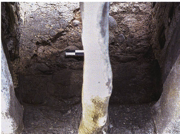
40: Häggenschwil SG, Ruine Alt Ramschwag. Turm. Bifore 1.2, Fensterbank. Die Qualität und Farbe des Sandsteins unterscheiden sich vom Rest des Gewändes. Der in die Bank eingehauene Sims passt in seinen Abmessungen nicht zum Gewände. Im Hintergrund sind noch Reste des auf der Fensterbank aufgetragenen Mörtelglattstrichs zu sehen. Aufnahme 2022, von Südosten.
