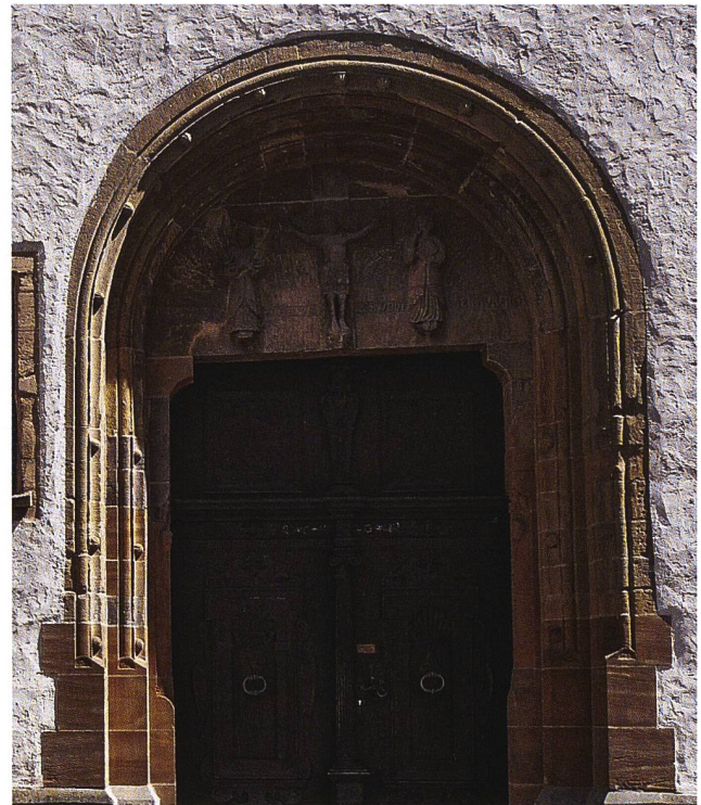
36: Engen, Landkreis Konstanz, BRD. In der spätroma- nischen Pfarrkirche Unserer Lieben Frau ist ein zweifach getrepptes Rundbogenportal erhalten. Hier setzen die beiden äusseren Stufenkanten über einem zwei Werksteine hohen Sockel an.
