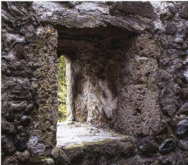
39: Häggenschwil SG, Ruine Alt Ramschwag. Turm. Bifore 1.2, Innenansicht. Vollständig erhaltenes inneres Gewände aus Tuffsteinquadern und einer sandsteinernen Sturzplatte. Aufnahme 2024, von Norden.
