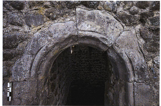
33: Häggenschwil SG, Ruine Alt Ramschwag. Turm. Hoch- eingang 9.2, Aussenansicht. Aus vier Werkstücken zu- sammengesetzter Rundbogen. Die Oberfläche des linken Scheitelsteins ist fast vollständig zerstört. Seine Unterseite wurde zusammen mit einem Teil des links daran ansetzen- den Steins um 1930 mit Zementmörtel nachprofiliert. Aufnahme 2022, von Südwesten.
