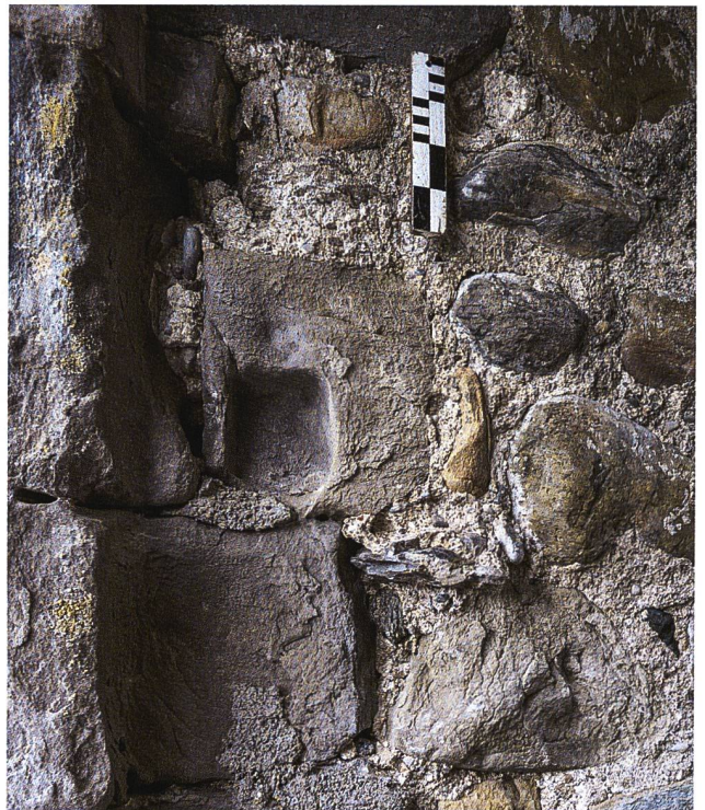
34: Häggenschwil SG, Ruine Alt Ramschwag. Turm. Hoch- eingang 9.2, Sandsteinquader in der linken Leibung mit Raste für den Schiebebalken. Aufnahme 2022, von Nord- osten.
