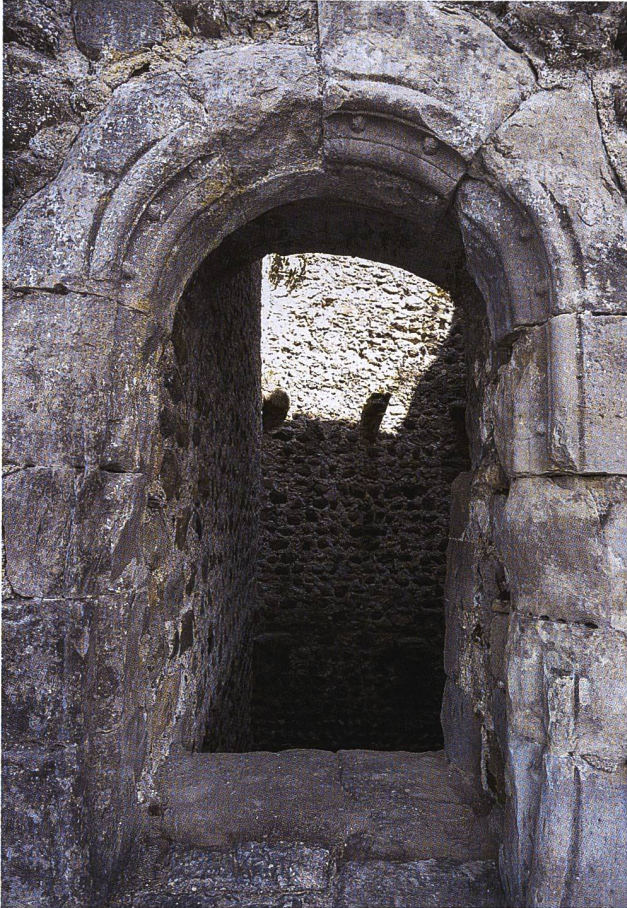
32: Häggenschwil SG, Ruine Alt Ramschwag. Turm. Hoch- eingang 9.2, Aussenansicht. Das vermutlich in Zweitver- wendung eingesetzte Gewände ist aus 12 unterschiedlich gut erhaltenen, profiliert behauenen und teilweise mit Rosetten verzierten Sandsteinquadern zusammengesetzt. Aufnahme 2022, von Südwesten.
