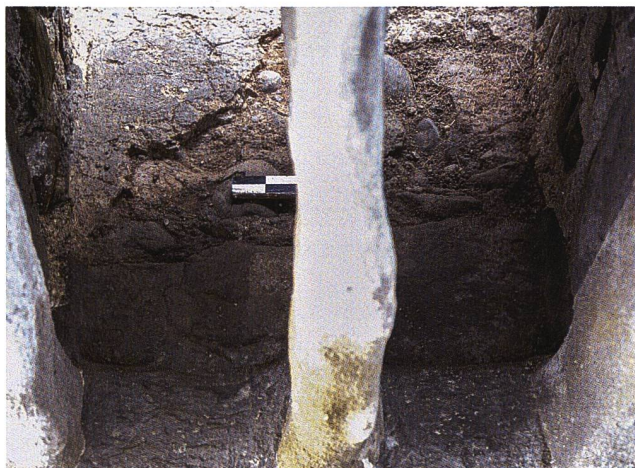
40: Häggenschwil SG, Ruine Alt Ramschwag. Turm. Bifore 1.2, Fensterbank. Die Qualität und Farbe des Sandsteins unterscheiden sich vom Rest des Gewändes. Der in die Bank eingehauene Sims passt in seinen Abmessungen nicht zum Gewände. Im Hintergrund sind noch Reste des auf der Fensterbank aufgetragenen Mörtelglattestrichs zu sehen. Aufnahme 2022, von Südosten.
