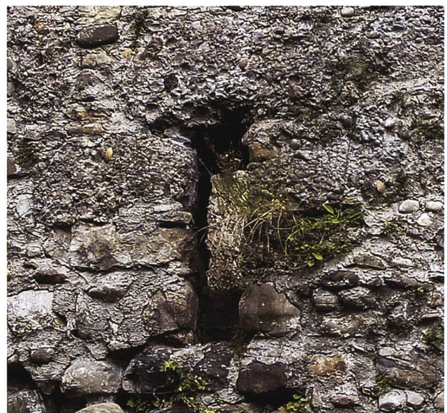
46: Häggenschwil SG, Ruine Alt Ramschwag, Turm. Hochrechteckiges Schartenfenster 12.1, äusseres Gewände aus unterschiedlichen Steinmaterialien zusammengesetzt. Aufnahme 2016, von Südosten.
