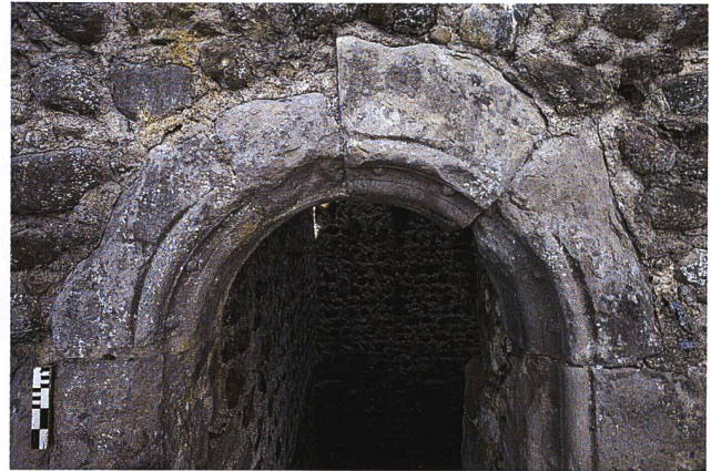
33: Häggenschwil SG, Ruine Alt Ramschwag. Turm. Hochengang 9.2, Aussenansicht. Aus vier Werkstücken zusammengesetzter Rundbogen. Die Oberfläche des linken Scheitelsteins ist fast vollständig zerstört. Seine Unterseite wurde zusammen mit einem Teil des links daran ansetzenden Steins um 1930 mit Zementmörtel nachprofiliert. Aufnahme 2022, von Südwesten.
