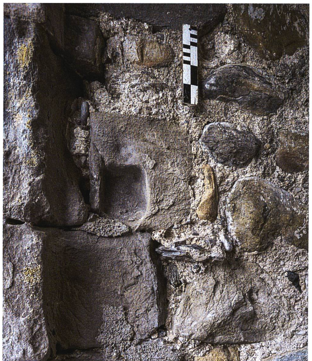
34: Häggenschwil SG, Ruine Alt Ramschwag. Turm. Hochengang 9.2, Sandsteinquader in der linken Leibung mit Raste für den Schiebebalken. Aufnahme 2022, von Nordosten.
