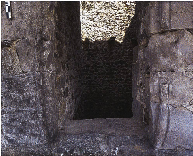
35: Häggenschwil SG, Ruine Alt Ramschwag. Turm. Hoch- ingang 9.2, Leibungen des äusseren Gewändes. Beachtens- wert ist, dass die Profilierung der Gewändesteine ohne Sockel direkt auf der Schwelle ansetzt. Aufnahme 2022, von Südwesten.
