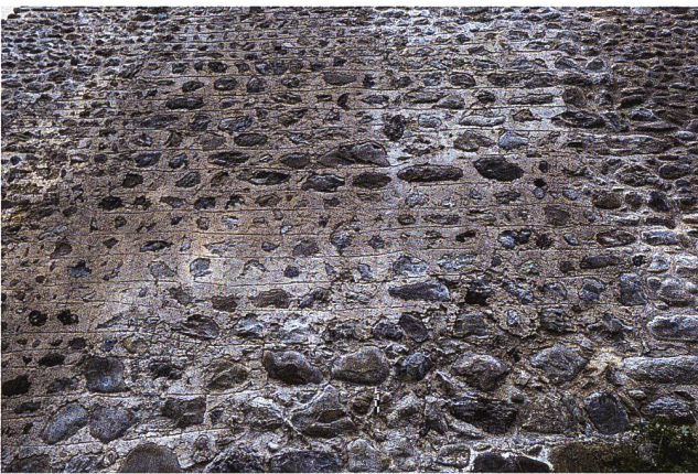
8: Häggenschwil SG, Ruine Alt Ramschwag. Schildmauer Aussenfassade. Mauerabschnitt SM1 mit qualitativem Rasa-Pietra-Platz mit Fugenstrich 1.17. Aufnahme 2024, von Südosten.
