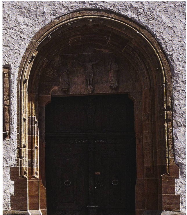
36: Engen, Landkreis Konstanz, BRD. In der spätromantischen Pfarrkirche Unserer Lieben Frau ist ein zweifach getrepptes Rundbogenportal erhalten. Hier setzen die beiden äusseren Stufenkanten über einem zwei Werksteine hohen Sockel an.
