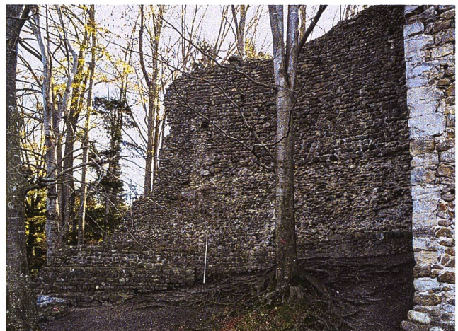
12: Häggenschwil SG, Ruine Alt Ramschwag. Innenfassade der Schildmauer (Profil P2). Blick auf die mehrfach ausgebesserte Fassade mit dem horizontalen Streifen an offen liegendem Kernmauerwerk des Mauerabschnitts SM2. Drei Viertel des darüber aufgehenden Innenmantels des Mauerabschnitts SM3.2 wurden um 1930 wiederaufgeführt. Aufnahme 2013, von Westen.
