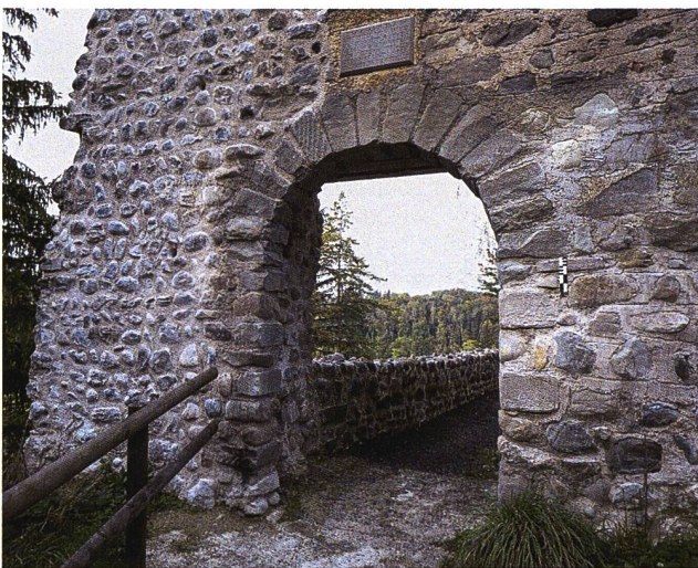
30: Häggenschwil SG, Ruine Alt Ramschwag. Tor, Aussenansicht. Der aus grob behauenen Sandsteinquadern bestehende Bogen wurde um 1930 rekonstruiert. Aufnahme 2024, von Südosten.
