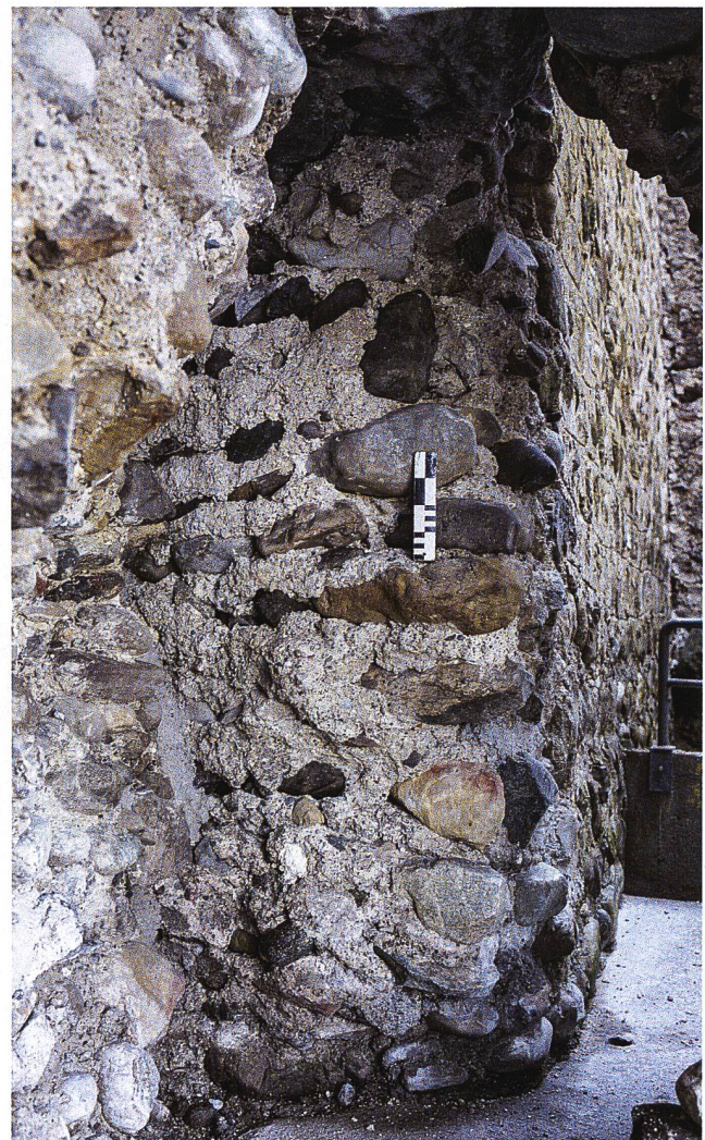
9: Häggenschwil SG, Ruine Alt Ramschwag. Turm: Bresche 11.1 und Abbruch des Schildmauerabschnitts SM1. Aufnahme 2022, von Nordosten. Oben: Grundrisssskizze der Befunde in der Bresche 11.1.
