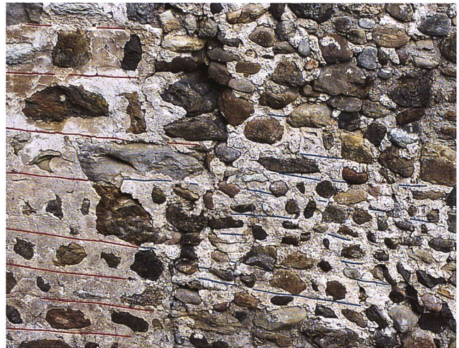
11: Häggenschwil SG, Ruine Alt Ramschwag. Mittlerer Abschnitt der Fuge 1.16 in der Aussenfassade der Schildmauer. Deutlich zu erkennen ist, dass die mit Fugenstrichen versehenen RASA-PIETRA-PUTZE auf den Schildmauerabschnitten SM1 (rot markiert) und SM2 (blau markiert) nacheinander aufgetragen worden sind. Drohnenaufnahme 2016, von Südosten.
