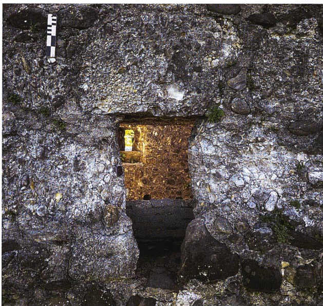
42: Häggenschwil SG, Ruine Alt Ramschwag, Turm. Hochrechteckiges Scharfenfenster 9.4, Aussenansicht. Oberflächlich sind die wetterseitig exponierten Gewändesteine in den Leibungen, mit Ausnahme des Urgesteins links unten, stark abgewittert. Aufnahme 2022, von Norden. Aufnahme 2022, von Südwesten.
