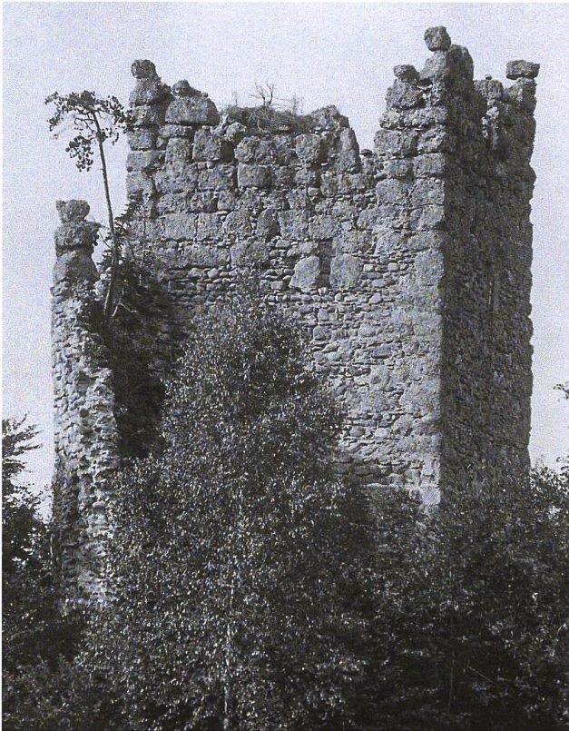
47: Häggenschwil SG, Ruine Alt Ramschwag. Aufnahme von Schildmauer und Turm um 1900. Auf der Schildmauer sind noch Reste der 2. Aufstockung SM4 aus Nagelfluhquadern vorhanden. In der Mauer M11 des Turms sind das Schartenfenster 11.2 im 3. Obergeschoss und die Öffnungen 11.3 und 11.4 im 4. Obergeschoss zu erkennen. Aufnahme um 1900, von Nordosten.
