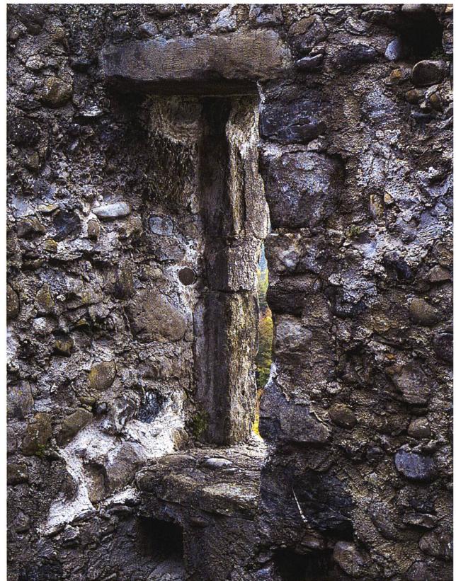
41: Häggenschwil SG, Ruine Alt Ramschwag. Turm. Austritt 9.5, Innenansicht. Die Schwelle und das linke Balkenloch 9.10 wurden um 1930 rekonstruiert. Das rechte Balkenloch ist original erhalten. Das äussere im Bild sichtbare südöstliche Gewände besteht aus unterschiedlich stark abgewitterten Sandsteinen. Die Oberfläche des inneren Sturzsteins wurde um 1930 mit Flickmörtel überzogen – erkennbar an den darin vorhandenen Pinselspuren. Aufnahme 2024, von Norden.
