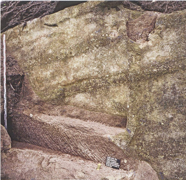
18: Melchnau, Burgruine Langenstein. Nördliche Balkengrube im Torweg und Auflagefläche für den Bohlenbelag. Blick nach Norden.
