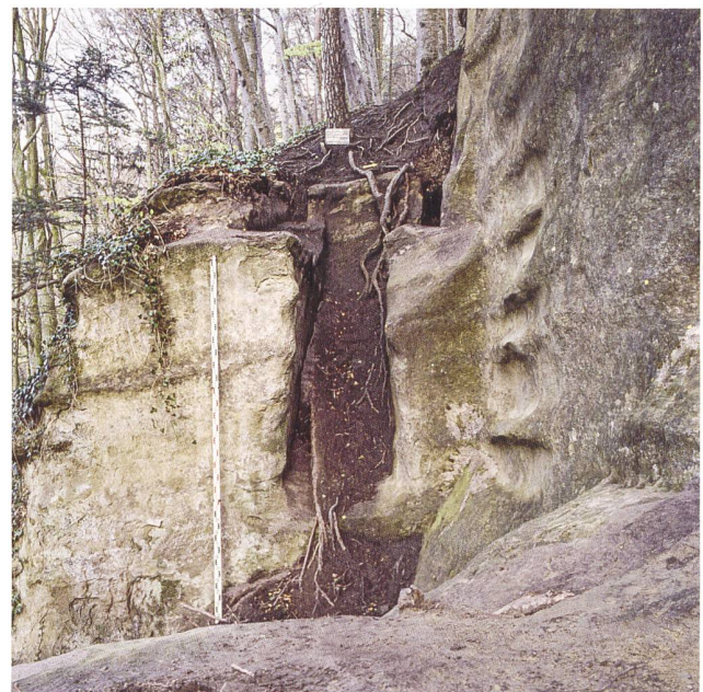
17: Melchnau, Burgruine Langenstein. Blick auf die Schwingbalkengrube und an die Balkengrube für die beiden Konsolbalken im Torweg. Blick nach Westen.
