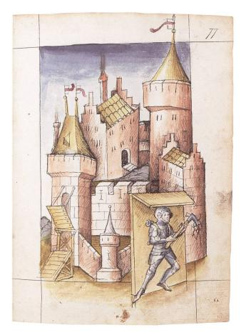
13: Konrad Kyeser, Bellifortis, Feuerwerkerbuch, um 1420, BNF Latin 17873 fol. 77r. Der runde hintere Kopfbalken der Zugbrücke wird von zwei hölzernen, aus der Mauer kragenden Konsolbalken gestützt. Diese werden aufgrund der hohen Punktlast von einer Ständerkonstruktion abgefangen, die auf der Grabensohle steht. Zwei Kreuzstreben versteifen die Konstruktion zusätzlich.
