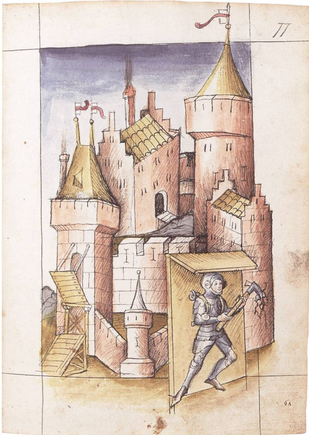
13: Konrad Kyeser, Bellifortis, Feuerwerkerbuch, um 1420, BNF Latin 17873 fol. 77r. Der runde hintere Kopfbalken der Zugbrücke wird von zwei hölzernen, aus der Mauer kragenden Konsolbalken gestützt. Diese werden aufgrund der hohen Punktlast von einer Ständerkonstruktion abgefangen, die auf der Grabensohle steht. Zwei Kreuzstreben versteifen die Konstruktion zusätzlich.
