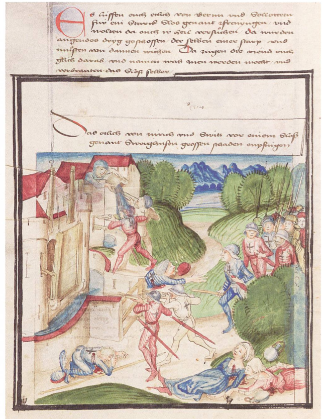
12: Diebold Schilling, Amtliche Berner Chronik. Darstellung einer Schwingbrücke bei der erfolglosen Belagerung der Burg Schweighausen. Mss.h.h.I.3 p. 38.
