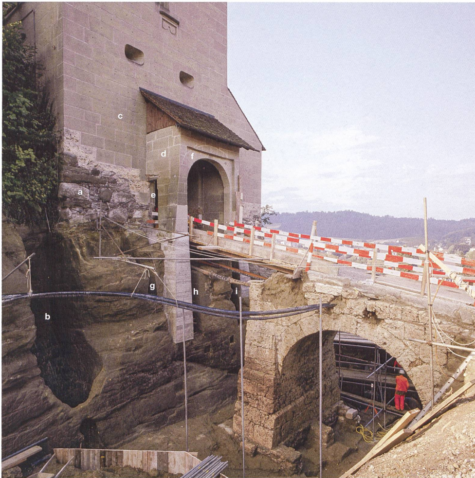
5: Burgdorf, Schloss. Dokumentation während der Sanierung 1982. a älterer Torturm mit Megalithmauerwerk. b Felsgraben zum Tor a. c Torturm von 1560. d Vorwerk von 1587. e Nebenpforte ins Vor- werk. f Torblende. g Schwingbalkengrube zu Nebenpforte e. h östliche Schwing- balkengrube. i westliche Schwingbalken- grube. Blick nach Südwesten.
