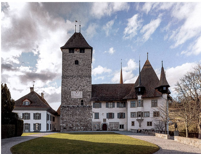
Schloss Spiez mit dem Wohnturm des mittleren 13. Jh. und dem gleichzeitigen, im 15. und im 17. Jh. stark umgestalteten Wohnbau (Foto ADB).
