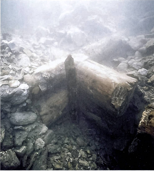
36: Stansstad NW, Wasserturm. Blockbaufundament verfüllt mit Steinen, März 1977.
