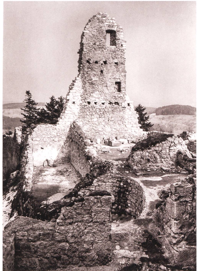
48: Blick gegen Nordosten auf das 1931 frisch restaurierte Amts- und Wohngebäude mit Nordmauer (M60). Im Vordergrund ist noch die 1939/1940 durch den Einbau des Artilleriebeobachtungspostens zerstörte Zisterne erkennbar.
