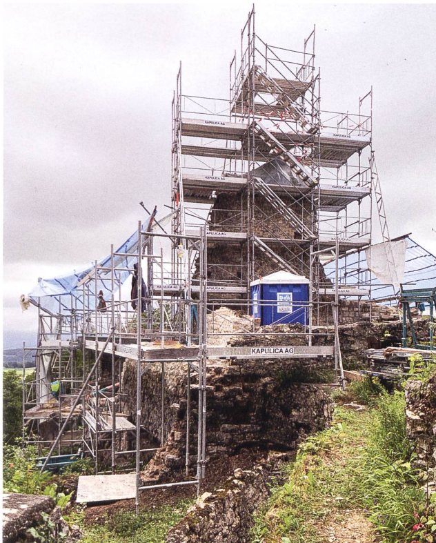
34: Die Nordwand des Amts- und Wohngebäudes im Vollgerüst: Das Giebfeld mit dem charakteristischen Rundbogenfenster musste wegen seines schlechten Zustandes abgebrochen werden.
