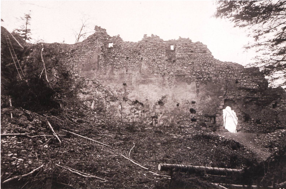
46: Innenseite der Ringmauer (M1) im Unteren Burghof Nord während der Freilegung der Anlage 1929/1930. Blick gegen Nordwesten.
