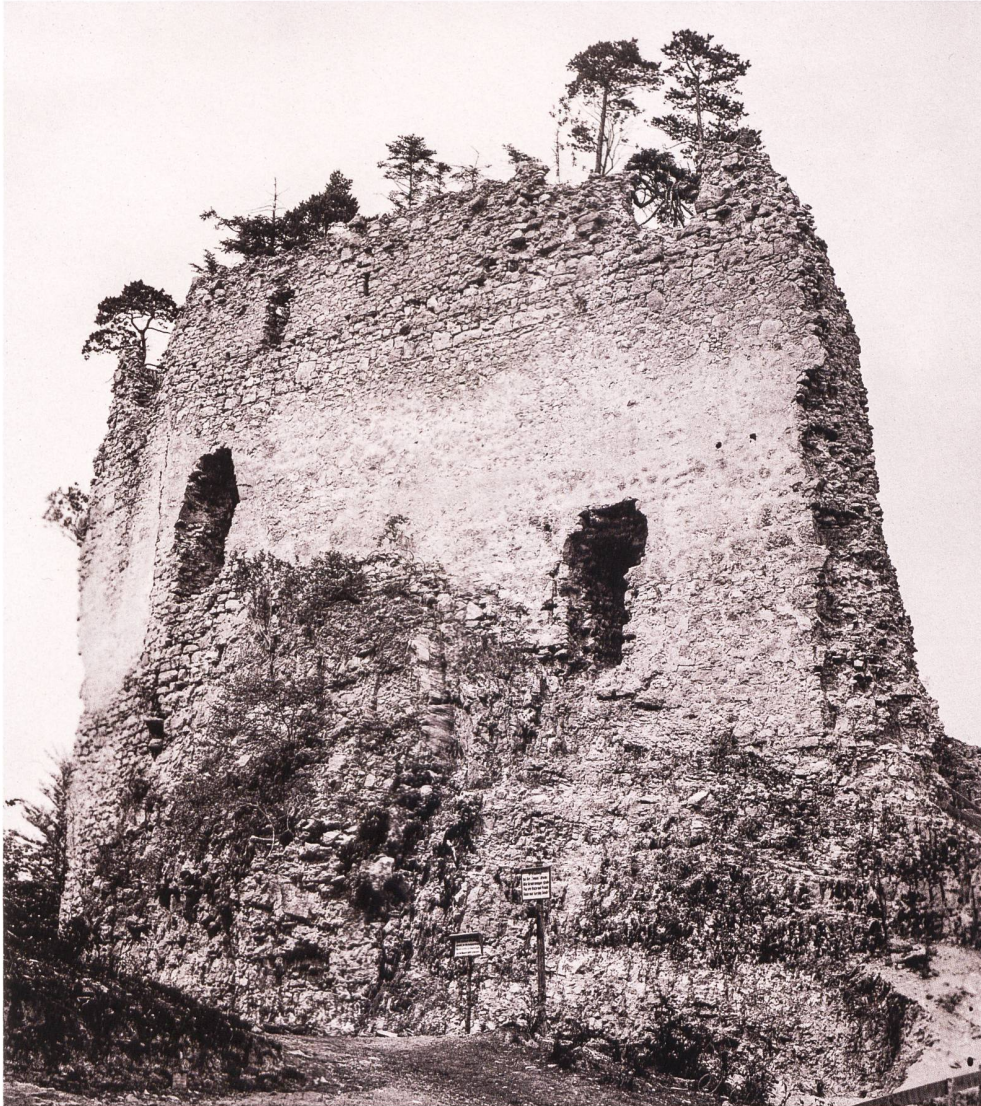
52: Blick gegen Nordwesten auf die Südfassade der Schildmauer (M2) vor der Restaurierung 1930/1931.
