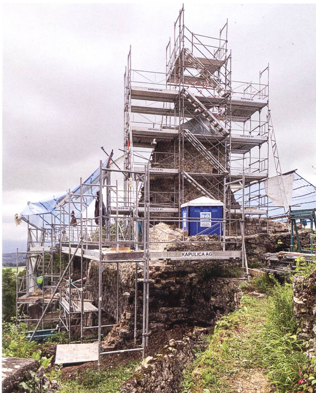
34: Die Nordwand des Amts- und Wohngebäudes im Vollgerüst: Das Giebelfeld mit dem charakteristischen Rundbogenfenster musste wegen seines schlechten Zustandes abgebrochen werden.
