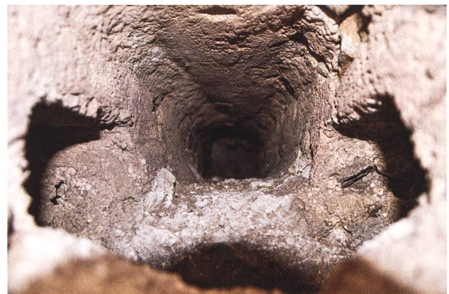
55: Blick in den Querbalkenkanal mit seitlich kreuzendem Längsbalkenkanal eines Holzbalkenrostes in der Schildmauer (M2) während der Sanierung 2019–2023. Gut erkennbar die Abdrücke der ehemaligen Eichenbalken sowie der stark gerötete Mauer Mörtel.
