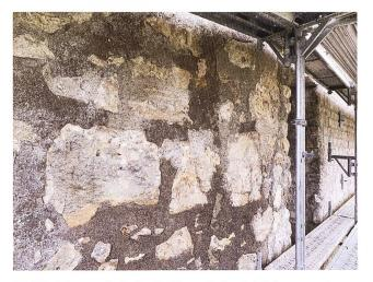
53: Die Mauerschale der Südfassade der Schildmauer mit grossen Hauptrogenbruchsteinen, die Zangenlöcher aufweisen. Zustand nach den Sanierungsarbeiten 2019–2023 und mit älterer Zementverfugung. Blick gegen Osten.
