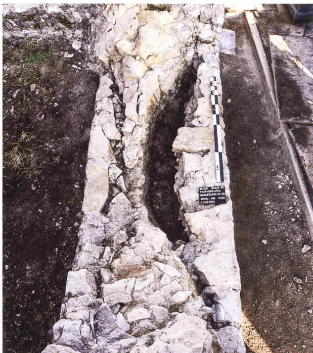
49: Die Feuernische in der Südfassade (M59) des Amts- und Wohngebäudes während der Sanierung 2019–2023. Blick gegen Nordwesten.
