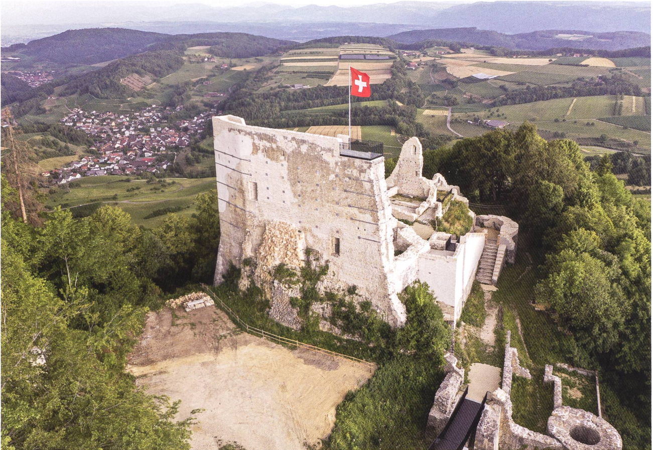
1: Hoch über dem Tafeljura mit Sicht in den Schwarzwald: die Farnsburg nach Abschluss der Sanierungsarbeiten im September 2023.
