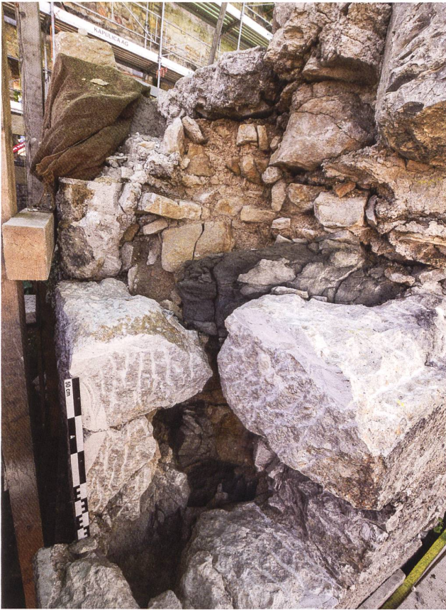
58: Der Eingang in den Keller Ost des Palas mit den aufgespitzten Kunststeingewänden der Restaurierung von 1931 während der Sanierung 2019–2023. Dahinter sind die Überreste des burgenzeitlichen Sandsteinportals erkennbar. Blick gegen Westen.
