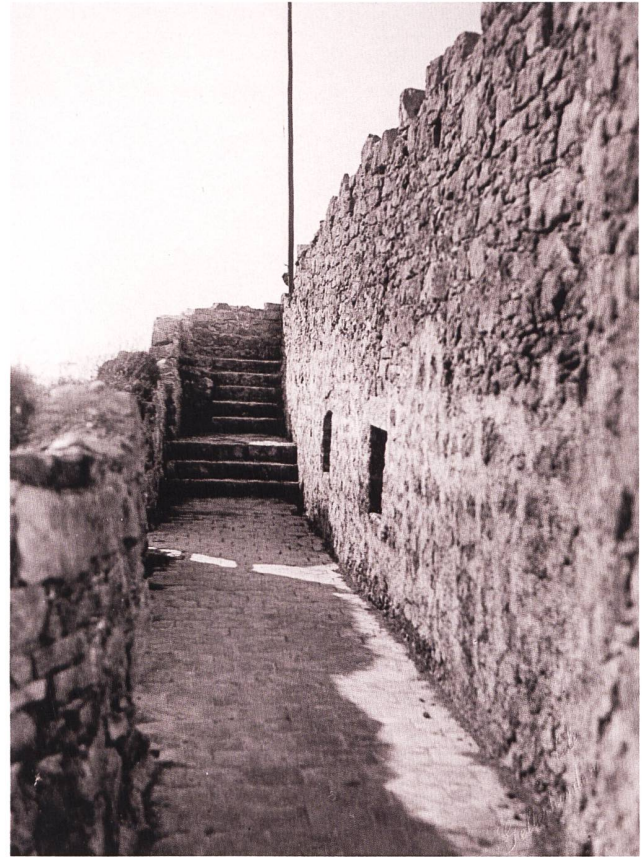
65: Der Wehrgang auf der Schildmuer (M2) kurz nach der Restaurierung 1930/1931. Beim oberen Treppenlauf ist links neben den Stufen ein älterer Mauer- bzw. Treppenblock zu sehen, der zur burgenzeitlichen Wehrgangerneuerung zählt. Blick gegen Südosten.
