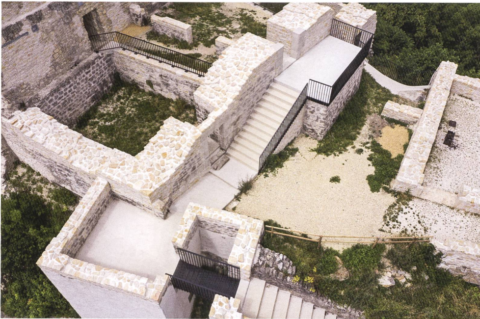
21: Neue Absturzsicherheiten im Bereich Pfisterhaus und Palas. Die Gehflächen wurden im Zuge der Sanierung in Beton, Kunststein oder Mergel ausgeführt.
