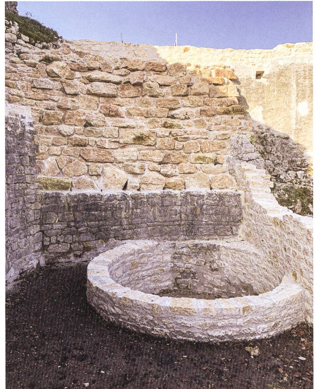
14: Die neue Felsvormauerung aus sogenanntem Gisibergstein im Brunnenhaus der Farnsburg. Sie dient künftig auch als Naturstandort für Flora und Fauna.
