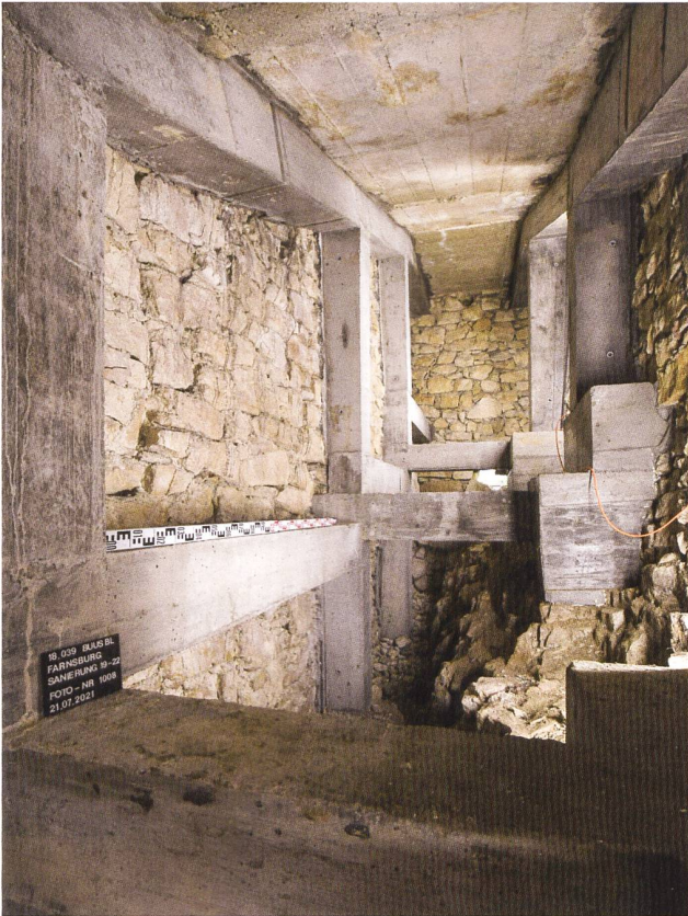
31: Der riesige Hohlraum unter der Langen Stiege mit dem neu errichteten Tragwerk aus Beton für die darüber liegende Treppe von 1931.
