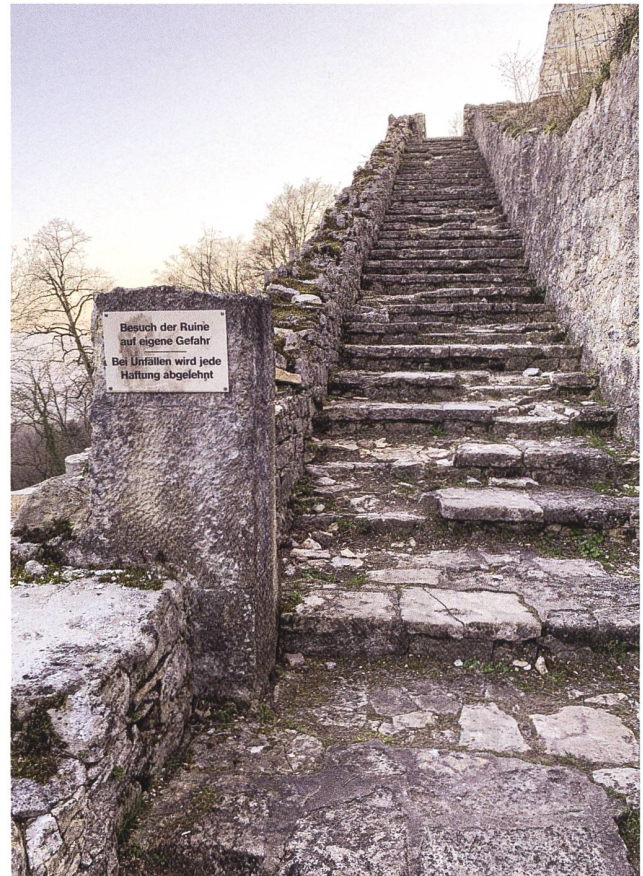
9: Die Lange Stiege im Jahr 2019 vor der Sanierung. Lose Steinplatten auf dem Treppenlauf sowie eine ungenügende Brüstungshöhe zeugen von der mangelnden Besuchersicherheit der Burgruine.
