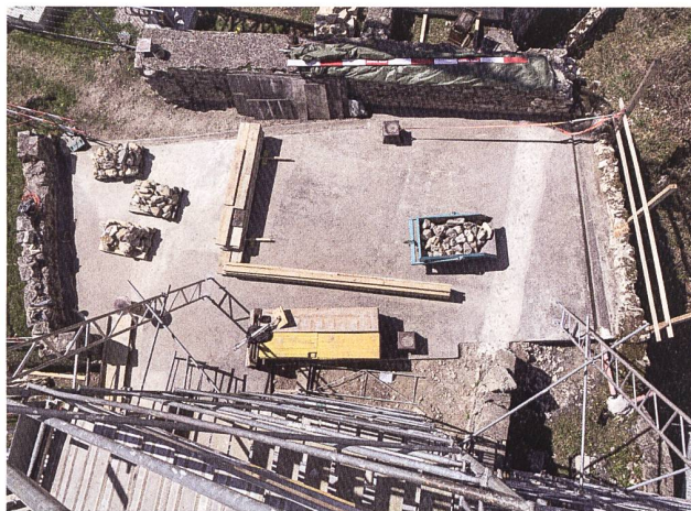
35: Aufgetaucht aus dem Untergrund: der für die Abdichtung der Betondecke wieder freigelegte Artilleriebeobachtungsposten aus dem Zweiten Weltkrieg in der Oberburg.
