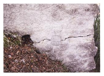
26: Ein im Jahre 2011 angebrachtes Zementsiegel an der Basis der Ringmauer (M1) im Unteren Burghof Nord wies bereits nach fünf Jahren Risse auf, welche auf die geologische Instabilität des Baugrundes zurückzuführen waren.
