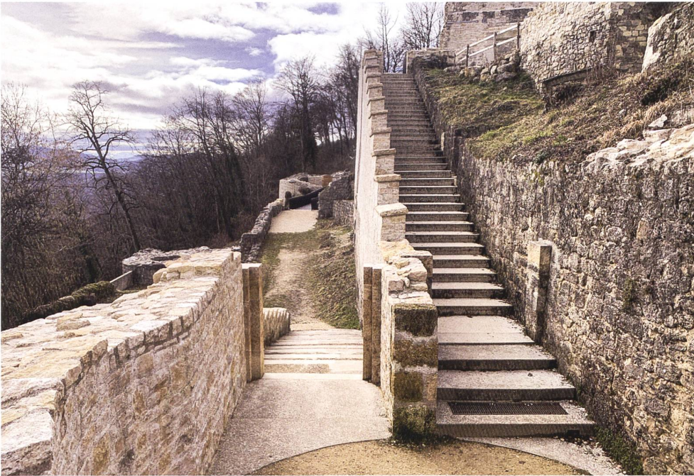
32: Auf wie einst zum Landvogt! Die wieder inszenierte Lange Stiege mit den neu eingebauten Kunststeinstufen, der getreptten Treppenbrüstung und im Vordergrund der Innenraum des Blauen Turms nach Abschluss der Sanierung.
