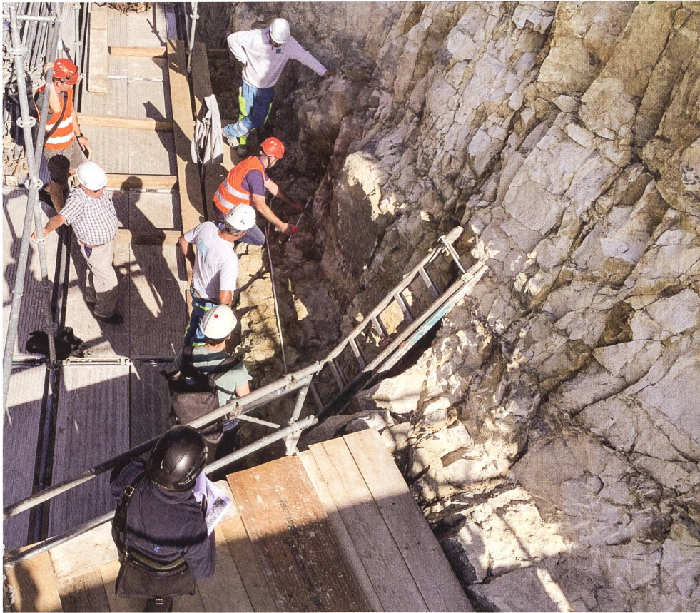
36: Jour fixe im Jahr 2022 am Fusse der Schildmauer: Unter Anleitung des Geologen Richard Waite wird die Foundation der geplanten Vormauerung definiert – deutlich erkennbar ist der tief verkarstete und verwitterte Fels.
