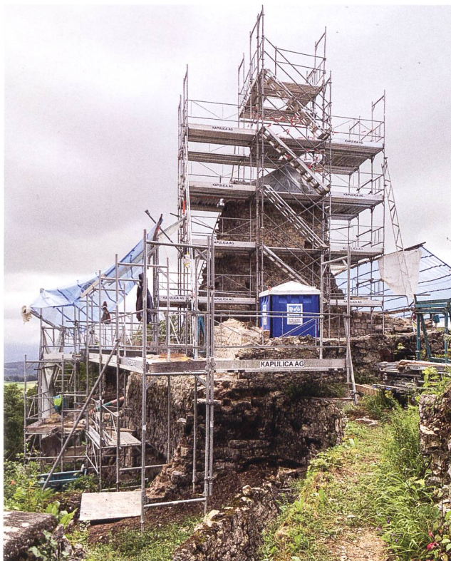
34: Die Nordwand des Amts- und Wohngebäudes im Vollgerüst: Das Giebelfeld mit dem charakteristischen Rundbogenfenster musste wegen seines schlechten Zustandes abgebrochen werden.
