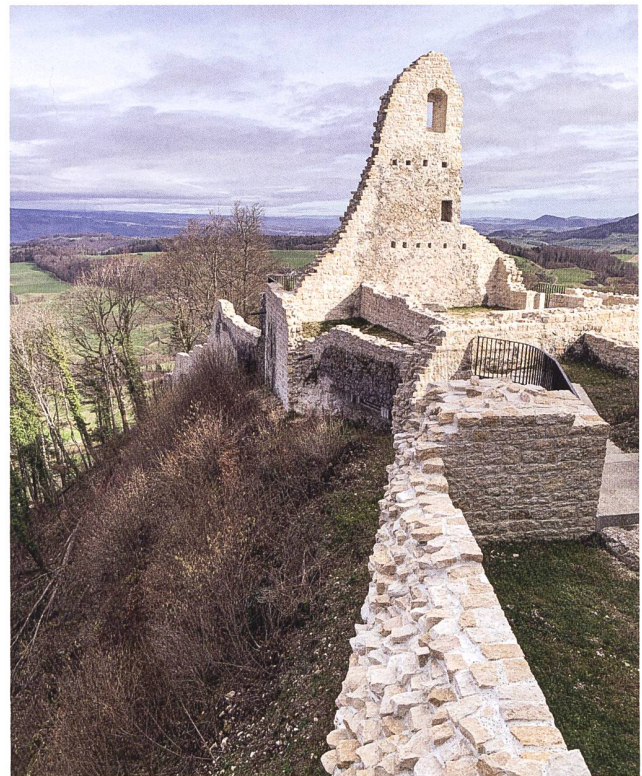
16: Für eine bessere Wahrnehmung des Befundes: Im Zuge der Sanierung neu ausgebildete Mauerzüge sollen den Ausbruch im Grundriss an der westlichen Flanke der Oberburg stärker betonen.
