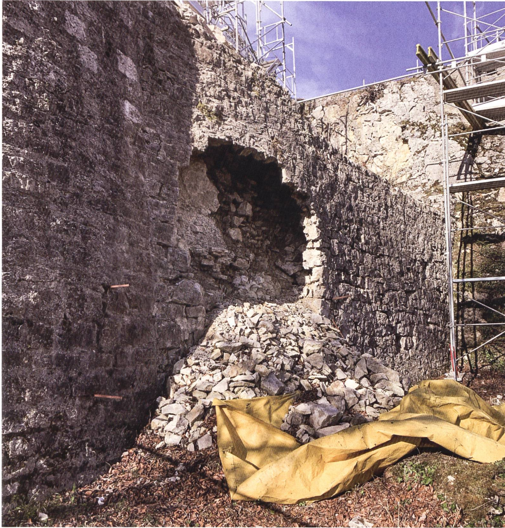
29: Die nördliche Abschlussmauer des Brunnenhauses vor der Sanierung mit einer aufgebrochenen Mauerschalenablösung infolge eingesickerten und gefrorenen Meteorwassers.
