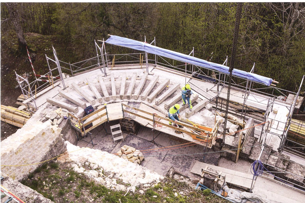
33: Eine weitere unkonventionelle bauliche Lösung: Aufsicht auf die Mauerkrone des Blauen Turms mit den radial verlegten vorfabrizierten Betonträgern vor ihrer Übermauerung.
