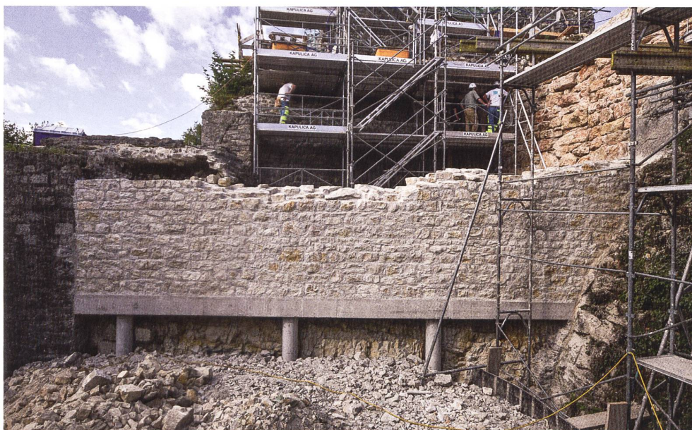
30: Eine innovative Sanierungsmassnahme an der neu erstellten Abschlussmauer des Brunnenhauses: Die neue Mauer steht auf einem Betonriegel über Betonstützen – eine Hilfskonstruktion, die danach mit Schutt angebösch wurde, um künftig den dahinterliegenden Fels frei entwässern zu können.
