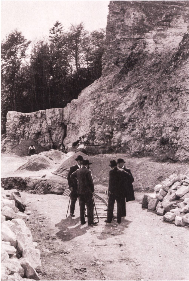
68: Besprechung während der Freilegungs- und Restaurierungsarbeiten 1930 im Unteren Burghof mit dem Bundesexperten Albert Naef und den Mitgliedern Ferdinand Bohny, Carl Roth und August Kamber des Farnsburgkomitees.
