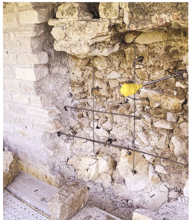
39: An der Südfassade der Schildmauer: Nach Abbruch der vom Frost zerstörten burgenzeitlichen Mauerschale wird das neu aufzuführende Mauerwerk mit Gewinde stangen mit dem Kern verbunden.
