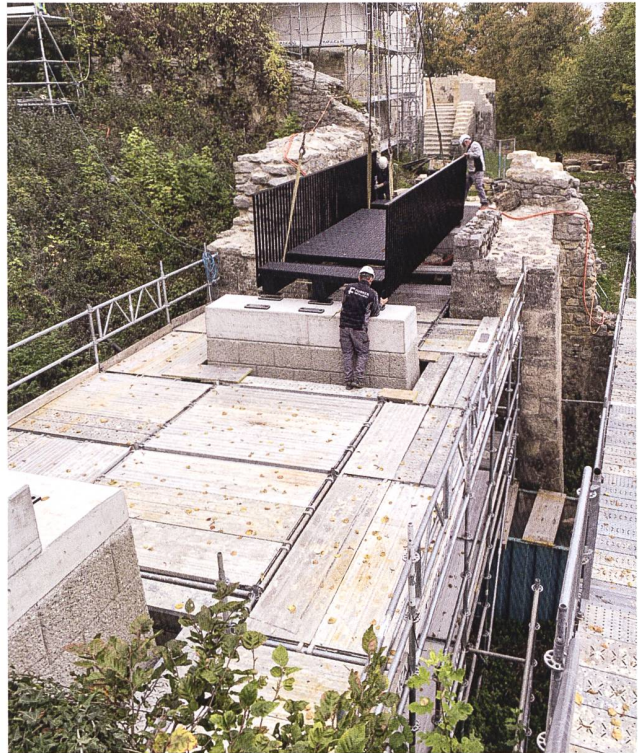
42: Einbau der nördlichen Hälfte der Brücke über den Burggraben mittels Pneukran. Im Gerüst erkennbar die neu aufgebauten Brückenaufleger aus Beton in Kunststeinoptik.
