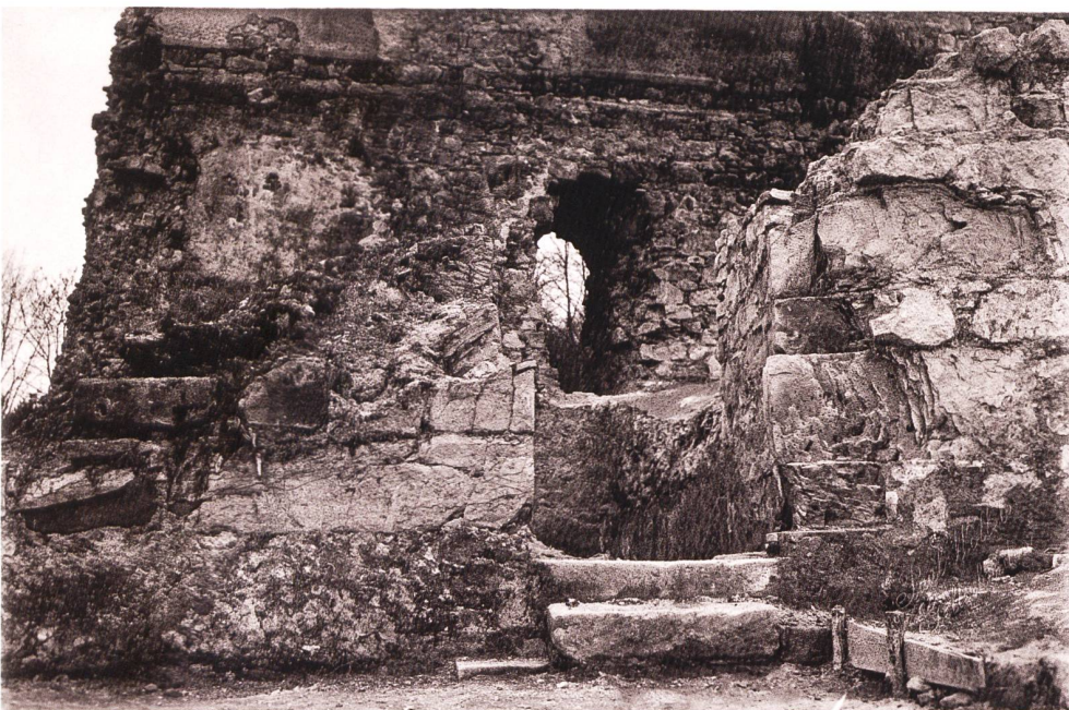
57: Der Eingang in den Keller Ost des Palas mit dem verwitterten Portal aus mächtigen Schilfsandstein- Blöcken vor der Restaurie- rung 1930/1931. Blick gegen Südwesten.
