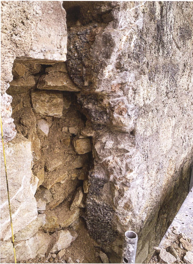
71: Erneuerte Mauerschale der 1960er/1970er-Jahre an der Südfassade der Schildmauer (M2) während der Sanierung 2019–2023. Zwischen dem burgenzeitlichen Mauerkern und der vorgesetzten Mauerschale aus Muschelagglomeratsteinen wurde ohne weitere Verankerungen eine Hinterfüllung von Magerbeton eingebracht. Blick gegen Osten.
