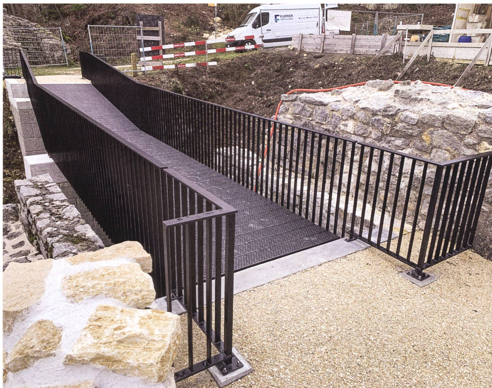
19: Die neue, für den Ruinenunterhalt befahrbare Brücke über den Burggraben – schlicht und beständig zugleich.
