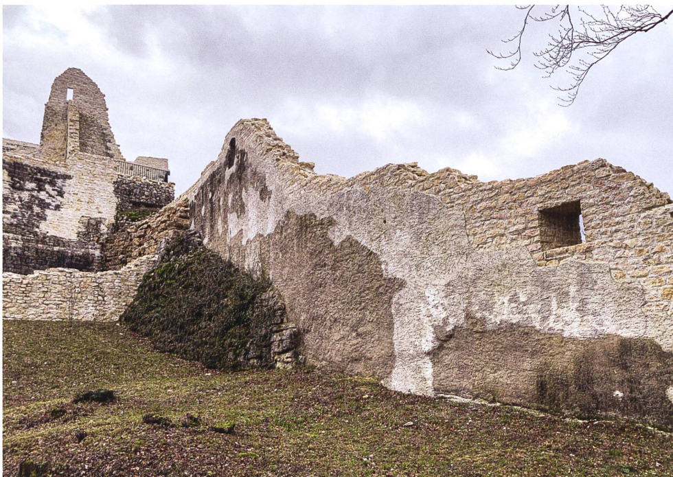
28: Die Ringmauer im Unteren Burghof Nord mit ergänztem Verputz, mit dem Brunnenhaus und seiner aufgestellten und angeböschten Nordmauer sowie der Nordwand des Amts- und Wohngebäudes in der Oberburg nach ihrer Sanierung im Jahr 2021.
