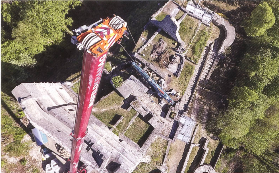
25: Präzisionsarbeit: Ein Pneukran hebt den in Teile zerlegten Baukran über die Schildmauer, wo er im Oberen Burghof zusammengesetzt und dann aufgestellt wurde.
