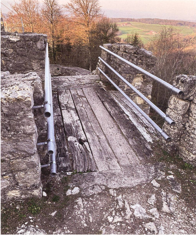
10: Die Brücke beim Pfisterhaus im Jahr 2019 vor der Sanierung. Das Gebilde aus alten Eisenbahnschwellen und Rohrstrangen genügte weder den Ansprüchen an die Besuchersicherheit noch an die Ästhetik.
