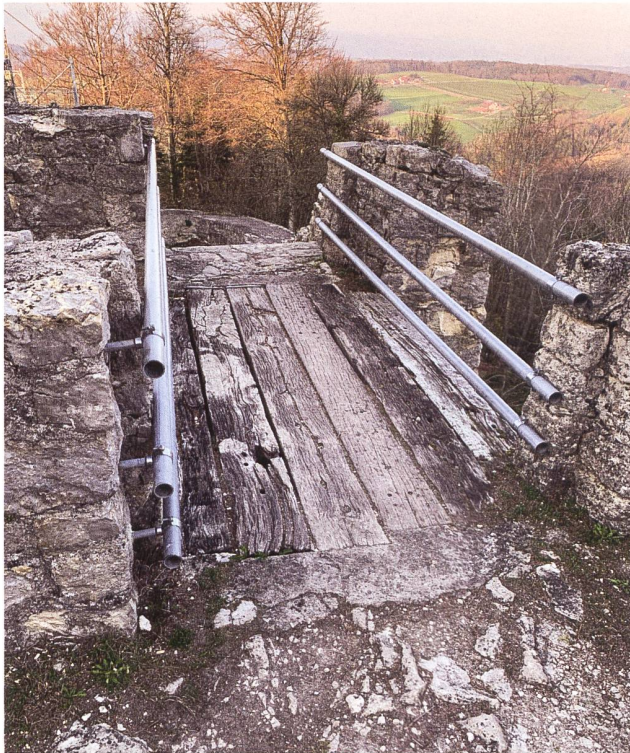
10: Die Brücke beim Pfisterhaus im Jahr 2019 vor der Sanierung. Das Gebilde aus alten Eisenbahnschwellen und Rohrstangen genügte weder den Ansprüchen an die Besuchersicherheit noch an die Ästhetik.
