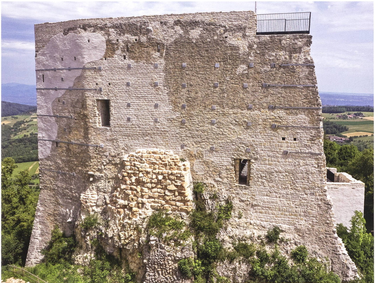
17: Die Schildmauer mit ersetzten Maueransichten und den Massnahmen zur statischen Sicherung aus Stahl – einem Korsett gleich – nach Abschluss der Sanierung. In luftiger Höhe befindet sich die neu eingerichtete Aussichtsplattform.
