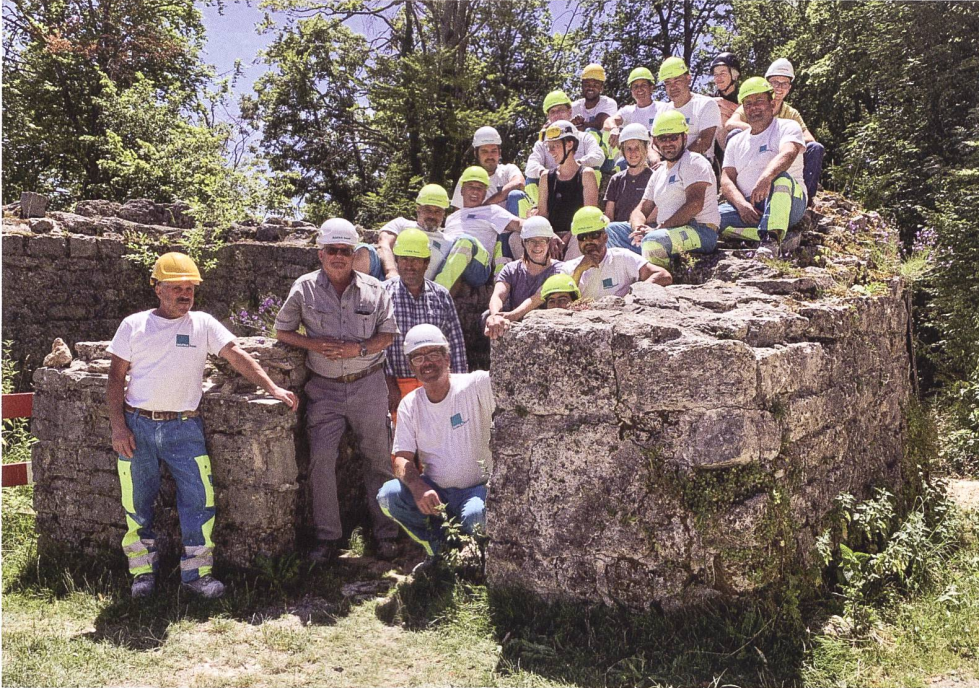
7: Das Baustellenteam der Sanierungsetappe 2022 mit dem Personal der Baufirma und der bauarchäologischen Untersuchung sowie Bauleiterin und Bauingenieur.
