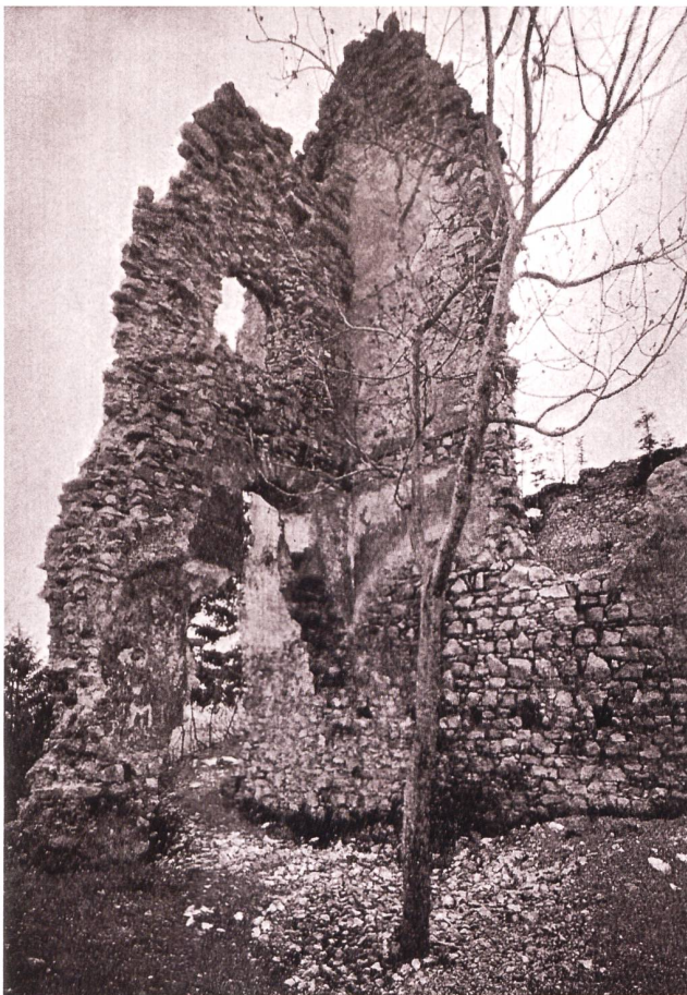
51: Fotografische Aufnahme der ostseitigen Kapellenmauer (M69) von 1907. Blick gegen Südosten.
