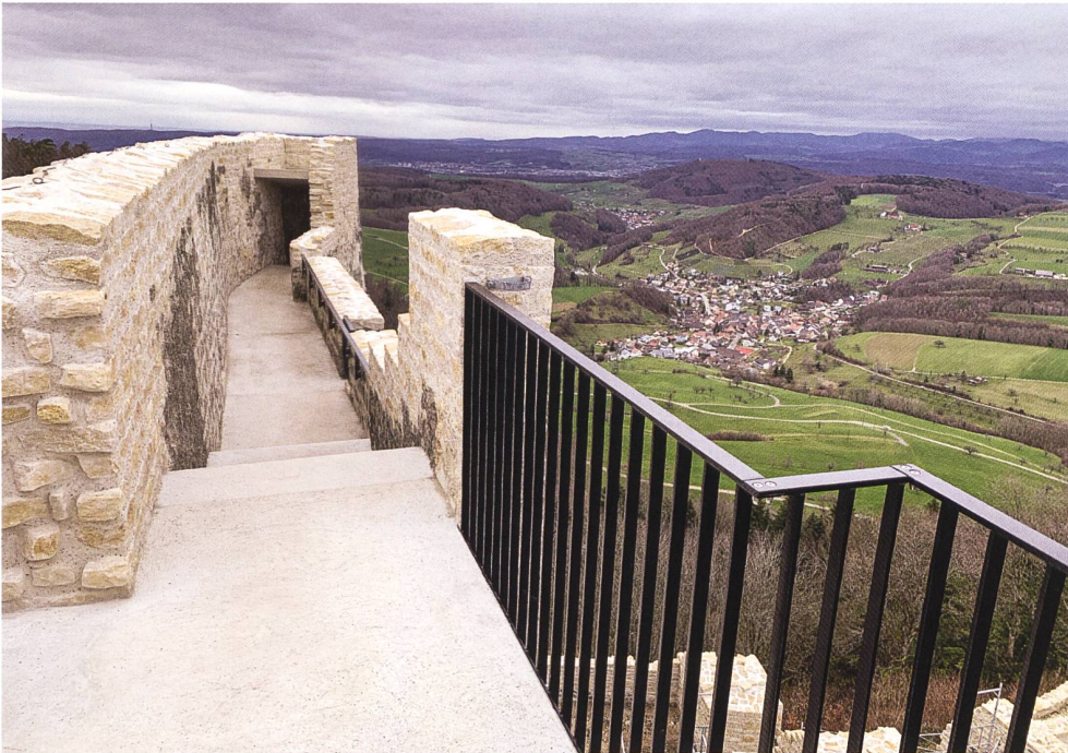
38: Der Wehrgang auf der Schildmauer nach seiner Sanierung. Neue Mauerkronen und flächen-deckende Betonabdeckungen schützen künftig den Mauer Kern vor dem Eintritt von Meteorwasser und damit die Mauer vor weiteren Frostschäden.
