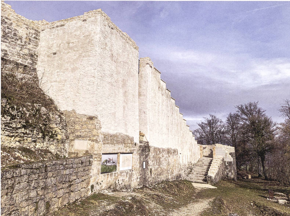
18: Die Lange Stiege und der Unterbau des Pfisterhauses nach Abschluss der Sanierung. Das Verputzen von Fassaden ist für Ruinen-sanierungen ungewöhnlich, im Falle der Farnsburg aber für frostgeschädigte Maueransichten in einigen Fällen die praktikabelste Lösung.
