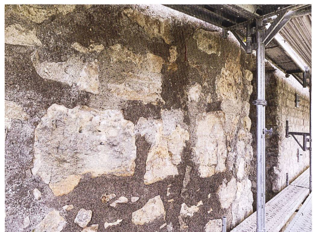
53: Die Mauerschale der Südfassade der Schildmauer mit grossen Hauptrotenbruchsteinen, die Zangenlöcher aufweisen. Zustand nach den Sanierungsarbeiten 2019–2023 und mit älterer Zementverfugung. Blick gegen Osten.
