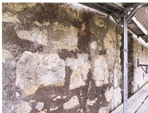
53: Die Mauerschale der Südfassade der Schildmauer mit grossen Hauptrotenbruchsteinen, die Zangenlöcher aufweisen. Zustand nach den Sanierungsarbeiten 2019–2023 und mit älterer Zementverfugung. Blick gegen Osten.
