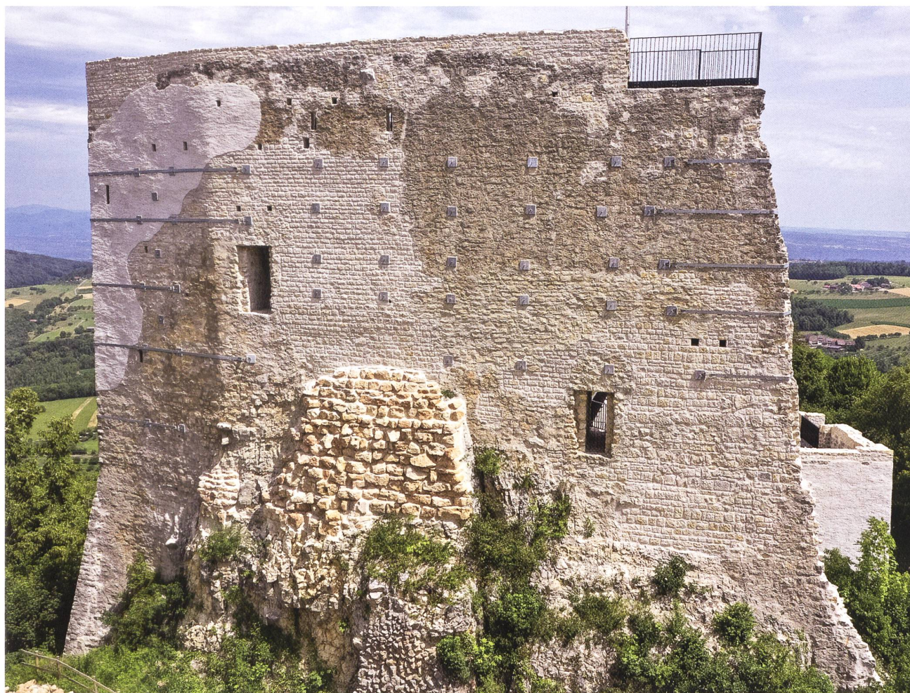
17: Die Schildmauer mit ersetzten Maueransichten und den Massnahmen zur statischen Sicherung aus Stahl – einem Korsett gleich – nach Abschluss der Sanierung. In luftiger Höhe befindet sich die neu eingerichtete Aussichtsplattform.
