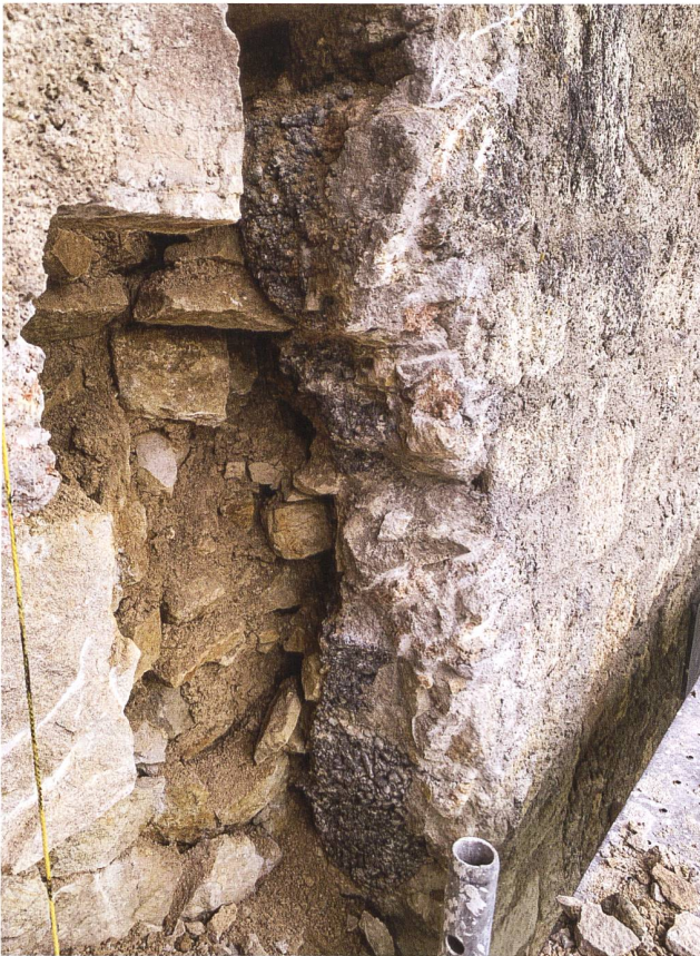
71: Erneuerte Mauerschale der 1960er/1970er-Jahre an der Südfassade der Schildmauer (M2) während der Sanierung 2019–2023. Zwischen dem burgenzeitlichen Mauerkerne und der vorgesetzten Mauerschale aus Muschelagglomeratsteinen wurde ohne weitere Verankerungen eine Hinterfüllung von Magerbeton eingebracht. Blick gegen Osten.
