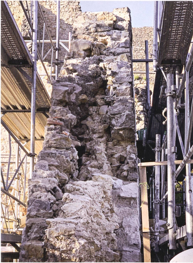
27: Blick in das Innenleben der zu Teilen bereits abgetragenen Ringmauer im Unteren Burghof Nord. Die Mauer-schalen stammen von einer Sanierung aus den 1940er- und 1950er-Jahren, nur ein Teil des Mauer-kerns ist noch burgen-zeitlich.
