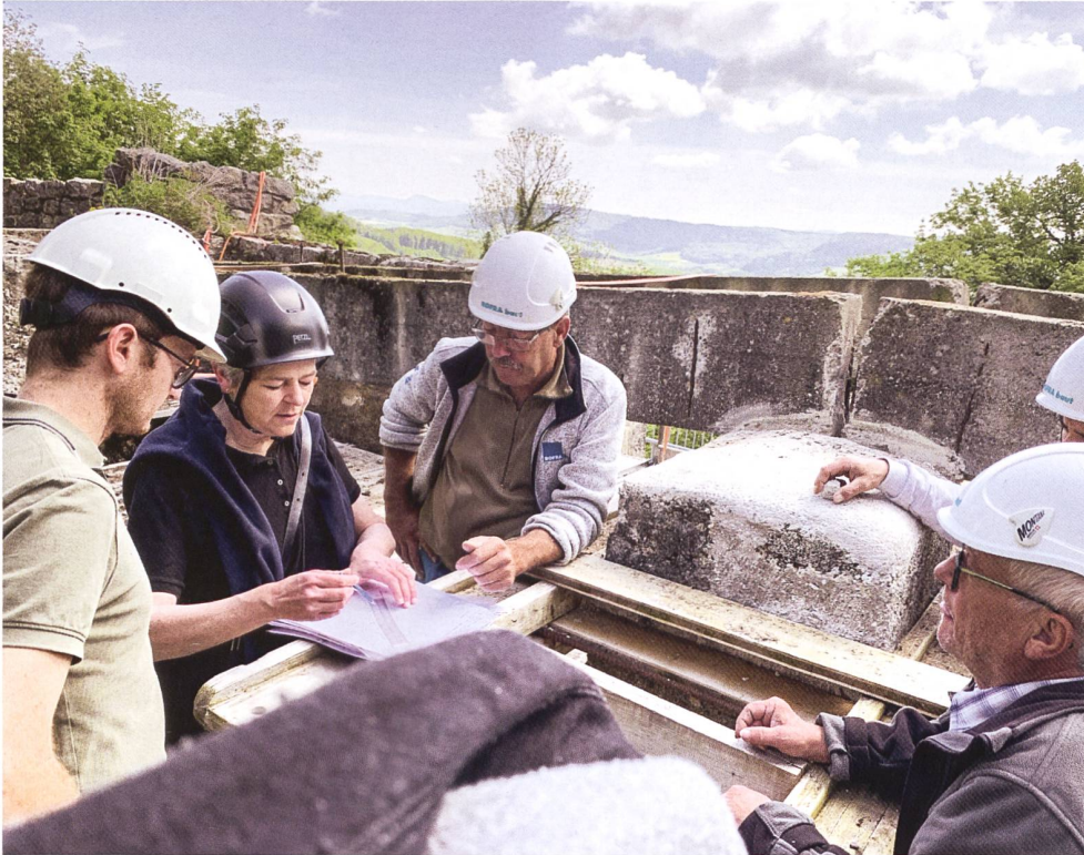
8: Jour fixe im Jahr 2022 am Mittelpfeiler der Brücke über den Burggraben: Bauleiterin Gabriela Güntert in Absprache mit Bauingenieur Manuel Wieland (links) und den Spezialisten der Baufirma.
