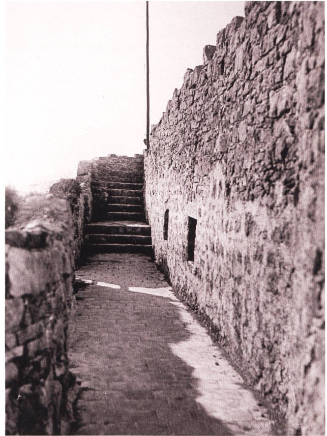
65: Der Wehrgang auf der Schildmauer (M2) kurz nach der Restaurierung 1930/1931. Beim oberen Treppenlauf ist links neben den Stufen ein älterer Mauer- bzw. Treppenblock zu sehen, der zur burgenzeitlichen Wehrgangerneuerung zählt. Blick gegen Südosten.
