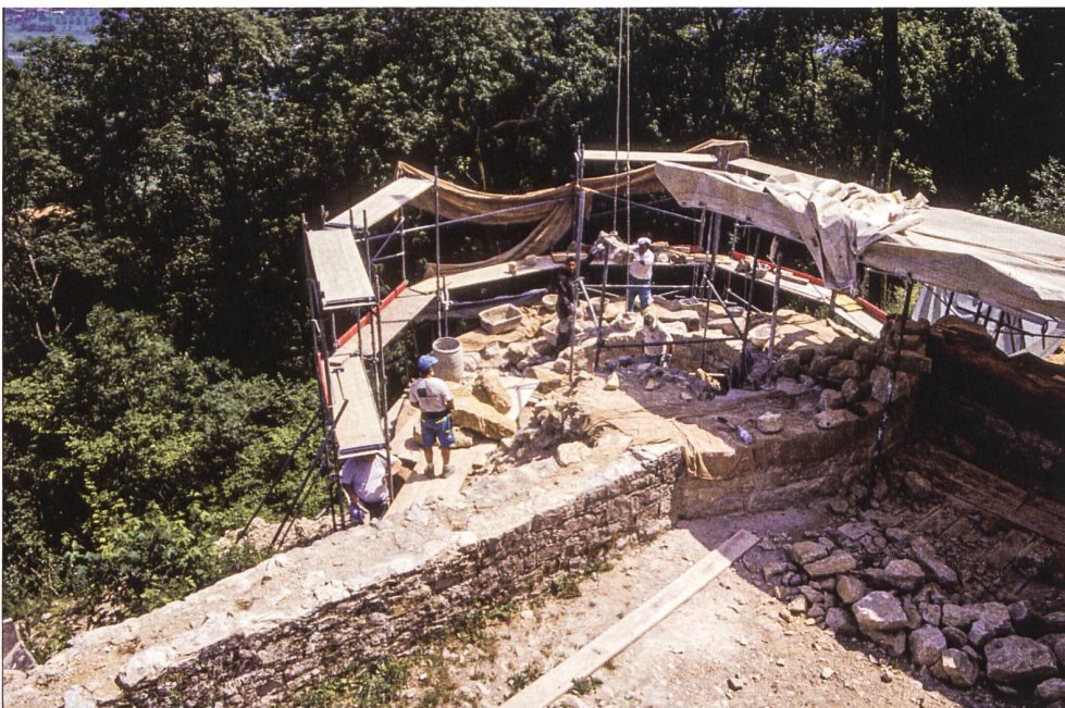
73: Der Bettlerturm (M17) wird während der Sanierung 2002–2003 neu aufgebaut. Mitarbeitende der Firma ROFRA Bau AG bei der Arbeit. Blick gegen Süden.
