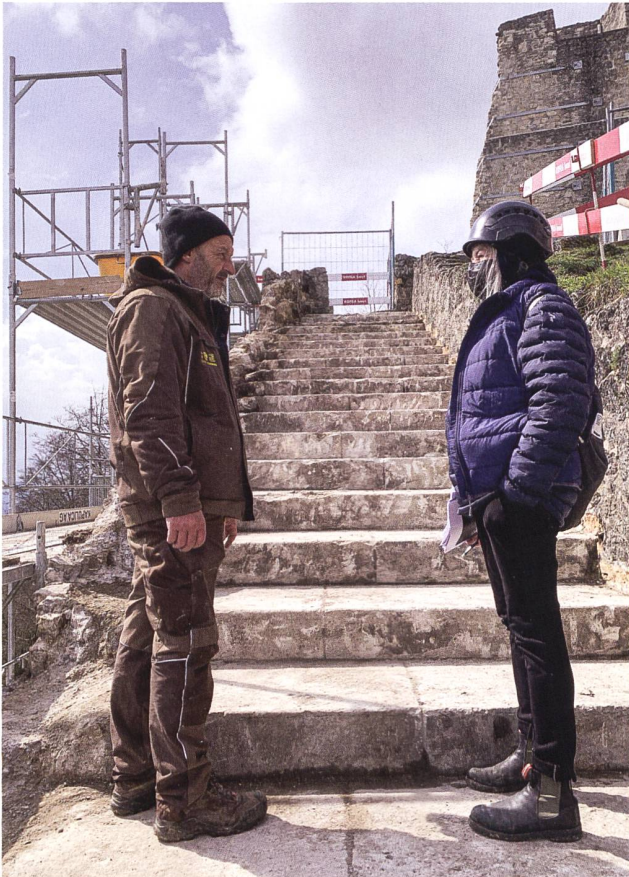
70: Burgherr Markus Dettwiler und Bauleiterin Gabriela Güntert auf der Langen Stiege während der Sanierungs- etappe 2021. Zu ihren Füßen die freigelegten Betonstufen des Treppenlaufes von 1930/1931. Blick gegen Südwesten.
