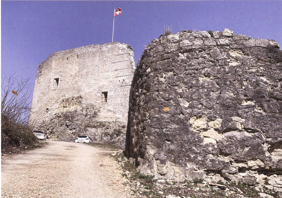
6: Die Ruhe vor dem Sturm – die Farnsburg kurz vor der aktuellen Sanierung. Rechts im Vordergrund die Barbikane mit den für Hauptrogenstein typischen Frostschäden an der Fassade.
