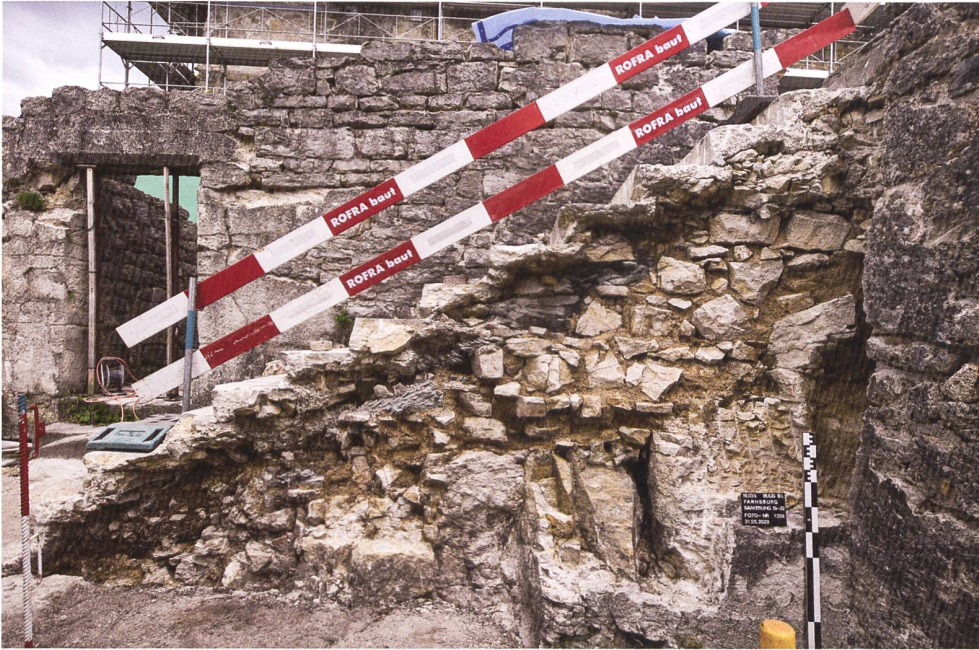
56: Die gemauerte Treppe zum Palas nach Rückbau der schadhaften Mauer- schale während der Sanie- rung 2019–2023. Unter den Betontreppenstufen von 1930/1931 sind noch die Reste der burgenzeitlichen Sandsteinstufen erkennbar. Blick gegen Südwesten.
