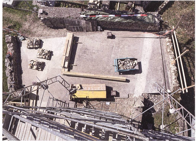
35: Aufgetaucht aus dem Untergrund: der für die Abdichtung der Betondecke wieder freigelegte Artilleriebeobachtungsposten aus dem Zweiten Weltkrieg in der Oberburg.
