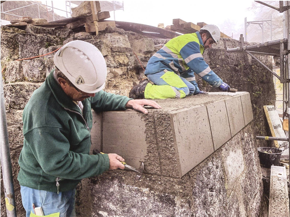
43: Das «Patent Saladin»: Die Baupoliere Peter Saladin und Damien Niklowitz rauhen beim Mauerpfeiler am Blauen Turm die eben ausgeschalteten und noch feuchten Oberflächen auf, um damit die ursprüngliche Mauer- schale aus Kalktuff zu imitieren. Die Abdeckung dient zudem zum Schutz des 1930 im Inneren mit Schutt verfüllten Pfeilers.
