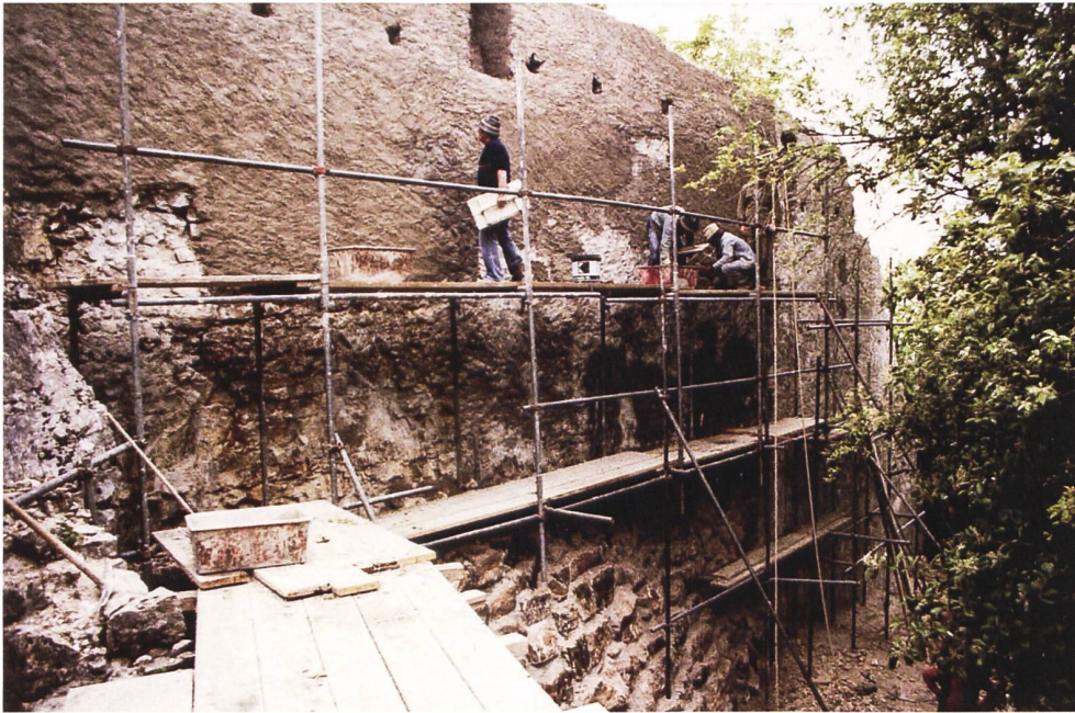
72: Die Ringmauer (M1) im Unteren Burghof Nord erhält 1983 innenseitig einen Vollflächenverputz. Blick gegen Norden.
