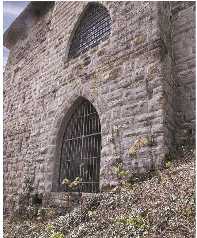
8: Der kyburgische Torturm von Schloss Burgdorf 2019. Die spätere Zumauerung wurde 1964 entfernt und durch ein Gitter ersetzt. Die Öffnung darüber entstand 1885, als man den originalen Entlastungsbogen zum Fenster umfunktionierte und das Mauerwerk darunter herausbrach. Blick nach Süden.
