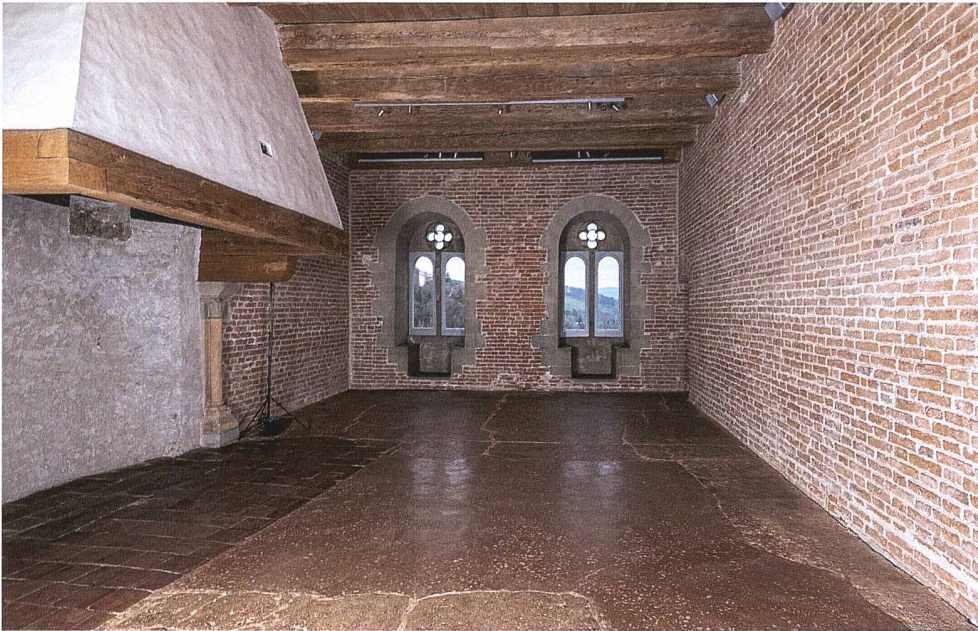
4: Der sogenannte Ritteraal im zweiten Obergeschoss des Palas von Schloss Burgdorf. Blick nach Süden. Fotografie von 2023.
