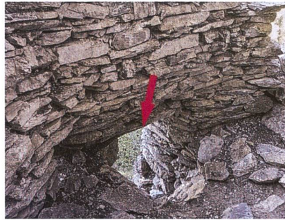
4: Innenaufnahme des Zugangs mit Holzsturz (markiert), darüber kleine Mauervertiefungen, eventuell Balkenlager eines Holzbodens.
