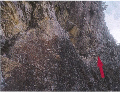
3: Mauerreste unmittelbar südlich oberhalb der Anlage.
