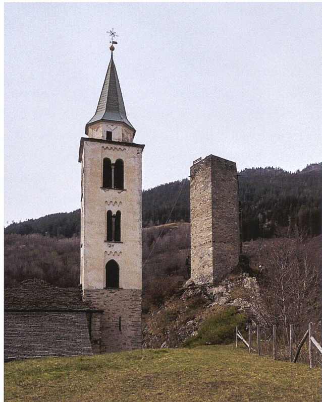
2: Rechts: Turm von Santa Maria di Calanca.
