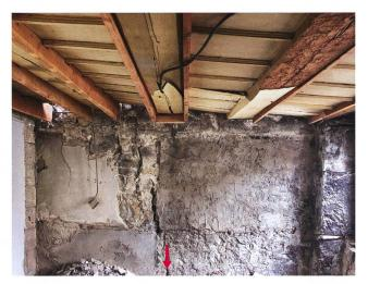
10: Der Anbau von 1690 hat sich im Bereich des Grabens gesenkt, was sich in der schrägen Decke zeigt. Die Risse in der Nordmauer (Pfeil) markieren den Verlauf der älteren Umfassungsmauer.
