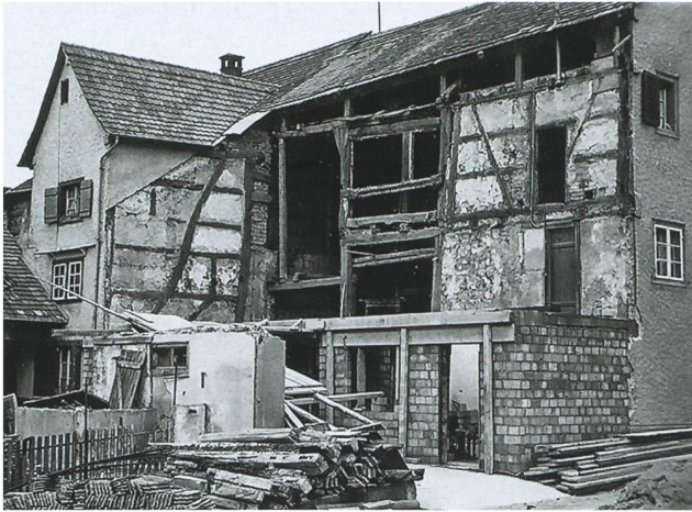
6: Aufnahme während des Umbaus der Steig 5 zu einem Dreifamilienhaus im Jahr 1960. Dabei wurde das hier noch sichtbare Fachwerk aus dem Spätmittelalter (Bildmitte) abgebrochen.
