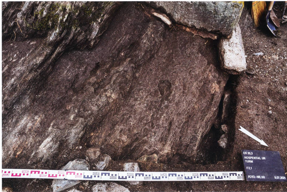
11: Hospental UR, Turm 2021. Aufsicht bei F2.1 auf die geschrotenen Felspartien an der Turmnordecke für das Auflager des Ecksteins (oben rechts, unter dem verschobenen Eckstein) und die möglichen Auflager für die Treppenstützen.
