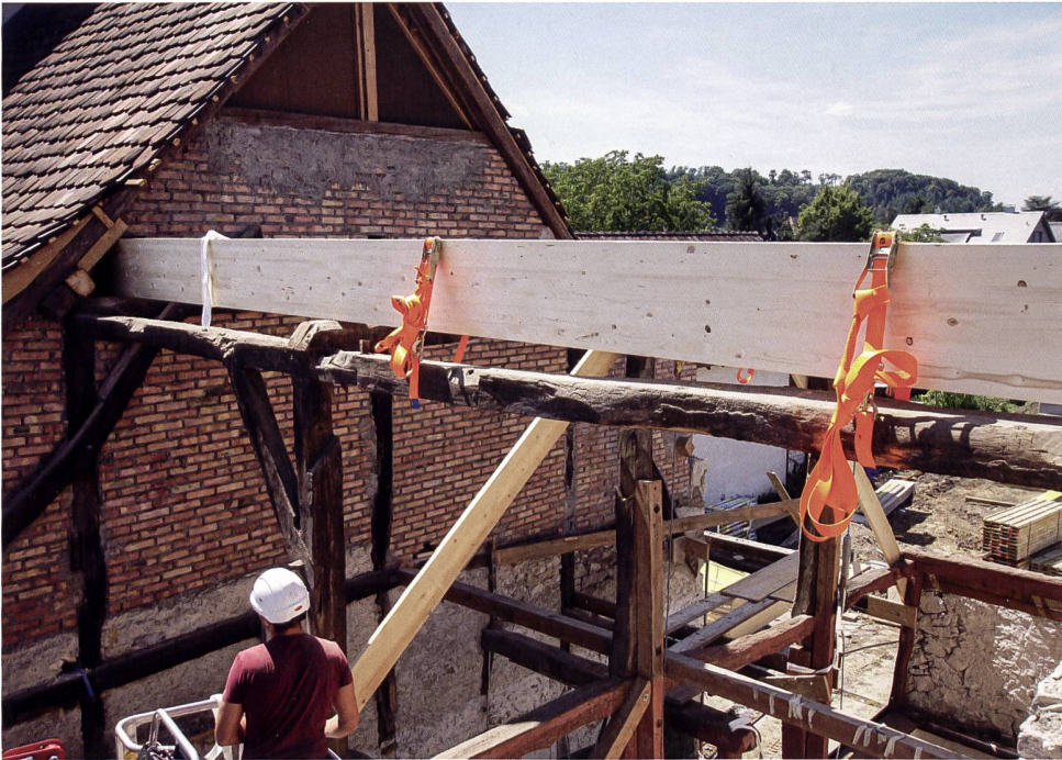
7: Der Dachstuhl von 1472, hier das Stuhlrähm über Tenn und Heuboden, das für den Umbau mit einem Träger fixiert wird. Foto 2018.
