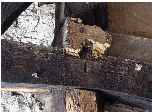
8: Unten der bis zum Unterfirst laufende Hochständer in der Bundachse III, darüber die Firstsäule. Dazwischen angeblattet der horizontale Kehlbalken mit einer Markierung für die Firstachse. Foto 2018.
