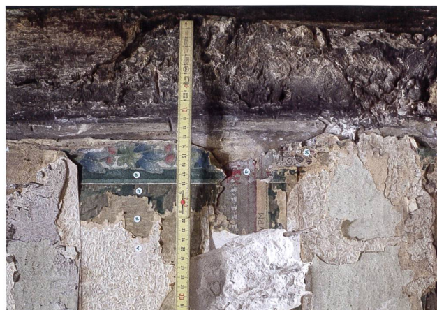
11: In der Stube im Wohnteil ist die südliche Wand mit Kalkputz, Tünchen, Bandmalerei und etlichen darüber aufgelegten Tapeten mit Bordüren versehen. Foto 2018.
