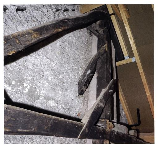
5: Von der jüngeren Scheidewand ummauerte Längsversteifungen in der Bundachse II. Links am oberen Rand die Dachlattung von 1472. Foto 2018.
