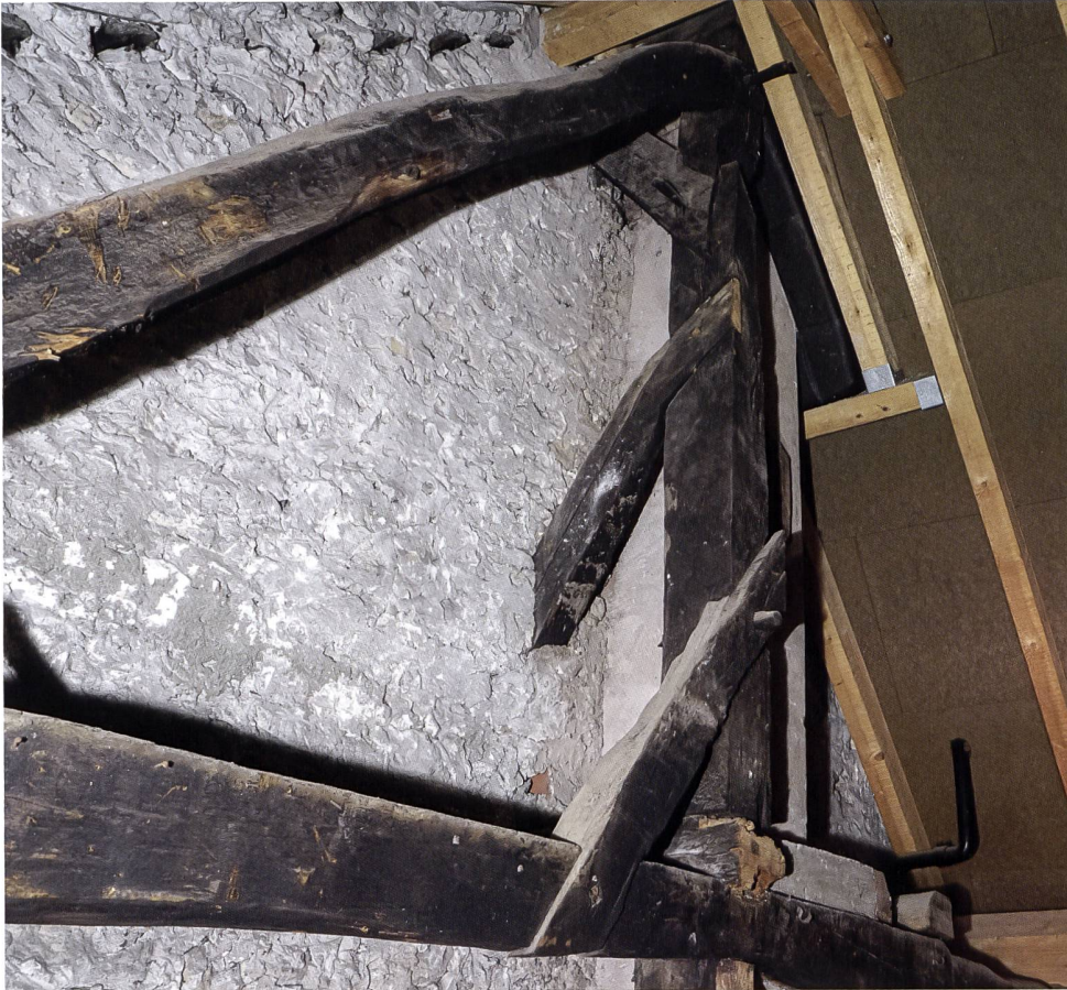
5: Von der jüngeren Scheidewand ummauerte Längsversteifungen in der Bundachse II. Links am oberen Rand die Dachlatung von 1472. Foto 2018.
