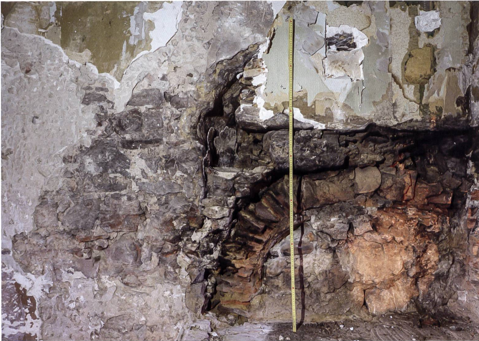
10: In den Steinbau eingetieft Ofennische in der Stube des Wohnteils. Im unteren Bereich wurde später ein Gewölbe für einen von der Küche her bedienbaren Backofen eingebaut. Foto 2018.
