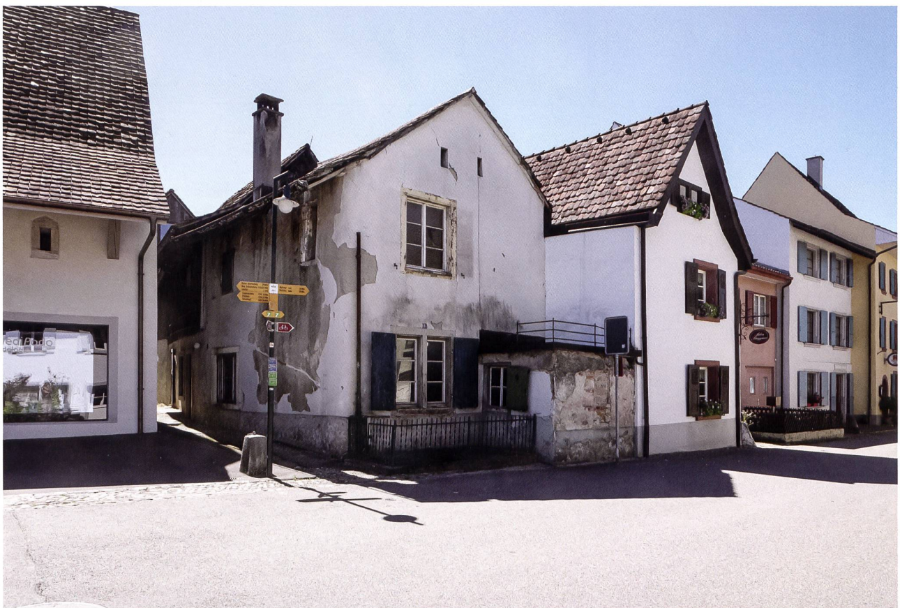
1: Burggasse 8 vor Beginn der Renovierung. Foto 2016.
