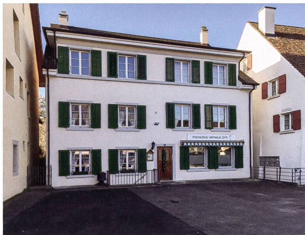
25: Liegenschaft Hauptstrasse 49. Mit dem Umbau der Ökonomie 1909 wurden eine Sattlereiwerkstatt, Wohnraum im Obergeschoss und der Hausgang eingebaut. 1929 wurde das Dachgeschoss angehoben und ausgebaut. Vorzustand siehe Abb. 12. Foto 2020.
