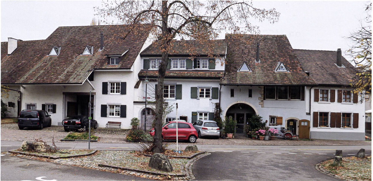
6: Strassenzug am Kirchplatz. Die Häuserzeile ist in sechs grossen Ausbauschritten gewachsen, ausgehend vom Wohnteil des dreiachsigen Bauernhauses links im Bild. Foto 2020.
