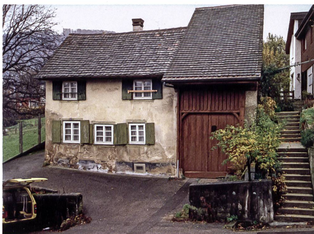
28: Liegenschaft an der Geispelgasse vor (linke Abbildung, undatierte Fotografie) und nach der Totalsanierung 1987 (rechte Abbildung, Foto 2020). Mehrere für die lokale Bautradition charakterbildende Elemente haben durch den Umbau ihren Zeugniswert verloren: Firstverlauf (= Versteinerungsvorgang), Positionierung von Kamin und Eingangstüre (= Grundrisskonzept), Dachknick (= Stuhlkonstruktion).
