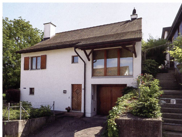
28: Liegenschaft an der Geispelgasse vor (linke Abbildung, undatierte Fotografie) und nach der Totalsanierung 1987 (rechte Abbildung, Foto 2020). Mehrere für die lokale Bautradition charakterbildende Elemente haben durch den Umbau ihren Zeugniswert verloren: Firstverlauf (= Versteinerungsvorgang), Positionierung von Kamin und Eingangstüre (= Grundrisskonzept), Dachknick (= Stuhlkonstruktion).
