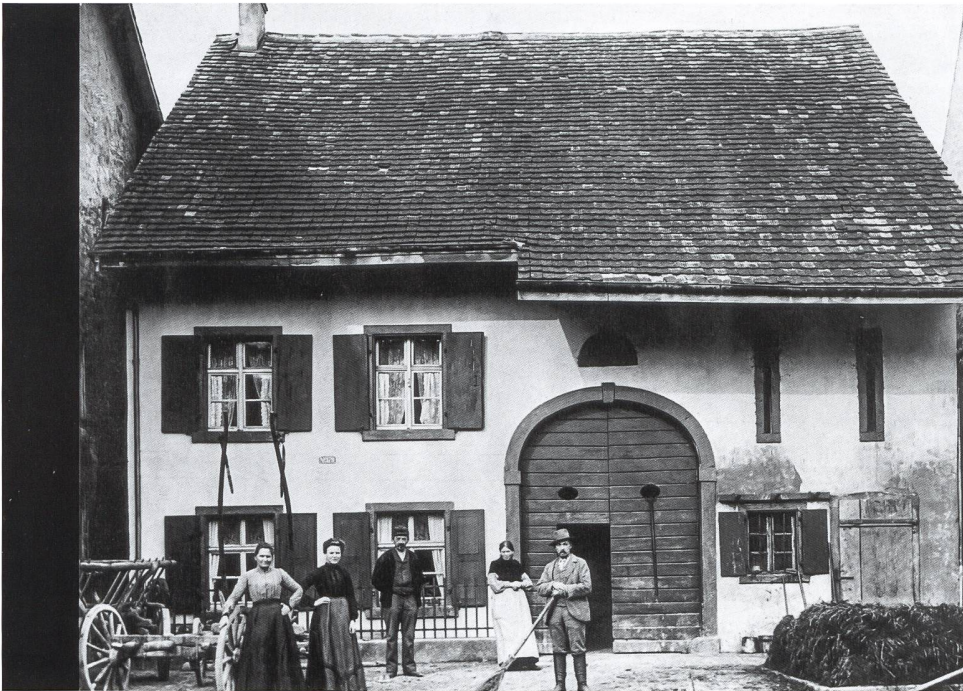
12: Liegenschaft Hauptstrasse 49. Typisches dreiachsiges Bauernhaus mit Wohnteil, Tenn und Stall, im Kern aus der Zeit vor 1678. Fotografie von 1908.
