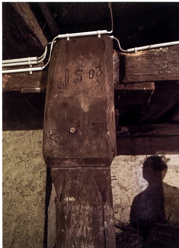
26: Liegenschaft Oberdorf 13. Eichene Kellerstütze mit Inschrift «1503» in spätgotischem Bauernhaus. Foto 2020.
