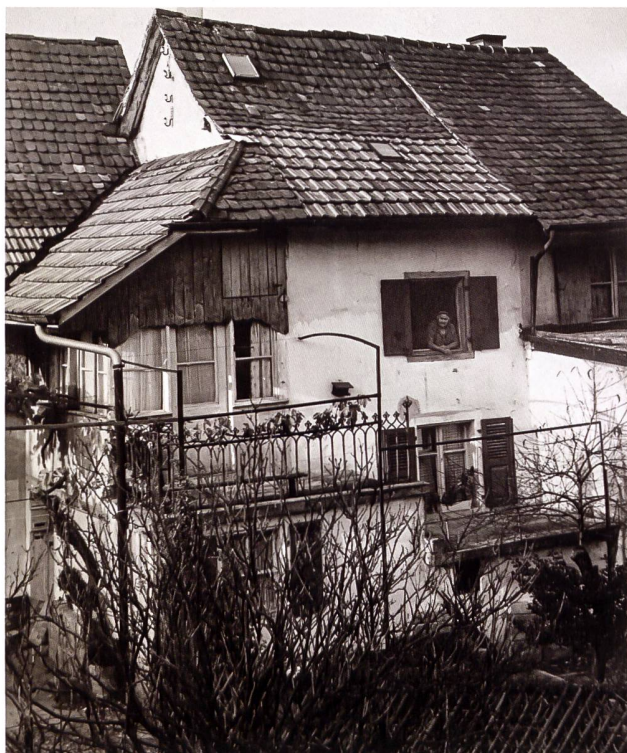
14: Liegenschaft Geispelgasse 16. Das einachsige Arbeiterhaus fügt sich an ein älteres einachsiges Gebäude (rechts) an und ist umbaut mit seitlicher Laube und vorgestelltem Anbau im Erdgeschoss. Undatierte Fotografie.
