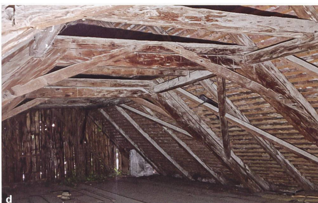
15: Chur. Die Dachstühle der Torkel: a Unterer Neubruchtorkel, liegend mit Hängewerk, 1582d; b Kronentorkel, liegend, 1593d; c Katztorkel, liegend, 1601d; d Brändlitorkel, liegend, 1601d; e Weisstorkel, liegend, 1604d; f Ragatzertorkel, undatiert (die dichte Abfolge der Binderbalken lässt auf einen liegenden Dachstuhl schliessen); g Maiertorkel, undatiert (mit stehendem Dachstuhl).
