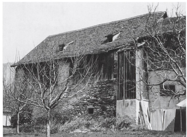
14: Zizers. Das Obergeschoss des Torkels von 1754d ist als Pfeilerbau errichtet, die Zwischenräume sind mit Bretterwänden geschlossen. Blick gegen Osten.
