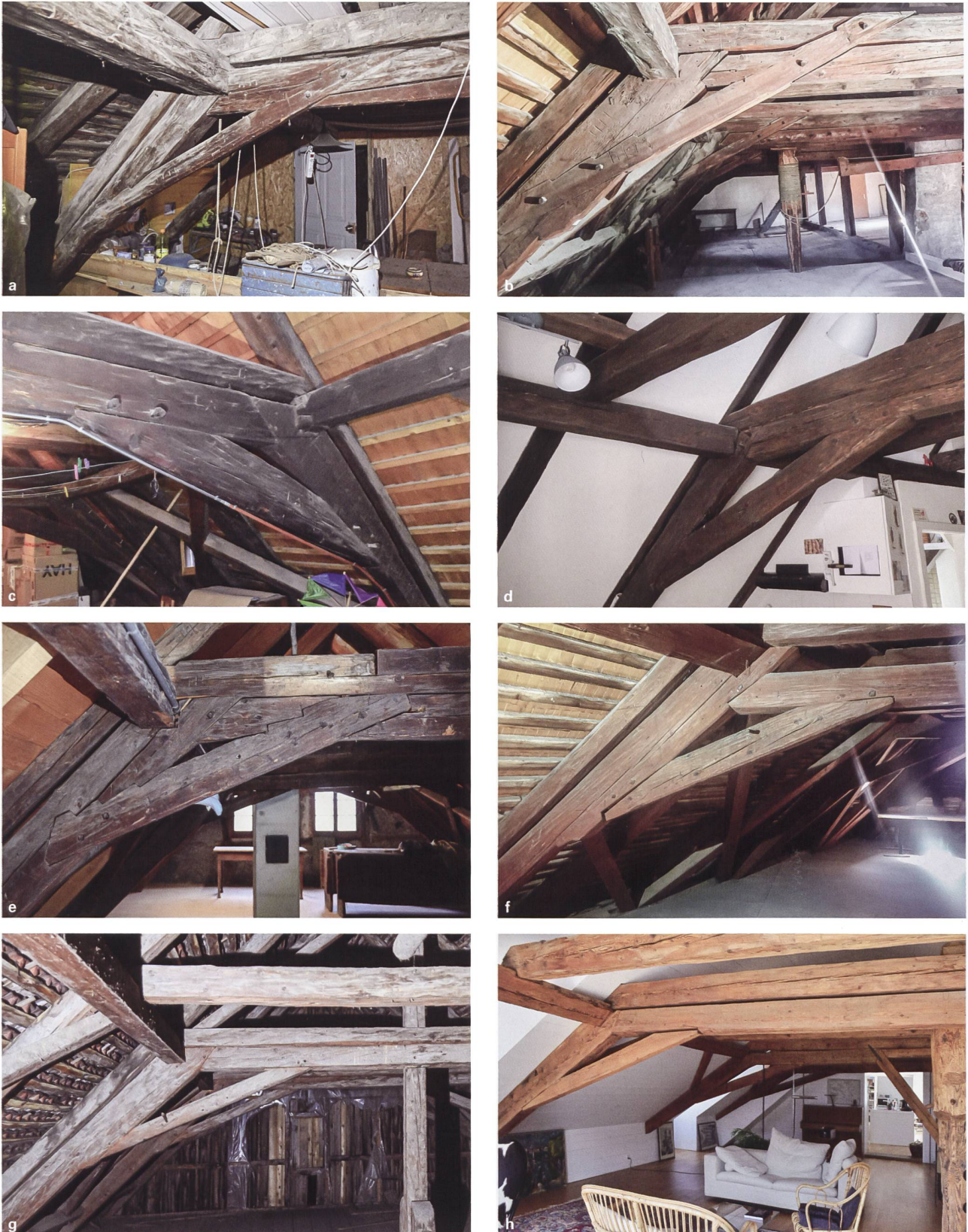
18: Chur, Cazis, Zizers. Formen der Kopfstreben an den Dachstühlen in Wohnhäusern (a–f, h) und einem Torkel (g). a Chur, Stuppishaus (1632d); b Chur, Bischöfliches Schloss, Nordtrakt (1639d); c Chur, Antistitium (1655d); d Chur, Maltesergasse 4 (1674d); e Cazis, Pfrundhaus (1687d); f Chur, Bischöfliches Schloss, Nordtrakt (1730d); g Zizers, Torkel (1754d); h Chur, Reichsgasse 55 (1833d).
