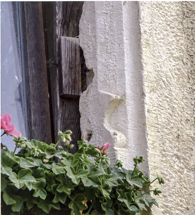
22: Rue de Kiffis 25/31. Das Fenster neben dem Eingang hat einen Gewändeanlauf mit einer Rankenvolute.
