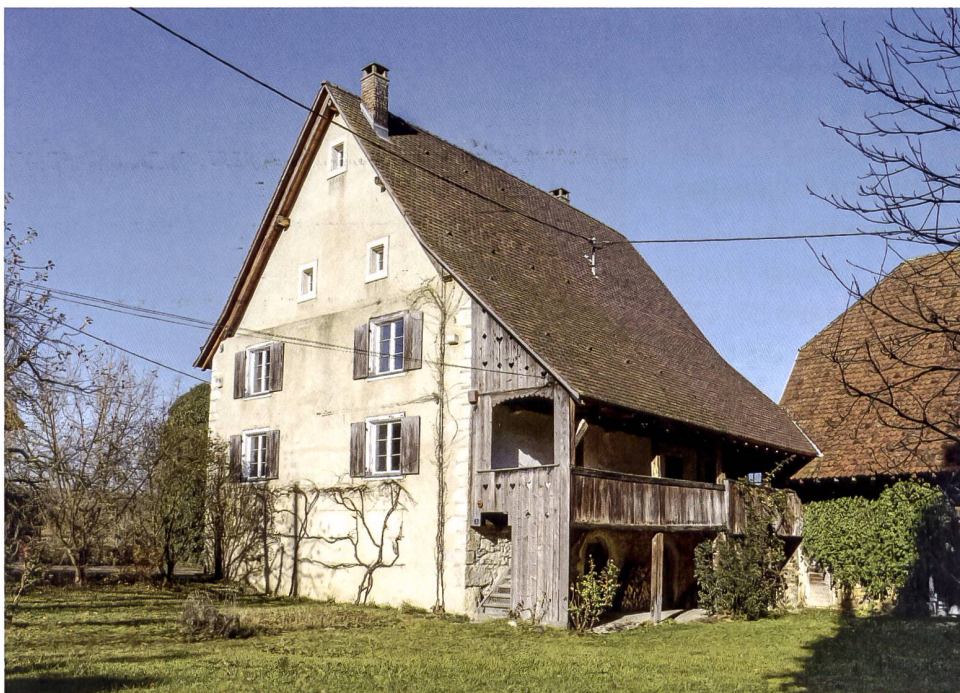
11: Im Haus Rue de l'Eglise 1/3 wohnte Burkhard Bigenwald, der im Juli 1582 Suizid beging. Das Haus ist dendrodatiert 1575–1580. Der Giebel war vormals vorkragend und mit Holz verschalt. Im Erdgeschoss waren Vorratskammern und der Pferdestall untergebracht.
