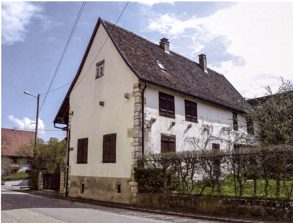
5: Das Zehntenhaus (Rue de Kiffis 7). Der turmartige Speicher von 1531–1535d ist das älteste erhaltene Gebäude in Lutter. Das unterste Geschoss ist teilweise in die Erde eingetieft. Das Gebäude wurde 1762 rückseitig zu einem Wohnhaus mit zwei Haushaltungen erweitert. Die Kragsteine am Giebel deuten auf eine hölzerne Giebelverschalung und jene an der Traufseite auf eine Laube hin.
