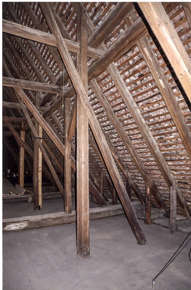
23: Bern BE, Französische Kirche. Dachwerk des Schiffs. Vertikalholz mit Binderbalken und Strebe. Rechts Sparren mit Sattalbalken und Sparrenfussbändern. Hinter dem Vertikalholz die sekundär eingefügte, stehende Stuhlkonstruktion.
