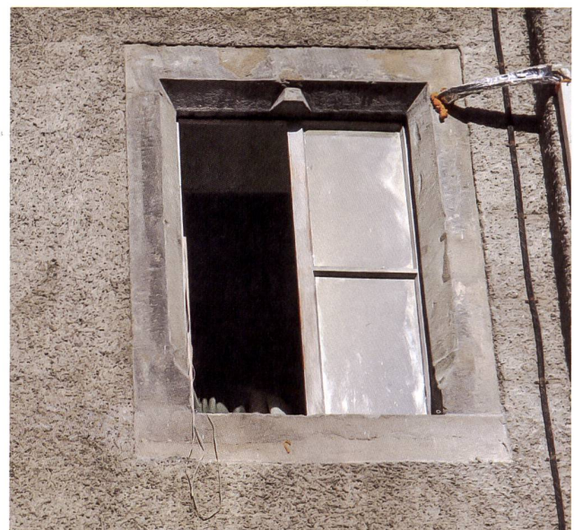
5: Luzern LU, Schlossergasse 3. Fensteröffnung an der Hoffassade im zweiten Obergeschoss, höchstwahrscheinlich aus der Bauzeit von 1353.
