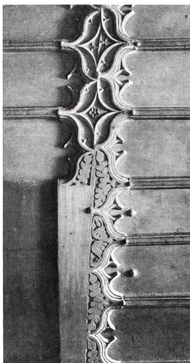
6: Luzern LU, Schlossergasse 3. Holzdecke mit masswerkverzierten Abschlüssen und Flachschnitzereien im nordwestlichen Raum im zweiten Obergeschoss. Abbildungen aus dem Luzerner Band «Das Bürgerhaus der Schweiz» von 1920.
