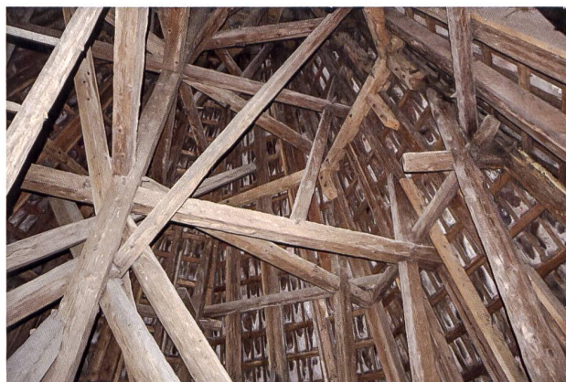
27: Thun BE, Stadtkirche. Blick ins Turmdach. Links Kaiserstiel, rechts Rafenunterzug auf Binderbalken und Hängehölzer.
