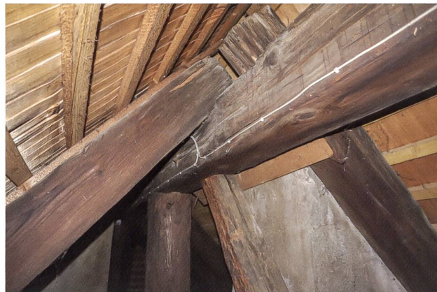
20: Frauenfeld TG, Schloss: Firstsituation bei einem mit Fussband ausgestatteten «Zwischengesparre».
