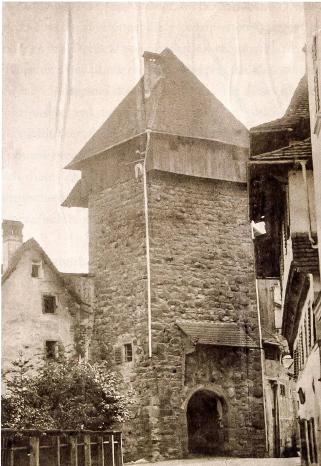
12: Luzern LU, Inneres Weggistor. Fotografie aufgenommen vor dem Abbruch 1862.
