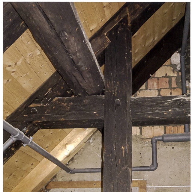
9: Luzern LU, Schlossergasse 3. Bindersparren, oberer Binderbalken und Hängeholz mit Rafenunterzug.
