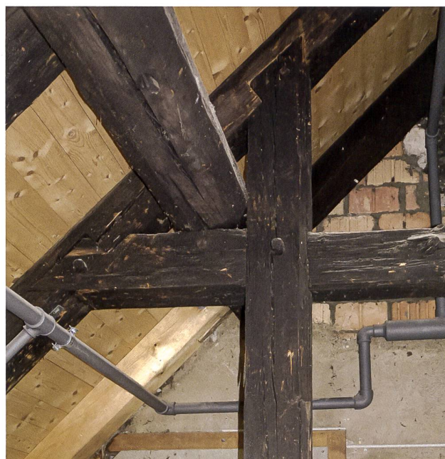
9: Luzern LU, Schlossergasse 3. Bindersparren, oberer Binderbalken und Hängeholz mit Rafenunterzug.
