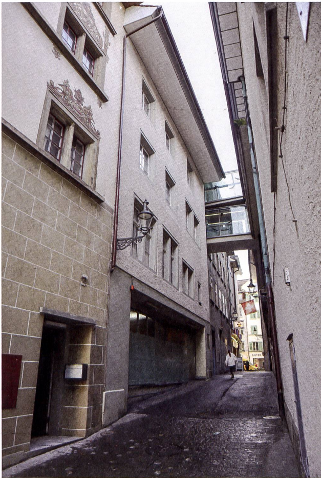
1: Luzern LU, Schlossergasse 3. Aktuelle, gassenseitige Ansicht.
