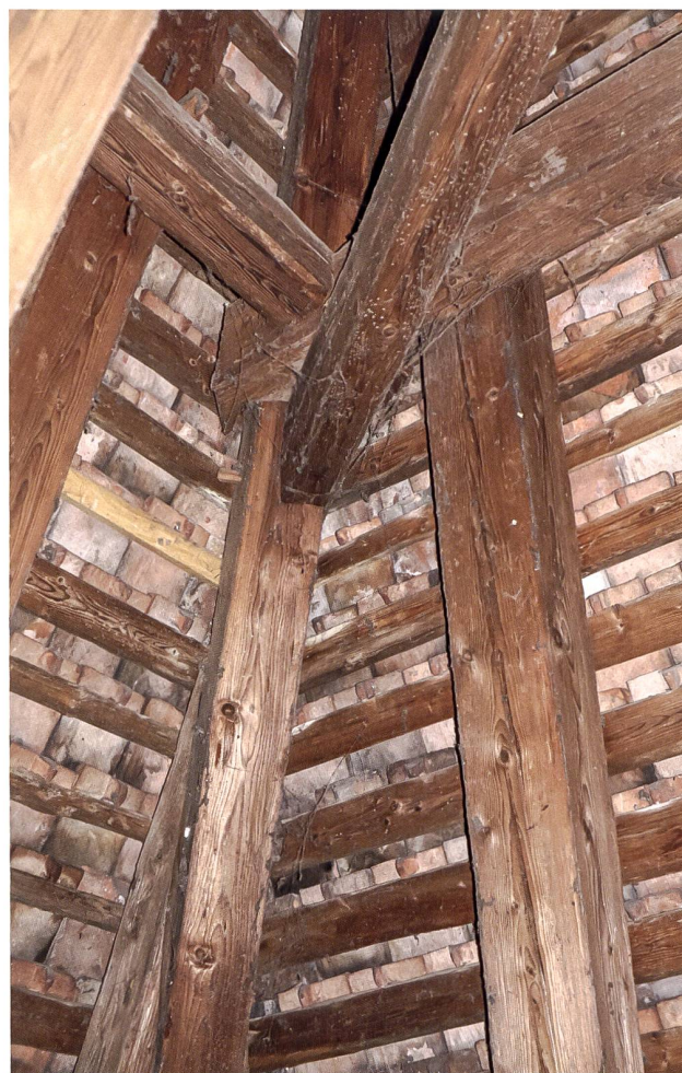
15: Luzern LU, Dächliturm. Dachwerk von 1449d. Grat mit überkämmten Rafenunterzügen.
