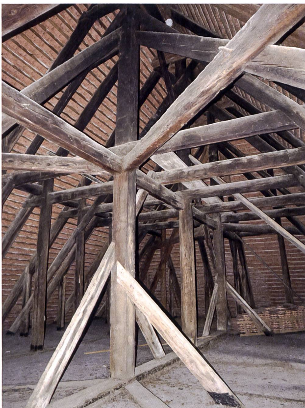
18: Hohenrain LU, ehem. Johanniterkommende, Turm Roten. Verstrebte Firstsäulenreihe.
