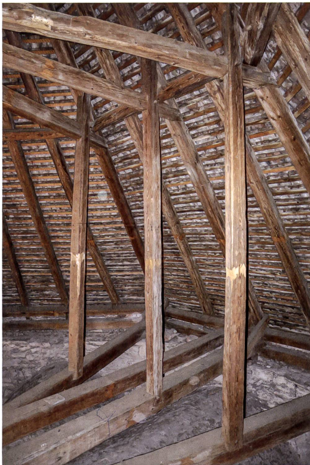
25: Interlaken BE, Schlosskirche. Dachwerk beim Chorpolygon.
