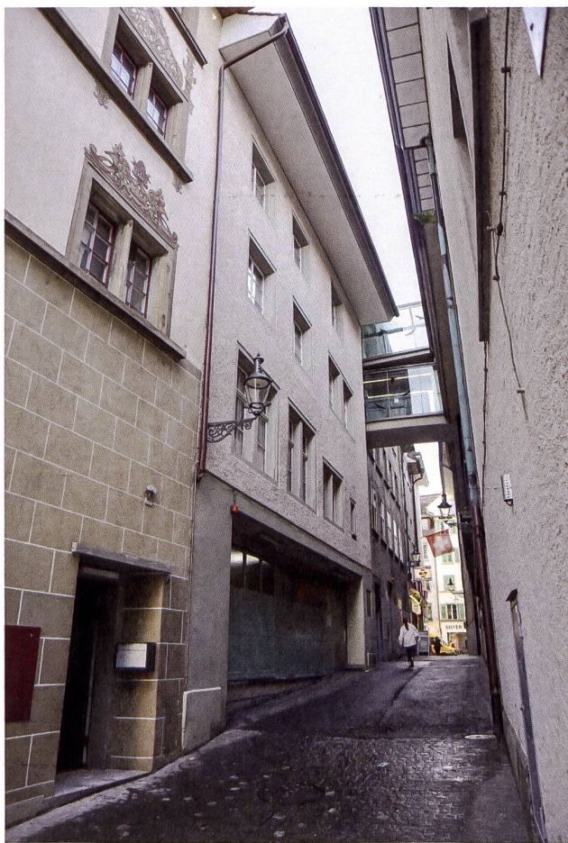
1: Luzern LU, Schlossergasse 3. Aktuelle, gassenseitige Ansicht.
