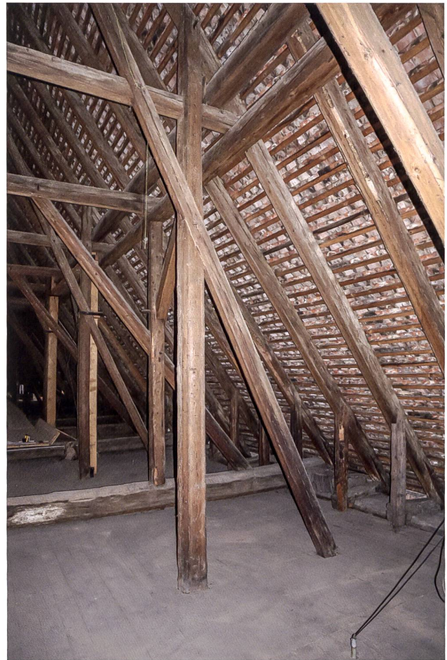
23: Bern BE, Französische Kirche. Dachwerk des Schiffs. Vertikalholz mit Binderbalken und Strebe. Rechts Sparren mit Sattelbalken und Sparrenfussbändern. Hinter dem Vertikalholz die sekundär eingefügte, stehende Stuhlkonstruktion.
