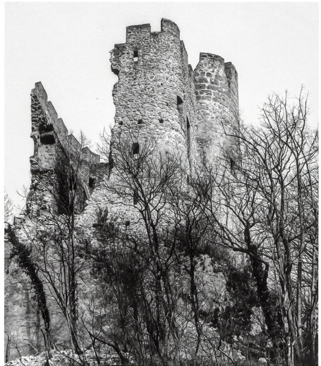
12: Büsserach, Ruine Neu-Thierstein. Ansicht von Süden nach dem Teileinsturz 1997.
