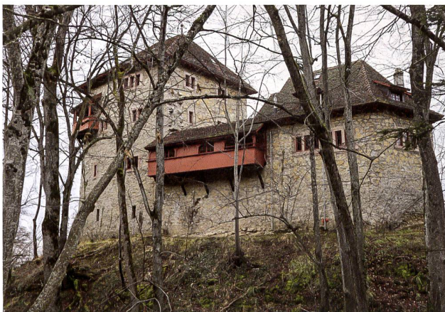
22: Metzleren-Mariastein. Burg Rotberg. Ansicht von Süden 2022.
