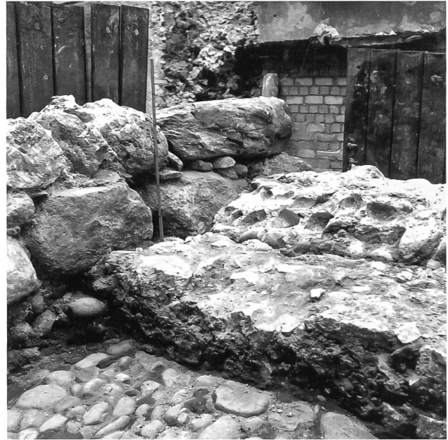
17: Solothurn, Hauptgasse 42 «Roter Turm». Findlingsmauer während der Ausgrabung 1960.
