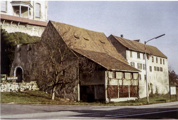
11: Niedergösgen, Schlosshof. Ansicht der ehemaligen Unterburg vor der Renovation 1981. Rechts aussen der mutmassliche Speicher- oder Magazinbau. Foto M. Mercatali.
