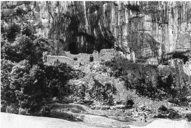
8: Balm bei Günsberg, Ruine Balm. Gesamtansicht der Grottenburg nach der Konservierung 1941.
