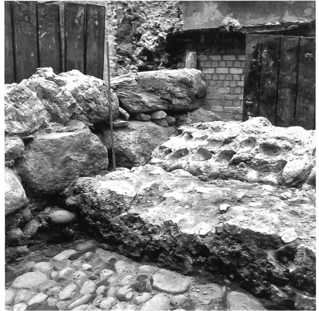
17: Solothurn, Hauptgasse 42 «Roter Turm». Findlingsmauer während der Ausgrabung 1960.
