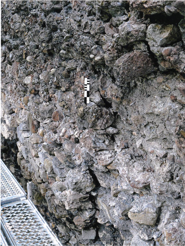
9: Schänis SG, Ruine Niederwindegg, 2020. Mauer M2, Innenfassade, von Südsüdosten. Der Mauermantel wurde in dieser Partie eher durch Frostsprengungen als durch Beraubung vom Mauerkern getrennt.
