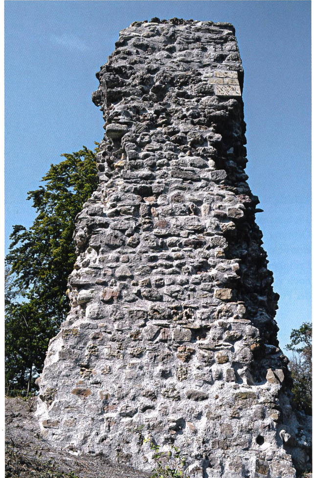
17: Schänis SG, Ruine Niederwindegg, 2020. Mauer M3, fertig in Stand gestellt, von Südosten. Der beinahe senkrechte Abbruch zum Burginneren hin lässt vermuten, dass die Mauer in dieser Richtung nie länger war.
