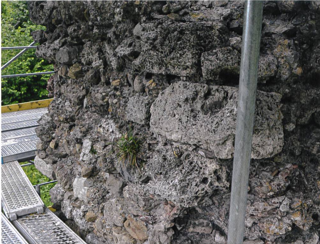
16: Schänis SG, Ruine Niederwindegg, 2020. Mauer M2, Absatz, von Osten. Der Mauerabsatz besteht aus schräg abfallend zugehauenen Steinen. Die über dem Absatz liegenden Tuffsteinquader (im Vordergrund) sind Reste des Eckverbandes M2/M3.
