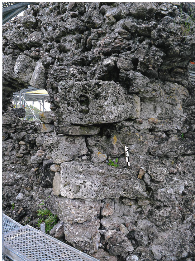
10: Schänis SG, Ruine Niederwindegg, 2020. Ecke M1/M2 mit Resten des Eckverbandes aus bossierten Tuffsteinquadern, von Norden.
