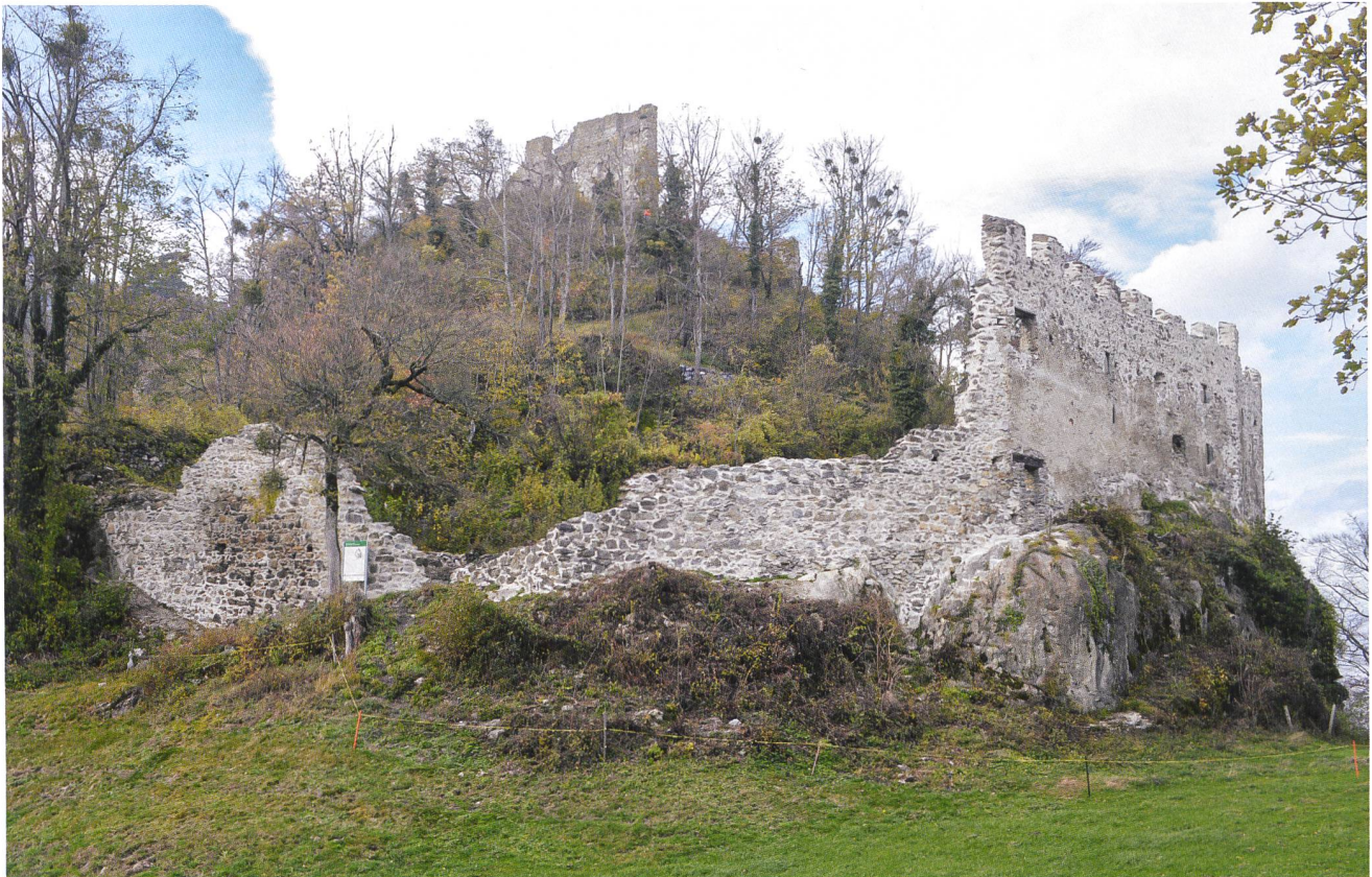
17: Pfäfers SG, Ruine Wartenstein, 2019. Gesamtanlage, von Südosten. Im Hintergrund die Obere Burg, darunter die frisch in Stand gestellte Untere Burg.
