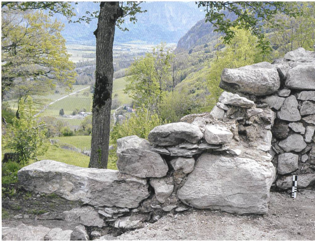
13: Pfäfers SG, Ruine Wartenstein, 2019. Untere Burg, Tor, von Südosten. Der auf dem Bild weit auskragende lange Stein links unten könnte Teil des südwestlichen Torgewändes gewesen sein. Die lediglich 70 cm breite Ringmauer M207 ist neben dem Tordurchgang gegen innen um 60 cm verstärkt, auf einer Länge von knapp 2 m.
