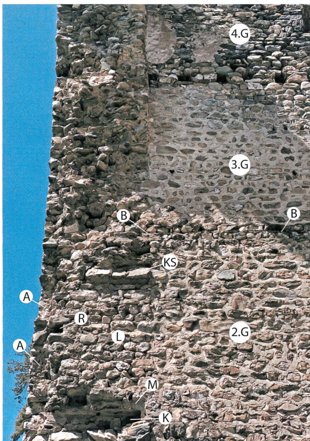
14: Alt-Süns GR. Bereich Hocheingang. B–B = Baunaht Mörtel auf Mörtel, L = Leibungsfläche des Hocheingangs, R = Riegelbalkenkanal, A = ausgebrochene Gewändesteine, KS = Kämpfer des inneren Stichbogens, M = Mörtelnegativ Torschwelle, K = Konsolbalkennegativ des Eingangspodests.
