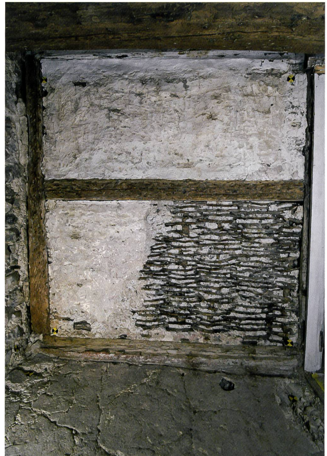
14: Stein am Rhein SH, Brodlaubegass 15. Nördlicher Raum im EG. Fachwerkwand mit Flechtwerkausfachung aus Bauphase II. Blick nach Süden.
