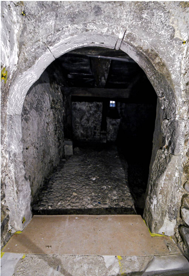
19: Stein am Rhein SH, Brodlaubegass 15. Kellerportal mit abgearbeitetem Gewände, um Durchlass für Weinfässer zu schaffen.
