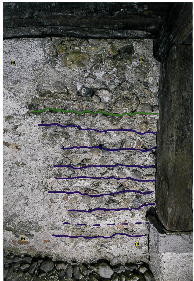
11: Stein am Rhein SH, Brodlaubegass 15. Süd-wand Keller. Die nachträgliche Unterkellerung geschah durch das Unterfangen des bestehenden Fundaments (grüne Linie) um jeweils zwei bis drei Steinlagen (violette Linien). Blick nach Süden.
