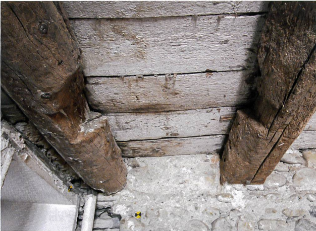
15: Stein am Rhein SH, Brodlaubegass 15. Nördlicher Raum im EG. Deckenbalken mit Aussparungen für eine Binnentreppe. Blick nach Osten.
