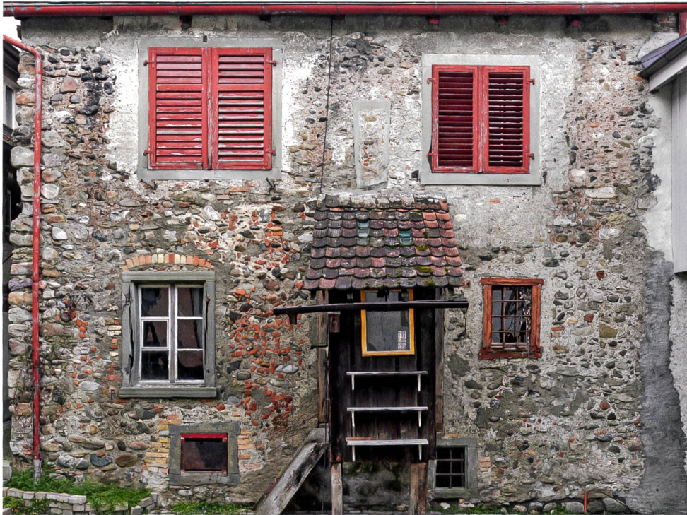
4a: Stein am Rhein SH, Brodlaubegass 15. Westfassade. Blick nach Osten.
