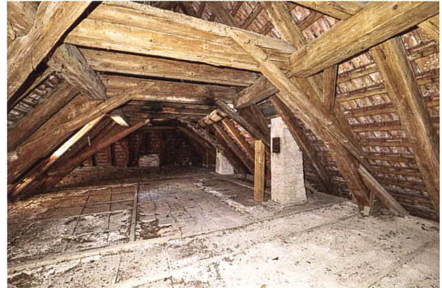
25: Schloss Buonas. Liegender Dachstuhl von 1495 über dem Nordostrakt. Blick nach Nordwesten.
