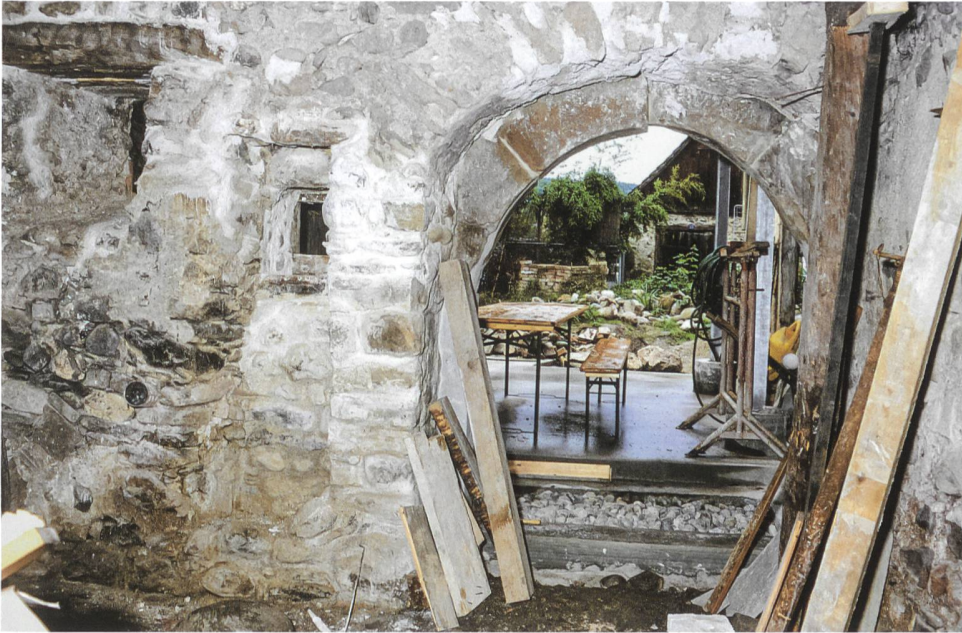
2: Steckborn TG. Seestrasse 96. Torbogen und Scharte des Mauergevierts, Blick von innen nach Norden.
