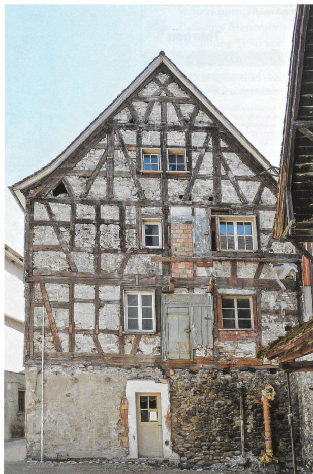
7: Steckborn TG. Seestrasse 84. Nordfassade der Schmitte, datiert 1647/48.
