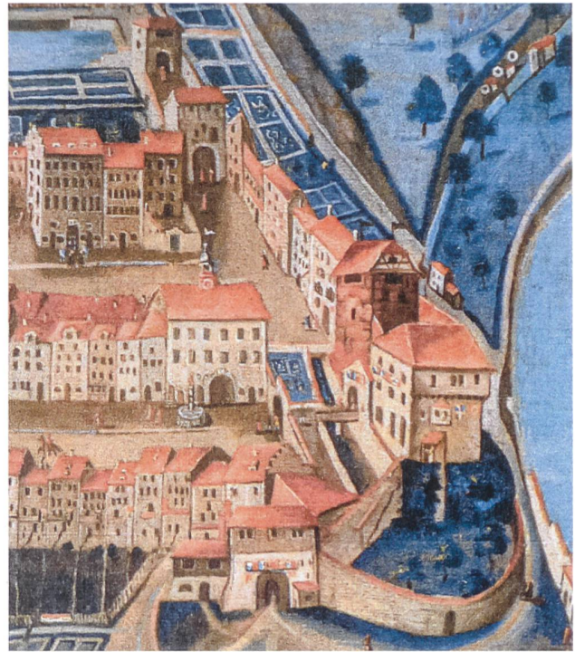
7: Frauenfeld TG. Schloss und Stadt Frauenfeld in einer Ansicht von Jos Bieg von 1762 (Ausschnitt). Deutlich erkennbar sind der Burggraben gegen die Stadt sowie die verschiedenen Wappen an den Aussenmauern des Landvogteisitzes.
