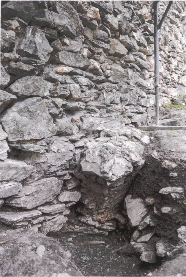
27: Wynegg GR. Keller A, Nordecke, Ansatz des Kreuzgewölbes von Phase 8 (Aufnahme 24.3.2017).
