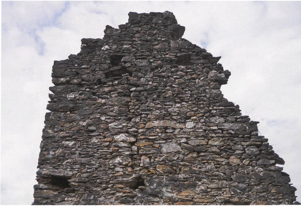
29: Wynegg GR. Sek M4, Südansicht. Detailaufnahme des erhaltenen Stufengiebels (Aufnahme 10.8.2016).
