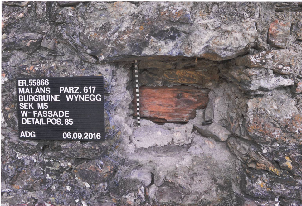
25: Wynegg GR. Sek M5, Ostansicht. Detailaufnahme eines Armierungsholzes, einsehbar im rückwärtigen Bereich eines Balkenauf-lagers des 1. Obergeschosses (Aufnahme 9.6.2016).
