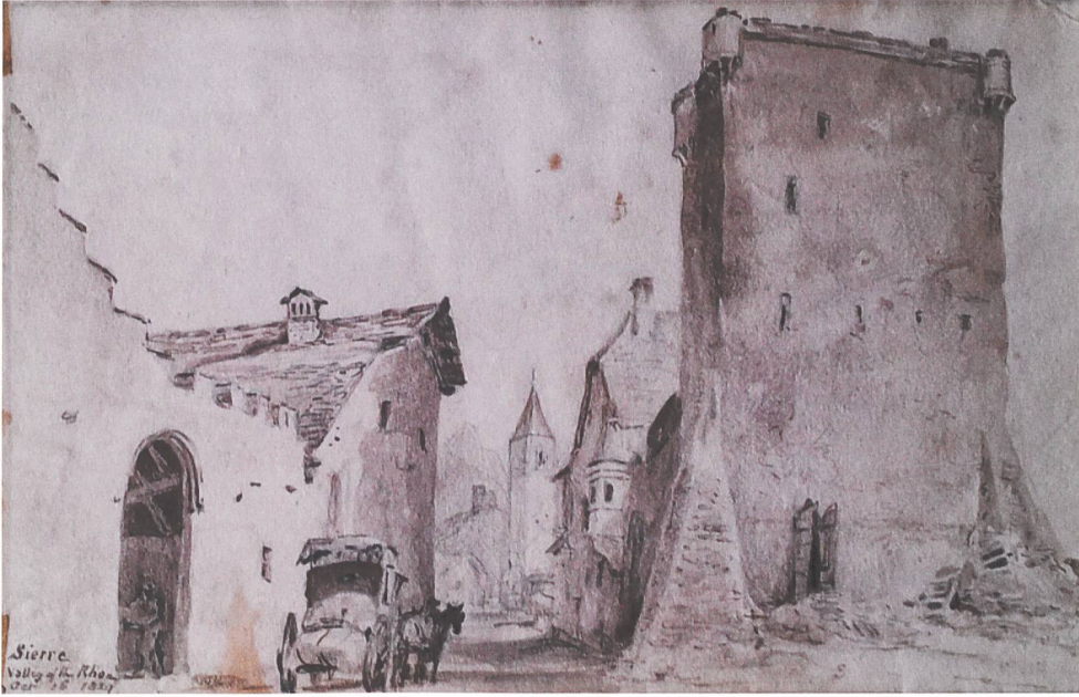
12: Sierre VS, tour des Vidomnes. Vue depuis l'ouest. Dessin anonyme de 1829 (propriété privée).
