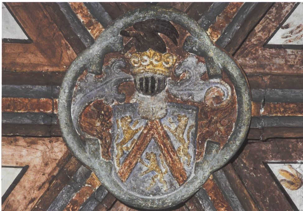
14: Sierre VS, église du Marais. Armoiries de François de Chevron, vidomne 1503–1528. Clef de voûte du chœur, construit par Ulrich Ruffiner en 1525.
