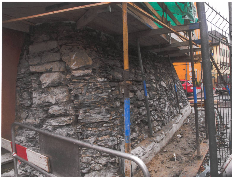
11: Sierre VS, tour des Vidomnes. Face orientale du contrefort nord. Le chaînage de gros blocs caractérise le premier état du contrefort, avant qu'il ne soit renforcé par un doublage.
