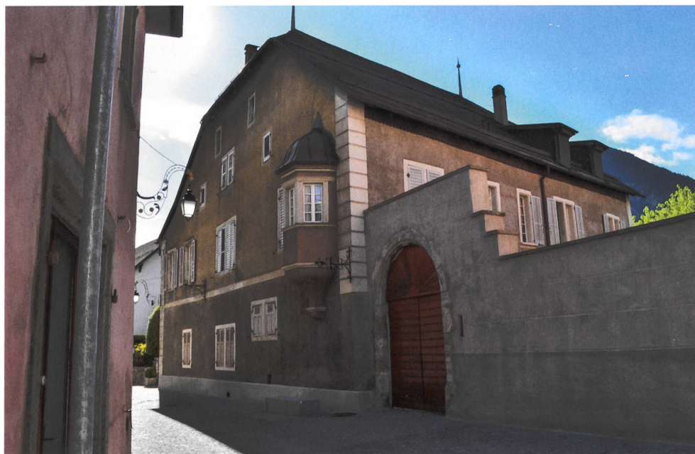
19: Sierre VS. Façade nord de la maison Courten-de Chastonay. La fenêtre occidentale du rez-de-chaussée, plus élevée que les autres, pourrait refléter un état de la maison adapté à une chaussée plus haute, à l'instar du portail fermant la cour du château des Vidomnes qui a été quant à lui allongé vers le bas (2019).
