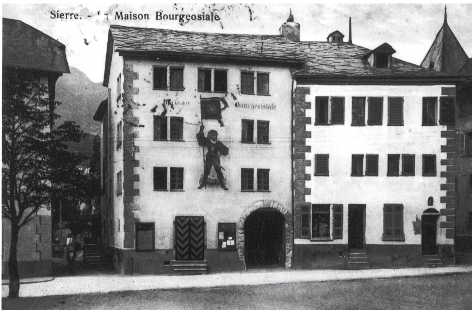
18: Sierre VS. Vue de la maison bourgeoiale (à gauche) et du vicariat (à droite) depuis le sud, démolis respectivement en 1954 et 1928. Les portes piétonnes sont dotées de quelques marches d'escalier extérieures, tandis que la porte charrière paraît avoir été allongée vers le bas.
