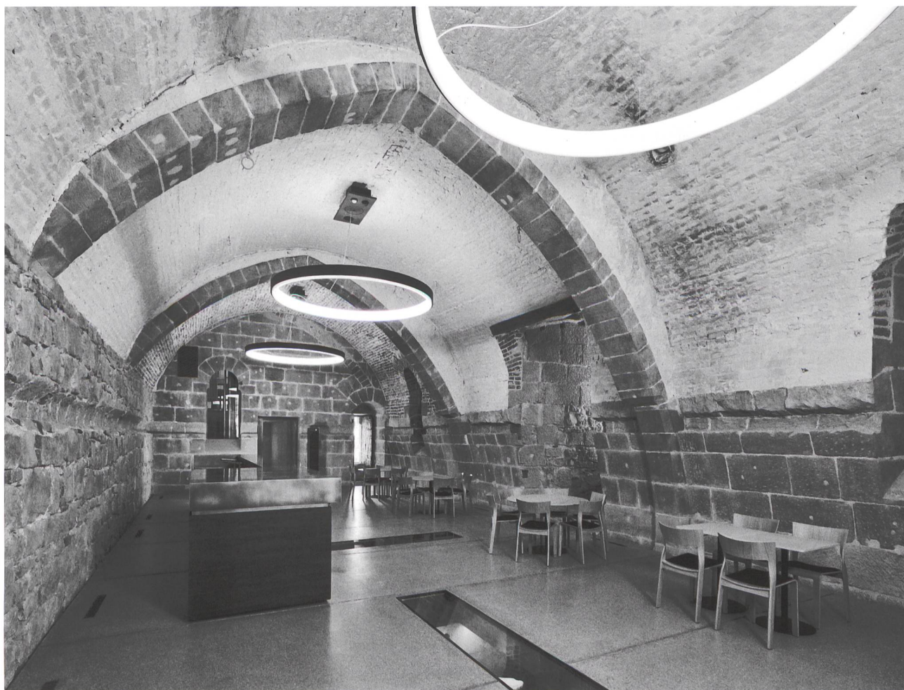
3: Lausanne, Saint-Maire. Arc-doubleau brisé en pierre construit sous de Menthonay, dans la cave nord. Il a été conservé par Challant, malgré l'aménagement sous sa direction de la voûte en plein-cintre en briques.
