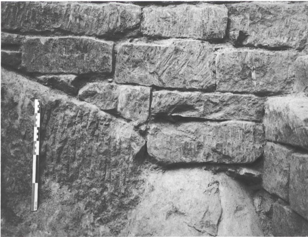
11: Lausanne, maison Charbon. Vue d'une paroi de la citerne avec le socle rocheux taillé.
