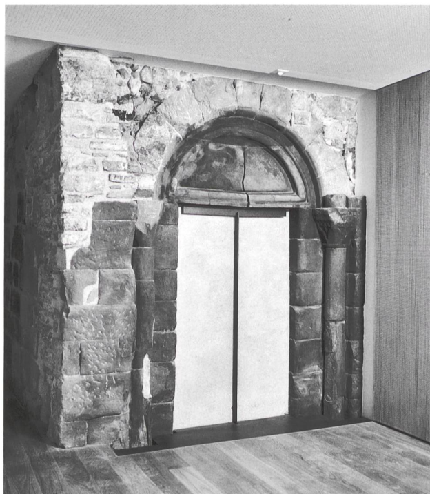
17: Lausanne, maison Charbon. Porte du 1 er étage de la face orientale de la tour.
