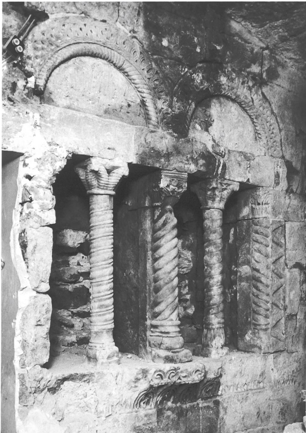
25: Château de Neuchâtel. Baie de l'ancienne façade orientale au moment de sa découverte en 1913.
