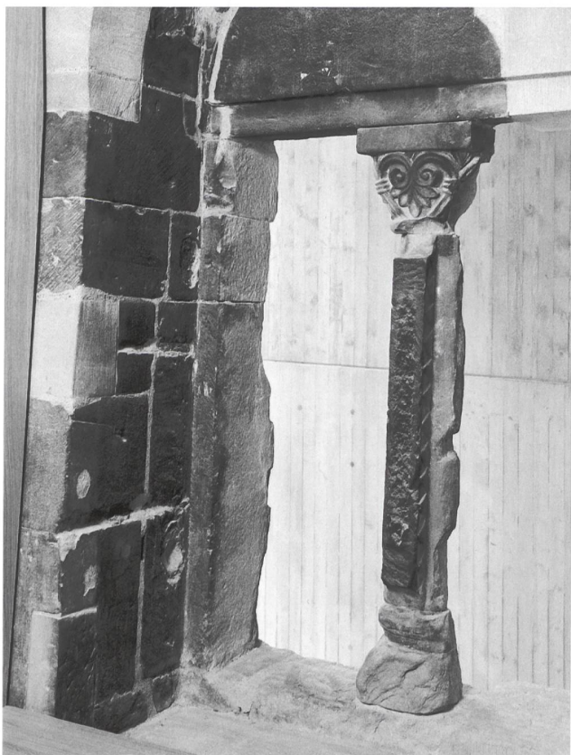
22: Lausanne, maison Charbon. Vue intérieure de la baie orientale de la façade sud.
