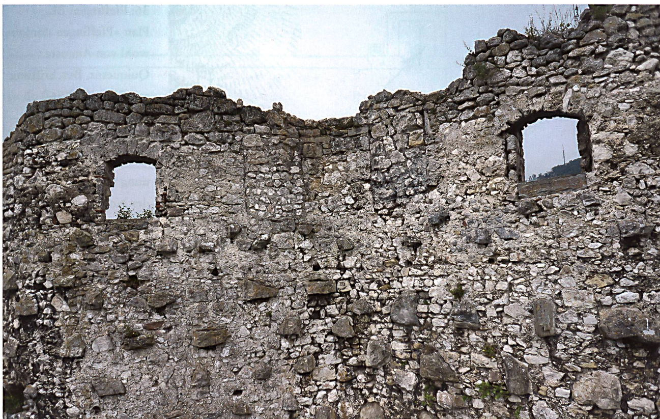
35: Pfeffingen BL. Nordmauer des Wohnturms, Ansicht von Norden. Bei der Erhöhung der Nordmauer wurden die Zinnenzwischenräume entweder zu Fenstern umgebaut oder zugemauert. Die heute vorhandenen Zumauerungen stammen allerdings von der Sanierung in den 1930er Jahren, nachdem die Zinnenzwischenräume wieder geöffnet worden waren. Foto 2012 vor der Sanierung.
