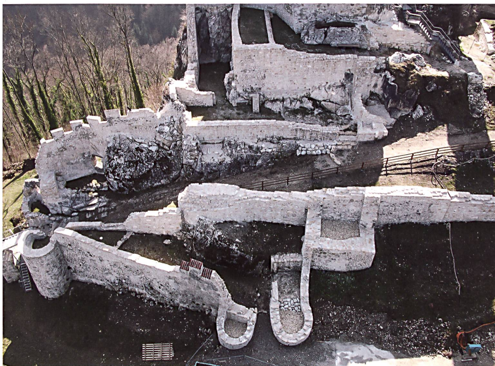
33: Pfeffingen BL. Übersicht des östlichen Bereichs der Burganlage. Im Vordergrund das Nordtor mit der östlich anschliessenden Nordostmauer, die zum Osttor läuft. Im Hintergrund links die südwestlich an das Osttor anschliessende südöstliche Umfassungsmauer. Foto nach der Sanierung 2016.
