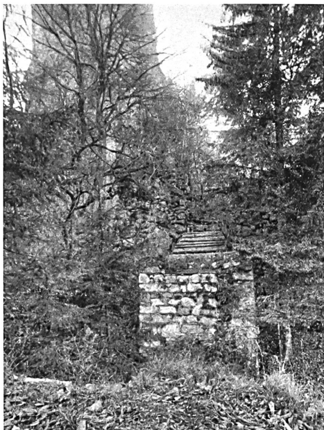
49: Pfeffingen BL. Ostzugang mit dem Pfeiler der Brücke. Fotografie von Rudolf Fechter 1897.
