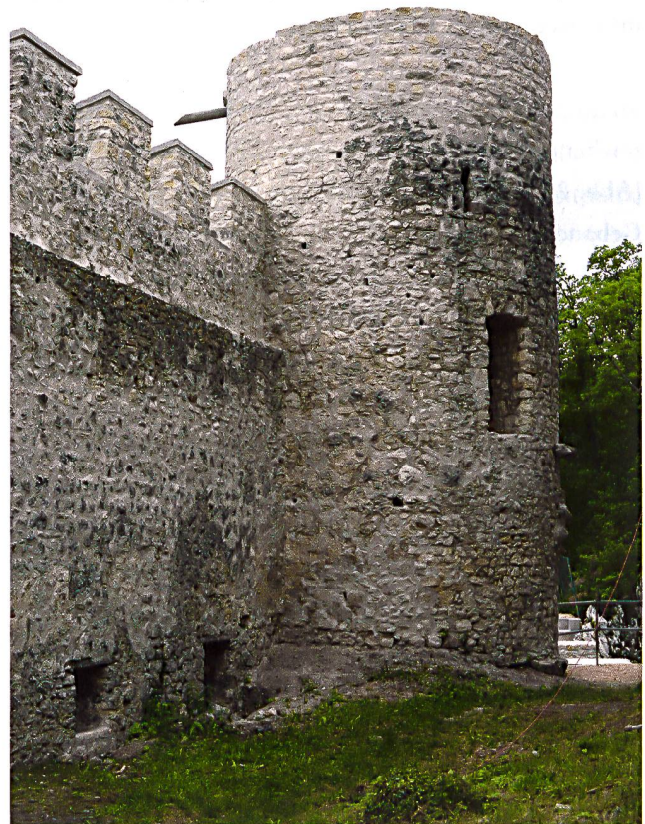
27: Pfeffingen BL. Hexenturm nach der Sanierung 2017.
