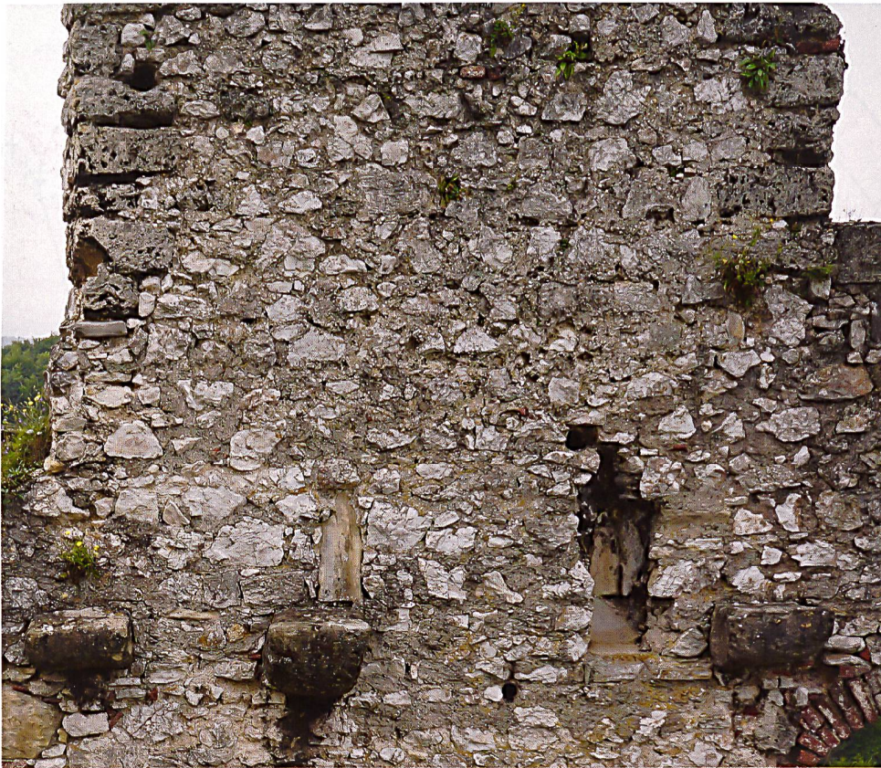
17: Pfeffingen BL. Südostecke der Innenseite des Wohnturms. Bei den senkrecht stehenden in das Mauerwerk ein- gelassenen Sandsteinen handelt es sich wohl um die Reste der seitlichen Wangen eines offenen Kamins, Zustand 2012 vor der Sanierung.
