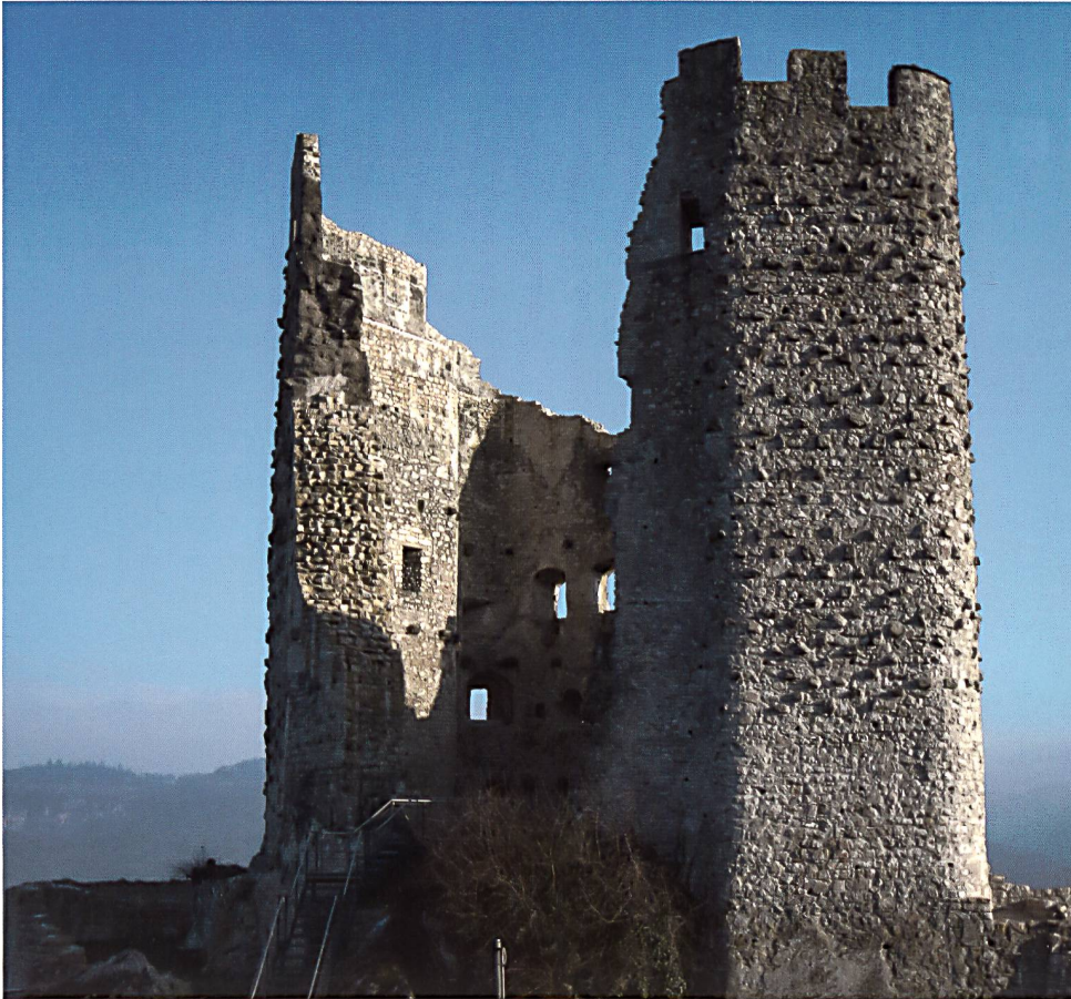
13: Pfeffingen BL. Ansicht des Wohnturms von Westen. Aufnahme nach der Sanierung, 2017.
