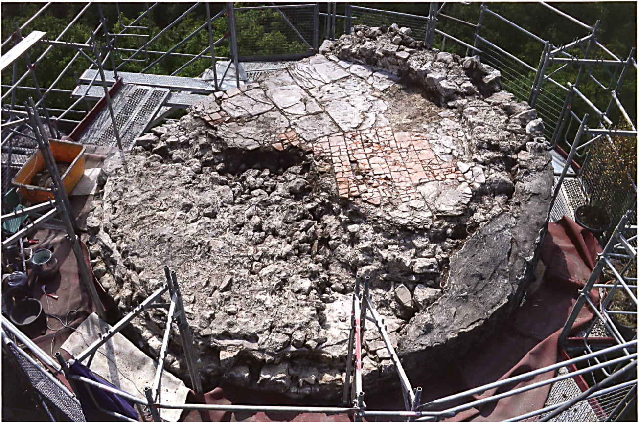
28: Pfeffingen BL. Hexenturm, Reste des Bodenbelags der Wehrplattform und der Brüstung über dem Gewölbe im Obergeschoss. Blick nach Süden.
