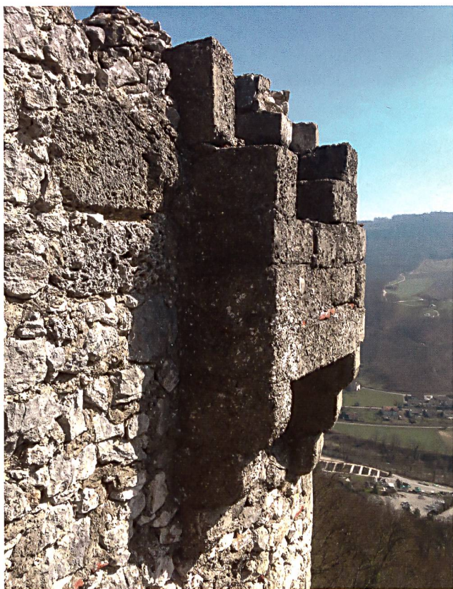
51: Pfeffingen BL. 1931 aus Betonsteinen rekonstruierter Aborterker an der Südseite des Wohnturms. Aufnahme vor der Sanierung 2013.
