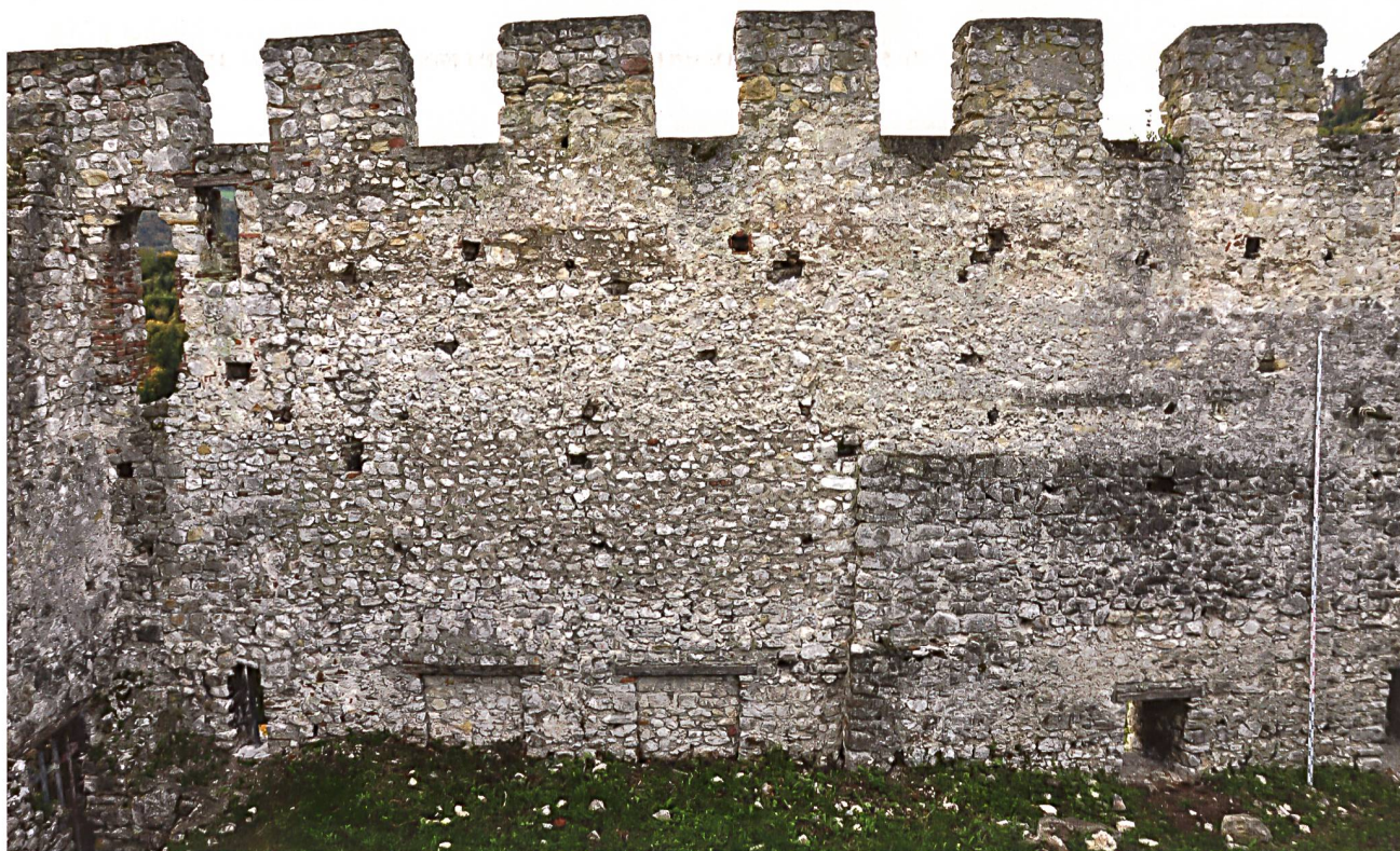
23: Pfeffingen BL. Östlicher Teil der Innenseite der südlichen Zwingermauer. Ansicht von Norden, Zustand vor der Sanierung.
