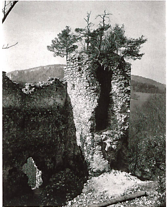
26: Pfeffingen BL. Hexenturm vor der Sanierung 1931.
