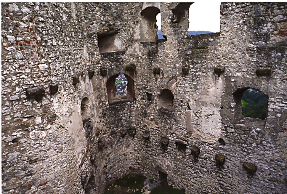
16: Pfeffingen BL. Nordostecke des Wohnturms, 2012 vor der Sanierung. Im ersten Obergeschoss das nach Osten gerichtete Fenster der Kapelle mit den beiden seitlichen Fenstern. Im darüber liegenden Geschoss die Geschützscharte von 1458.
