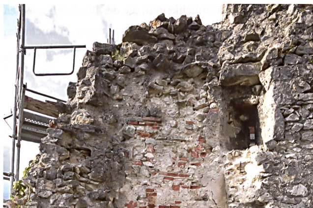
39: Pfeffingen BL. In die südliche Giebelwand des «alt geheüss» wurde beim Einbau eines offenen Kamins ein Rauchabzug eingearbeitet. Blick von Norden.
