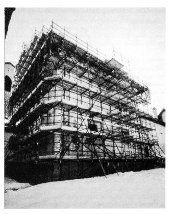
15: Müstair GR, Plantaturm. Der Turm während der statischen Sanierung. Das Spezialgerüst dient gleichzeitig als «Korsett».
