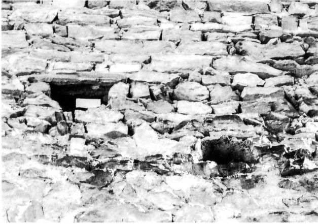
15: Ober-Ruchenberg GR. Innenansicht der östlichen Turmmauer. Fotografie steil aufwärts, deshalb Durchsicht durch den schräg nach oben ziehenden Abzugsschacht, tiefer rechts Auflagerloch des südlichen Unterzugs.
