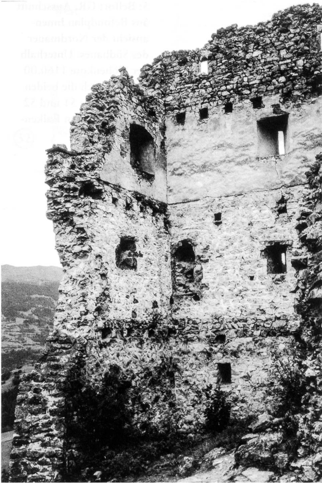
4. Belfort GR. Blick in die Südwestecke des Südtraktes. Die Kanalöffnung liegt unterhalb des Stichbogenfensters auf Unterkanthöhe des deckenden Verputzes in der Südmauer (links; 1999).
