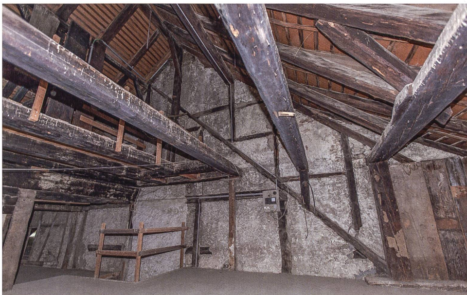
9: Lenzburg, Rathausgasse 9. Östliche Giebelwand M24 im westlichen Hausteil. Dachlinie und Ständerkonstruktion des Kernbaus mit Erweiterung des Daches von 1709/10d.
