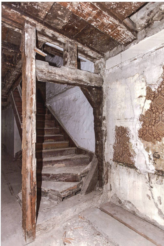
4: Lenzburg AG, Rathausgasse 9. Die zum spätmittelalterlichen Kernbau gehörende Riegelwand M15 im 2. OG des östlichen Hausteils (Ostwand), Ansicht von SW.
