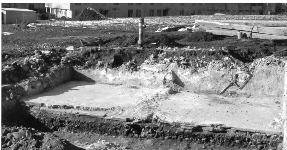
25: Küssnacht SZ, Untere Burg 2014. Profil P11. Aufnahme 2015. Blick von SE.
