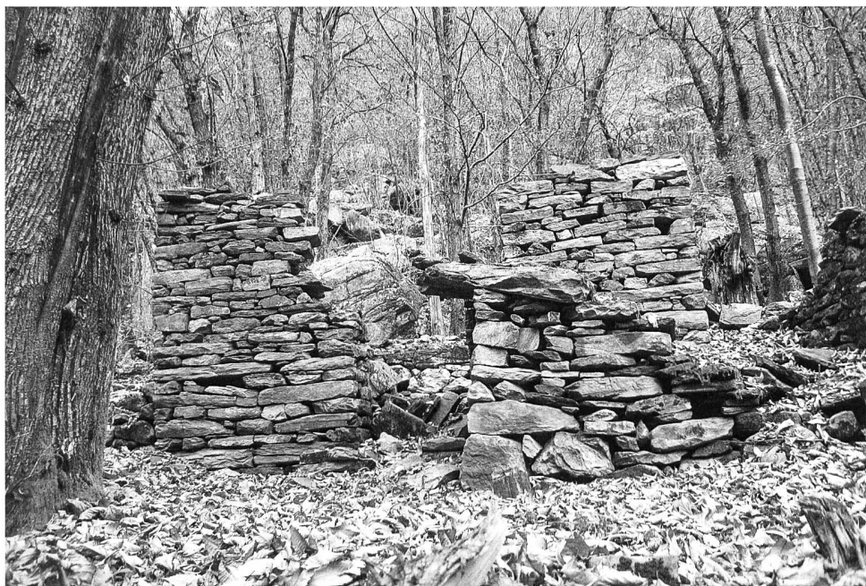
7: Scandürasča, Lavertezzo. Facciata di una stalla: si riconoscono la base della scala e la predella che davano accesso al piano rialzato, quello destinato al foraggio.
