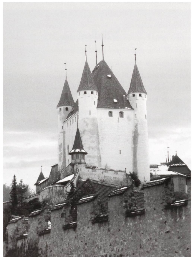
4: Schloss Thun über der gleichnamigen Stadt. Der Gestus des zähringischen grossen Turms ist noch heute spürbar. Das manifestiert sich schon von weitem: Das Bauwerk ist kilometerweit zu sehen. Aber auch aus der Nähe beeindruckt das massive Mauerwerk mit seiner unregelmässigen Oberfläche, das aus grob zugerichteten Steinen besteht und nur von wenigen, kleinen Öffnungen durchbrochen wird.
