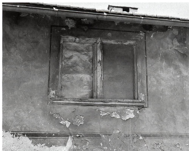
10: Maison Guerrati, façade nord. Détail de la fenêtre au cadre mouluré du 2 e étage, avant les travaux de 2001 – Detail des Fensters in der Nordfassade mit Dekorationsmalerei auf dem Verputz.
