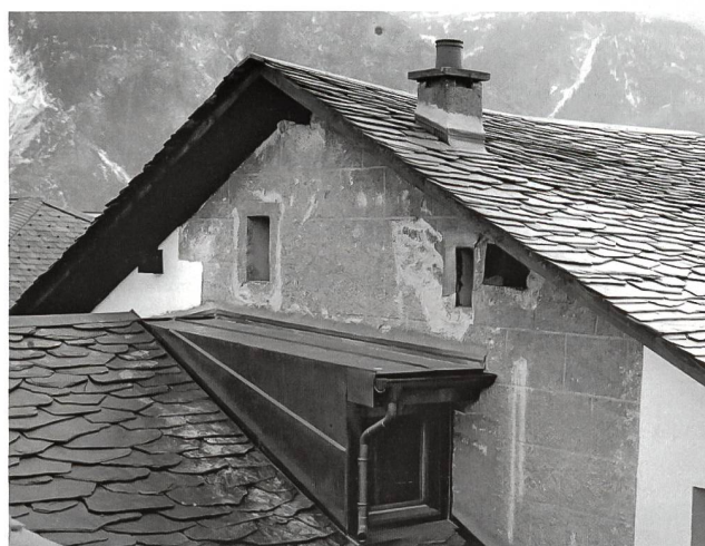
12: Maison Guerrati, pignon oriental après le dernier agrandissement de la maison (phase 3). Détail du crépi à faux-joints imitant un ouvrage en pierre de taille – Ostgiebel nach der letzten Vergrößerung des Hauses (Phase 3). Detail des Verputzes mit Fugenstrich, ein Quadermauerwerk imitierend.
