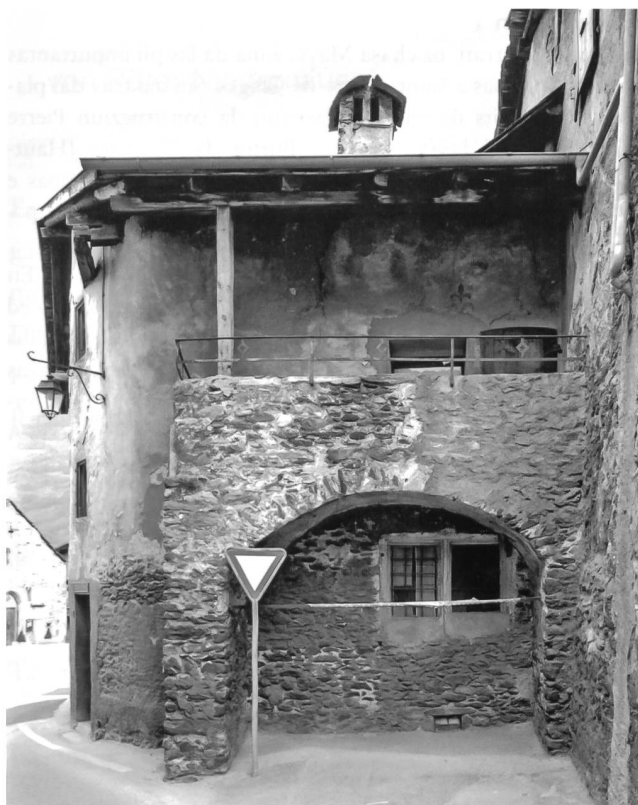
13: Maison Guerrati, façade nord. Le balcon maçonné ajouté en phase 4, avant les travaux de 2001 – Der gemauerte Balkon in der Nordfassade wurde in Phase 4 angebaut, Zustand vor den Sanierungsarbeiten.
