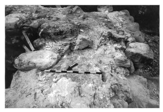
12: Auf der Mauerkrone des Bergfrieds fanden sich nach der Reinigung Reste einer verschmutzten Mörteloberfläche, die als sogenannte Wintergrenze einen Bauunterbruch markiert. Befundaufnahme von 2007.
