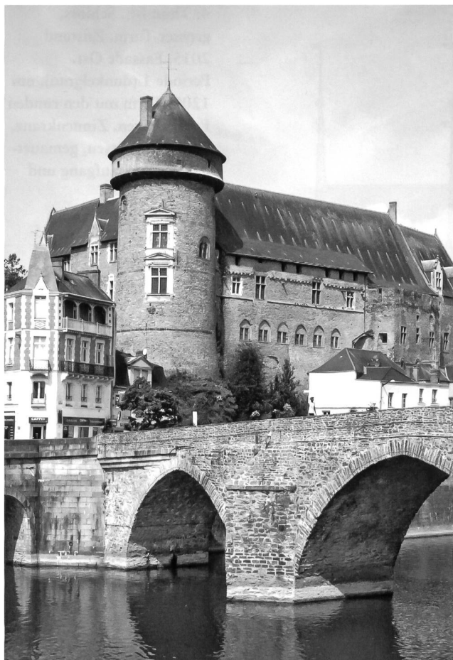
5: Laval, Dep. Mayenne (F). Der Donjon an der Südwestecke der Burg mit dem hölzernen Hurdengeschoss mit Kegeldachabschluss, dendrochronologisch in die Zeit um 1220 datiert.
