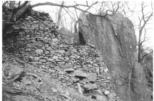
17: Val Bavona, Sott Piodau Lüera. Südmauer von aussen. Blick gegen Nordwesten.
