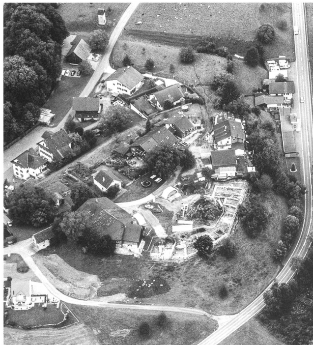
3: Meienberg AG, Blick nach Osten. Flugaufnahme 2005.
