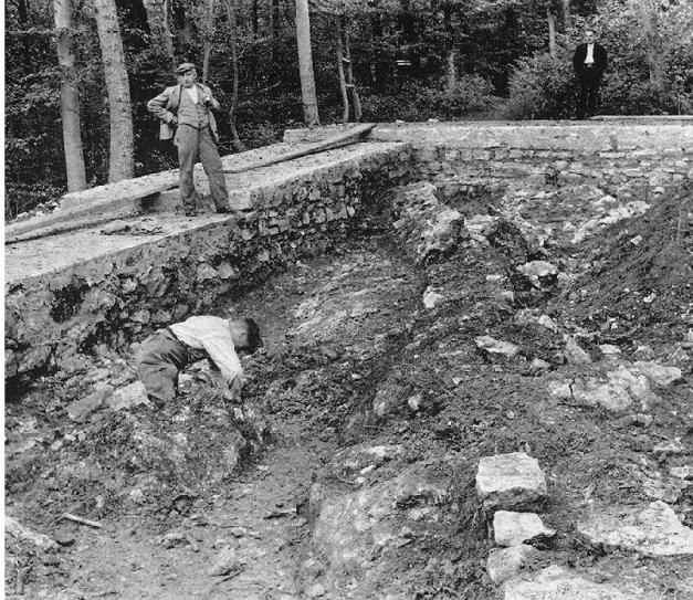
3: Burgruine Ottersbühl, Innenansicht der NW-Ecke mit Mauerzug eines Vorgängerbaues während der Ausgrabung 1935.
