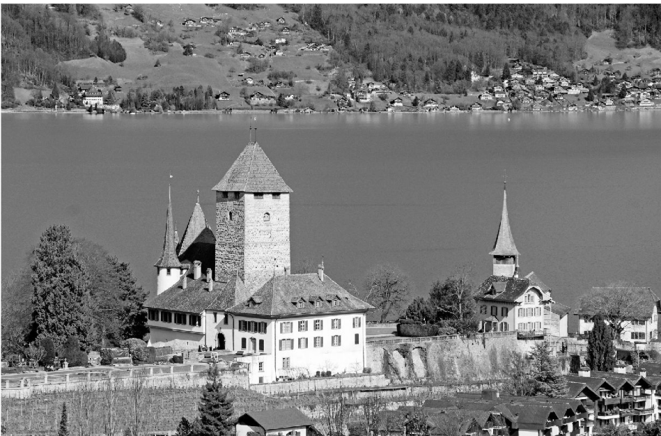
1: Ansicht des Schlosses Spiez von Nordwesten. Links die Burg, rechts, teilweise verdeckt, die Kirche. Aufnahme 2011.
