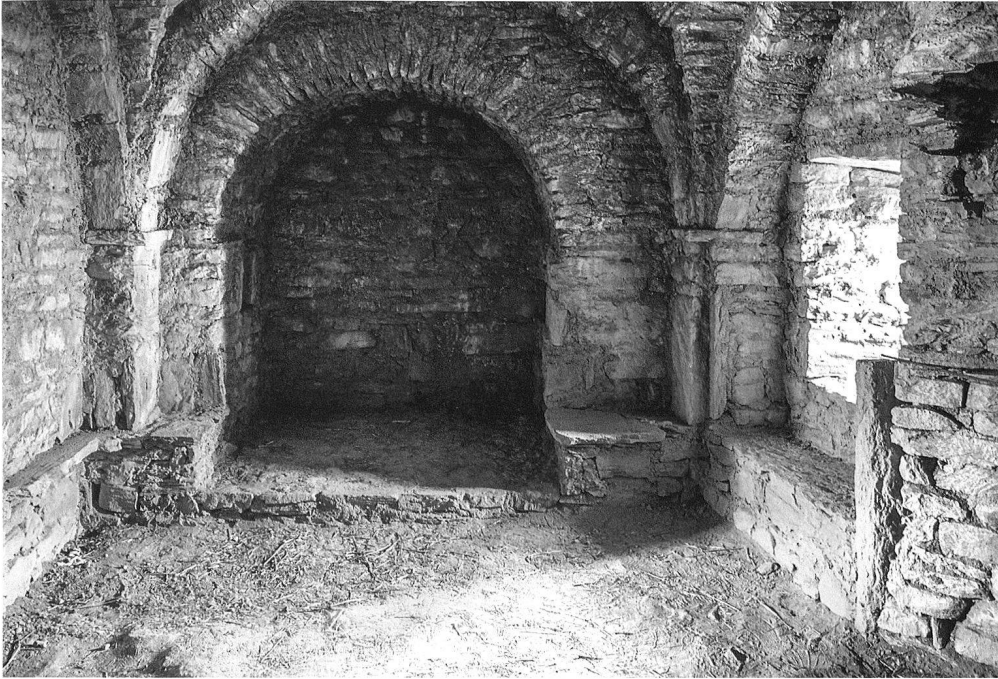
7: Burg Sta. Maria in Calanca. Obergeschoss mit Gewölbeansätzen, Fenster-nische und umlaufenden Steinbänken.
