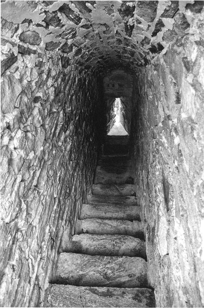
9: Burg Sta. Maria in Calanca. Tonnengewölbte Treppe in der Mauerdicke.
