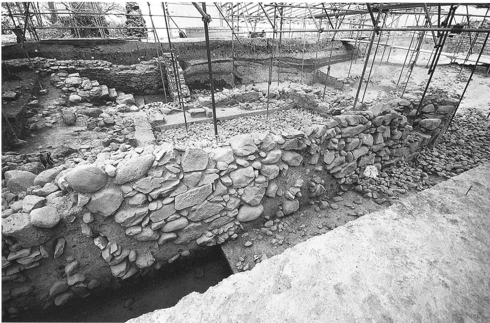
11: La façade ouest de la domus plana : les négatifs des poutres verticales soutenues par des bras de force sont bien visibles.
