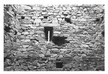
12: Ausbruch in der Nordmauer für das neue Lager für den Hauptbalken des Geschossbodens der zweiten Phase.
