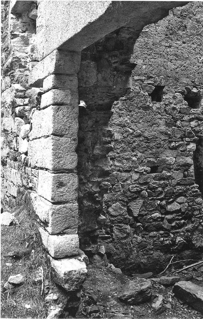
14: Ansicht Gewändesteine östlicher Eingang im Erdgeschoss, um 1970.
