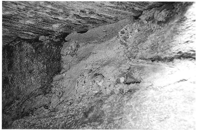
19: Rosa gefärbter Mörtelverputz in der Scharte, Detail.
