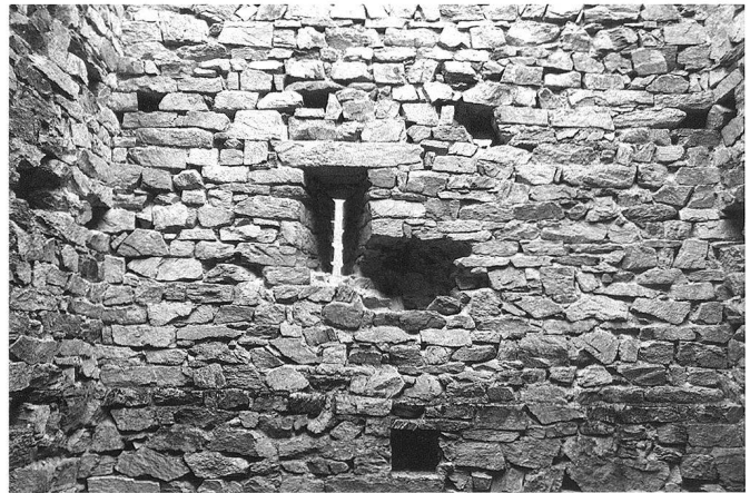
12: Ausbruch in der Nordmauer für das neue Lager für den Hauptbalken des Geschossbodens der zweiten Phase.
