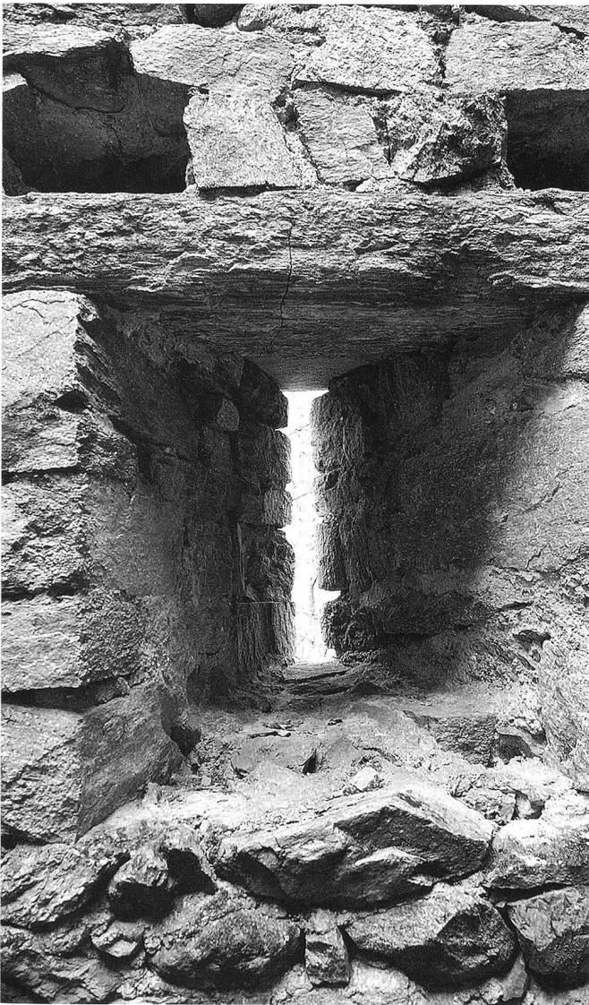
18: Rosa gefärbter Mörtelverputz in einer Scharte.
