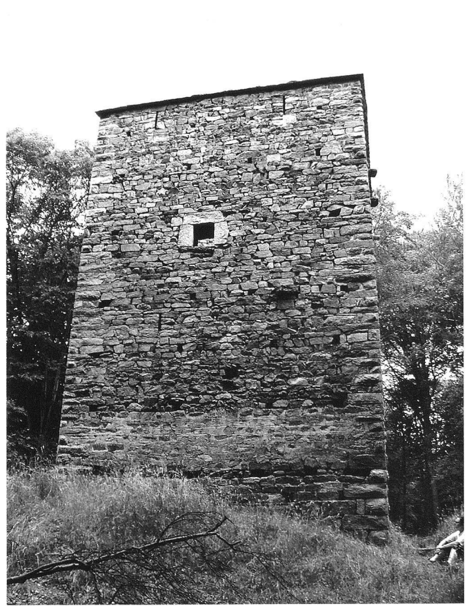
2: Der Wohnturm von Westen, mit monolithischem Fenstergewände und Sturz.
