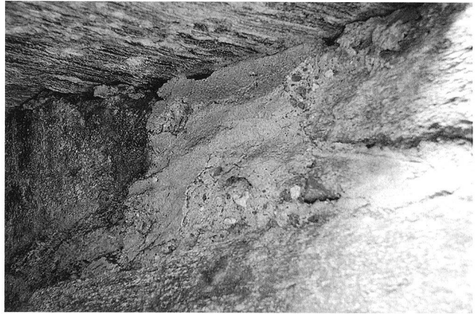
19: Rosa gefärbter Mörtelverputz in der Scharte, Detail.
