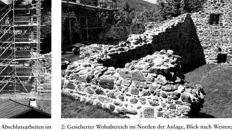
2: Gesicherter Wohnbereich im Norden der Anlage, Blick nach Westen; Gehhorizont ursprünglich tiefer; links Balkenlöcher einer Geschosslage; Westwand: zwei Schartenfenster und rechts oben schräger Rauchabzugkanal (Foto Jürg Rusch, BVG).
