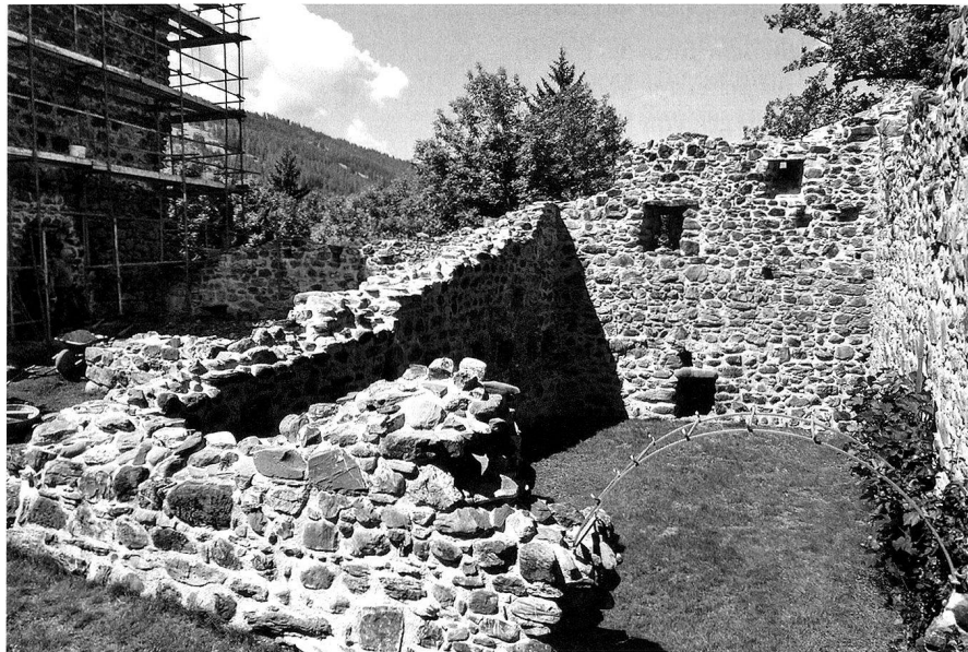
2: Gesicherter Wohnbereich im Norden der Anlage, Blick nach Westen; Gehhorizont ursprünglich tiefer; links Balkenlöcher einer Geschosslage; Westwand: zwei Schartenfenster und rechts oben schräger Rauchabzugkanal (Foto Jürg Rusch, BVG).
