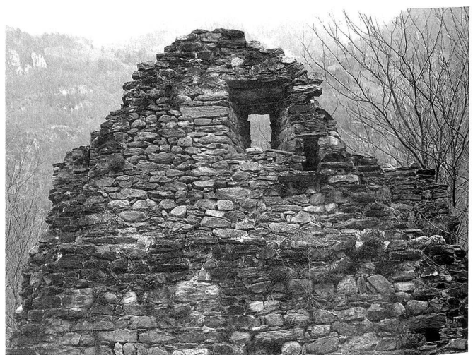
8: Palas, Ostinnenwand mit Fenster und Ausguss, Blick gegen Osten.
