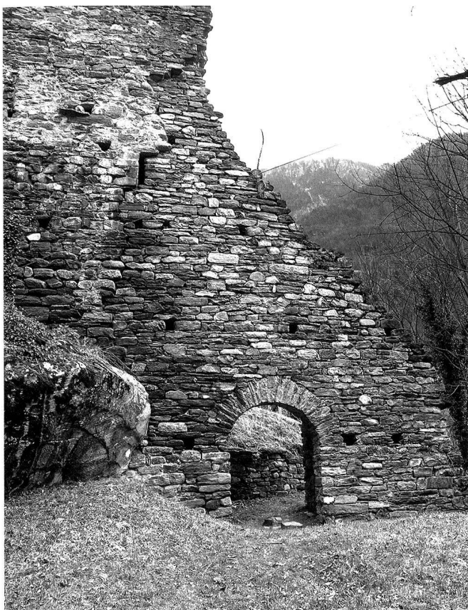
2: Rekonstruktion der Südwestecke durch Eugen Probst 1934, Blick gegen Osten.
