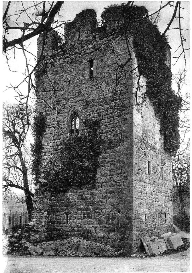
1: Der Hexenturm in Sempach vor der Restaurierung 1936, Blick nach Nordosten.
