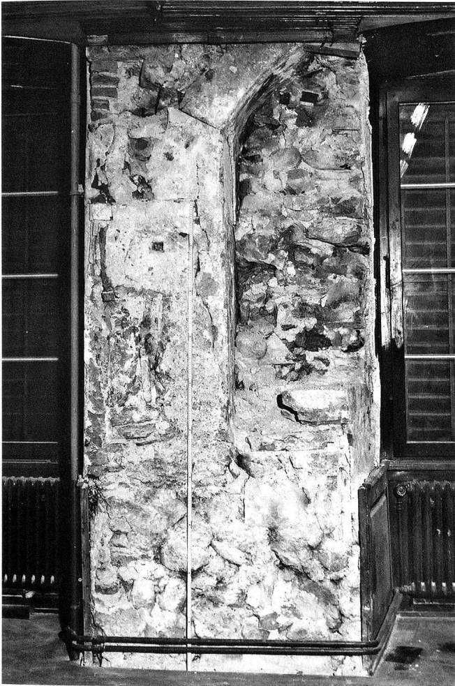
4: Murihof Sursee, 1. Obergeschoss, Westwand. Reste einer Fensternische.
